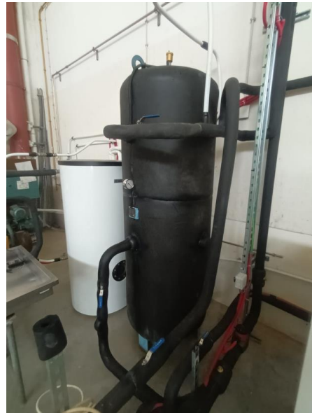
Figura 4.24 - Ligação em T à entrada e saída do depósito de pasteurização.
