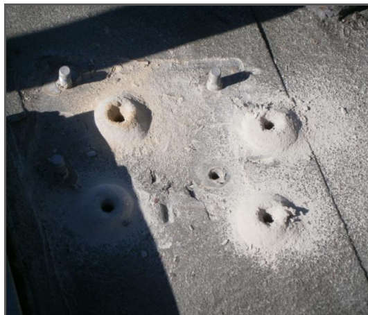
Figura 19 – Furação em laje de cobertura para reparação do ponto de ancoragem
