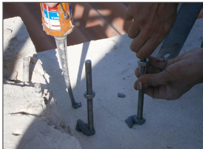
Figura 23 – Preenchimento dos furos com bucha química e colocação dos varões roscados
