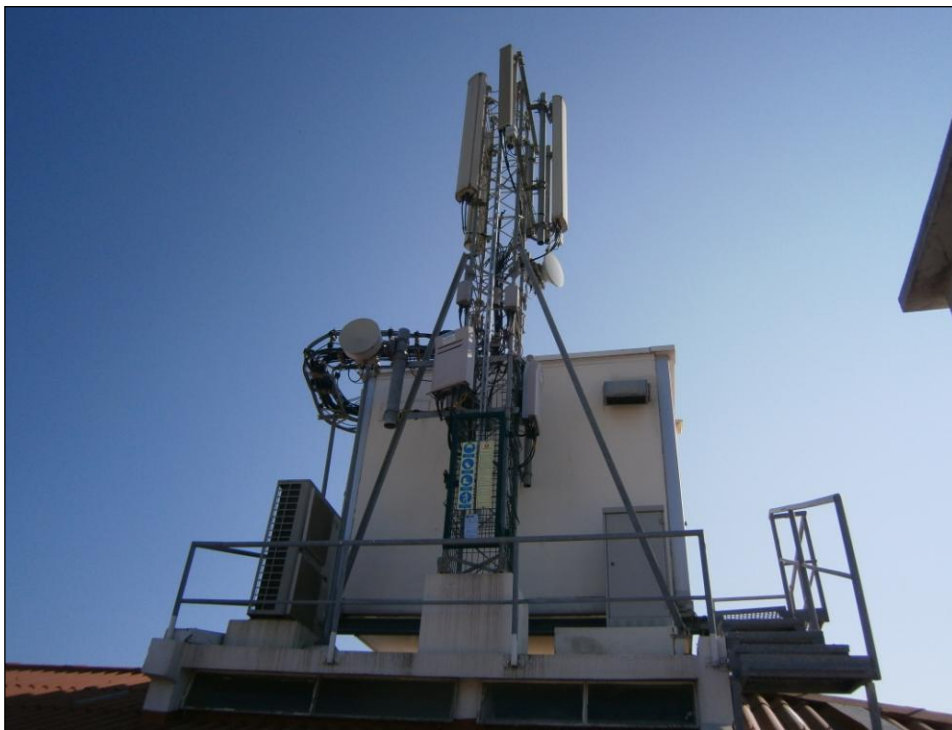
Figura 2 - Torre metálica treliçada escorada
