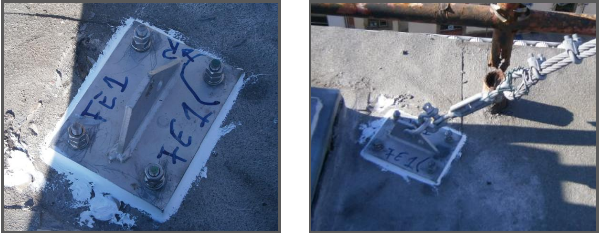
Figura 21 – Aspeto final da ancoragem reparada e com a espia recolocada
