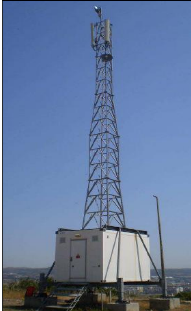
Figura 3 – Torre metálica autosuportada transportável
