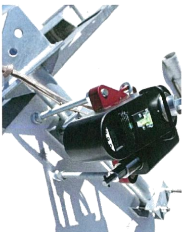
Foto 1: Ensaio de tracção a aparelho de fixação de espas em platibanda de cobertura de edificio (FE1).
