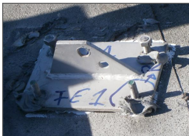
Figura 20 – Colocação de varões roscados e chapa metálica após aplicação de bucha química
