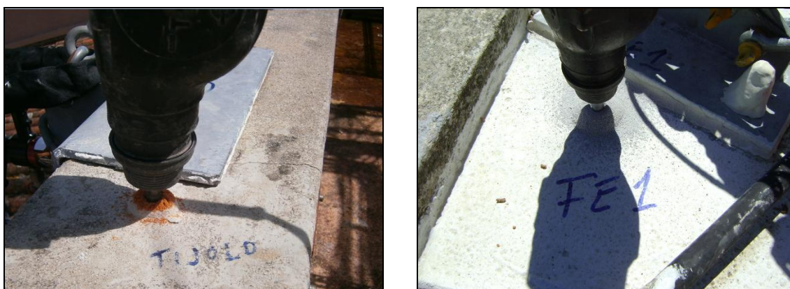
Figura 15 – Furação em murete de alvenaria e em maciço de betão
