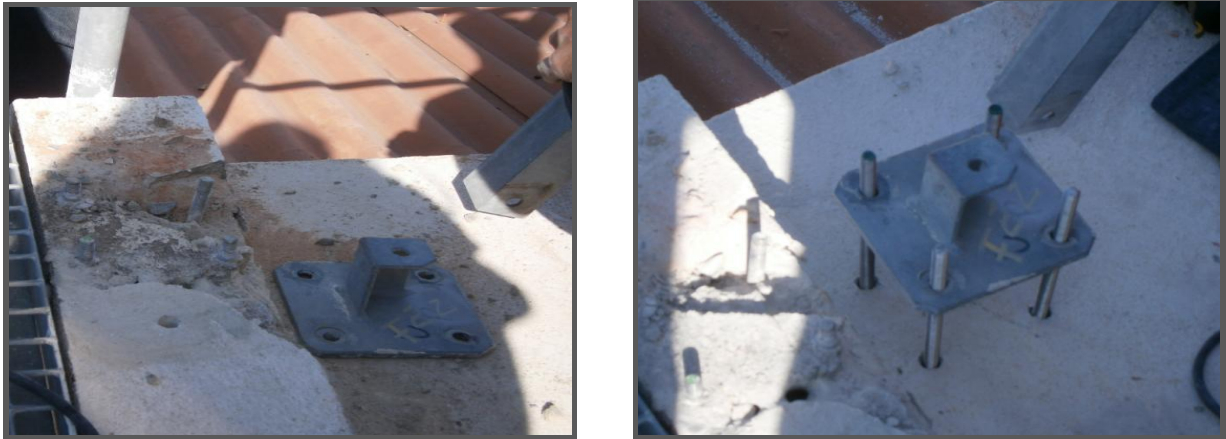
Figura 22 – Desativação da ancoragem existente e preparação da nova localização
