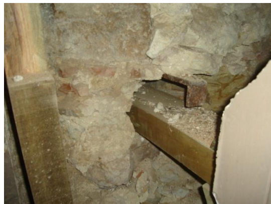
Figura 2.10 - Entrega de viga do pavimento
