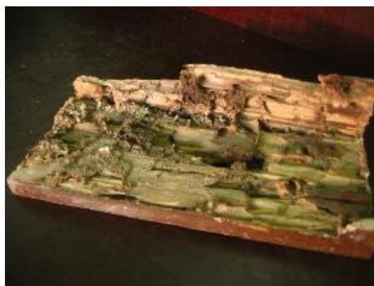
Figura 2.14 - Madeira degradada por térmitas subterrâneas (Cruz, 2010)
