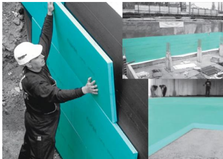
Figura 3-5 – Aplicação de Isolamento térmico (fonte: Polirigido 2018)
