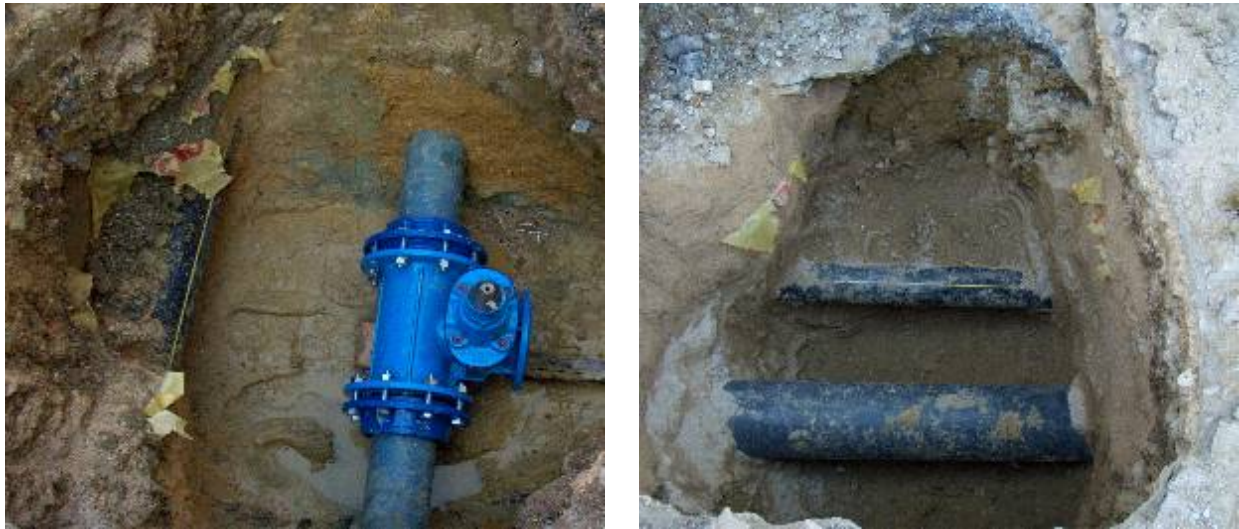
Figura 5.13 – Conduitas de gás.
