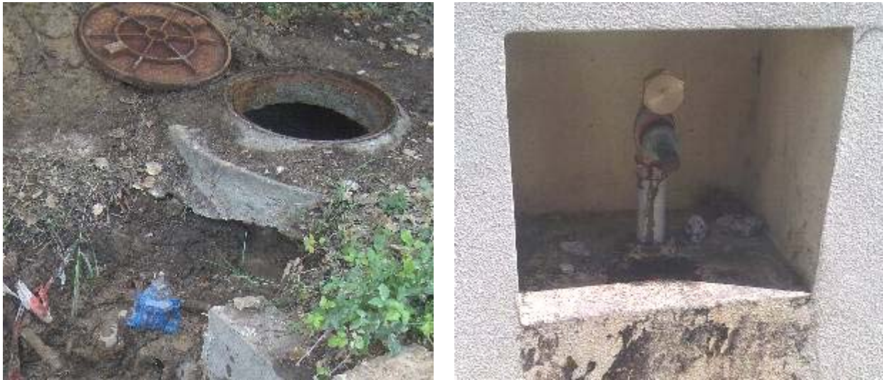
Figura 5.16 – Reparação de fuga em ramal e boca-de-incêndio.
