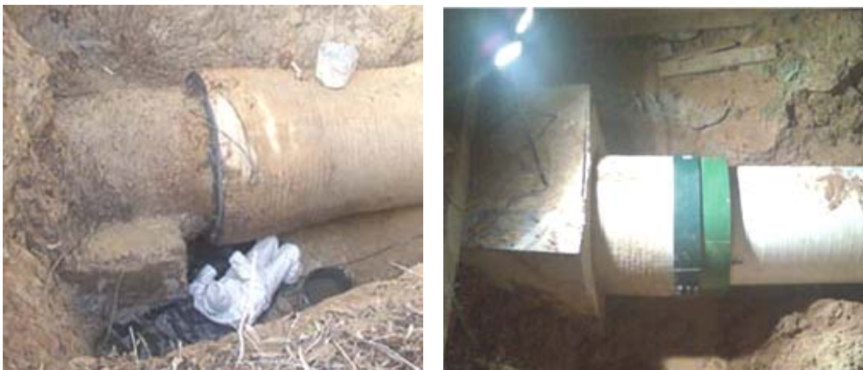
Figura 5.25 – Reparções de fugas na conduta. (Fonte: SMAS – Sintra)
