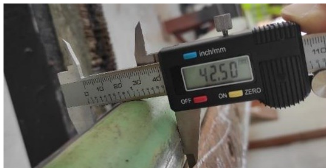
Figura 36 – Medição da dimensão do bolbo da estanquidade da margem direita do DC01, observando-se uma deformação permanente do bolbo maior que na estanquidade da margem oposta – 42.5mm
