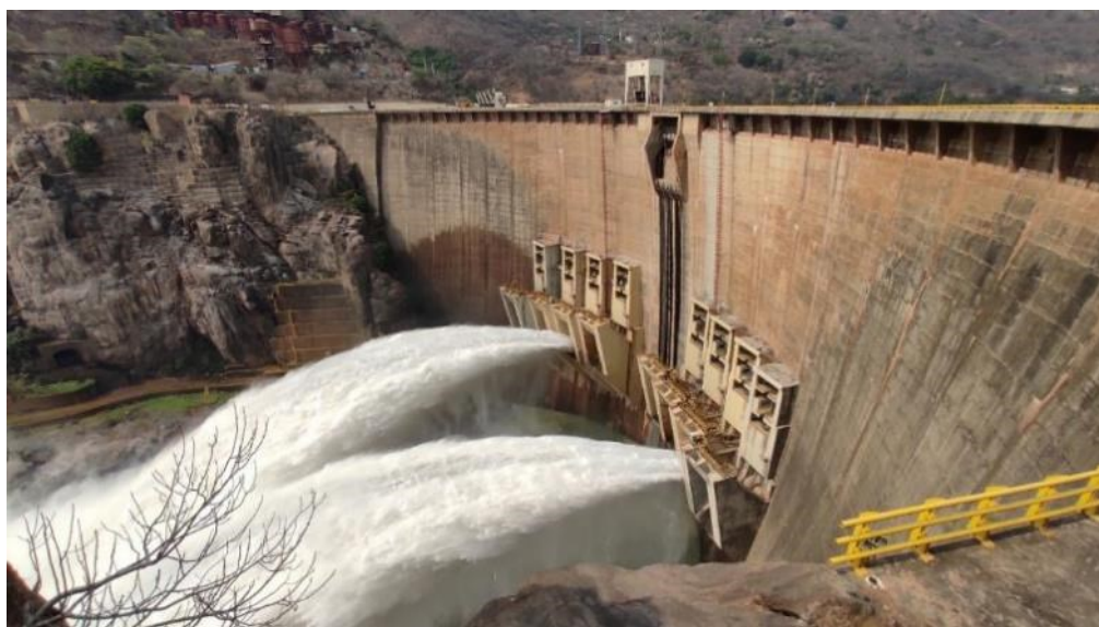
Figura 1 – Barragem com dois descarregadores abertos
