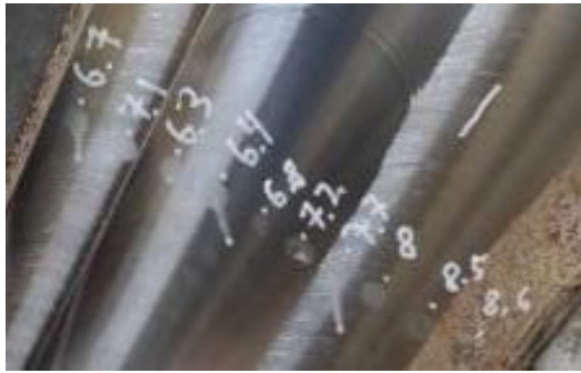
Figura 24 – Medição de espessuras – marcação de espessura remanescente (detalhe)
