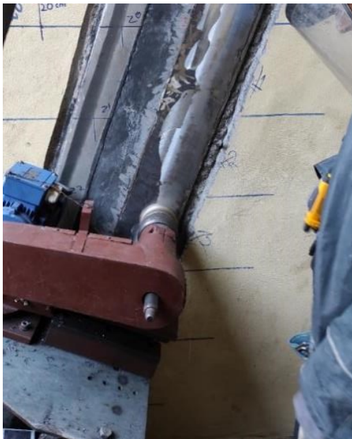
Figura 20 – Máquina nº1 instalada no topo da comporta a maquinar as peças fixas superiores.
