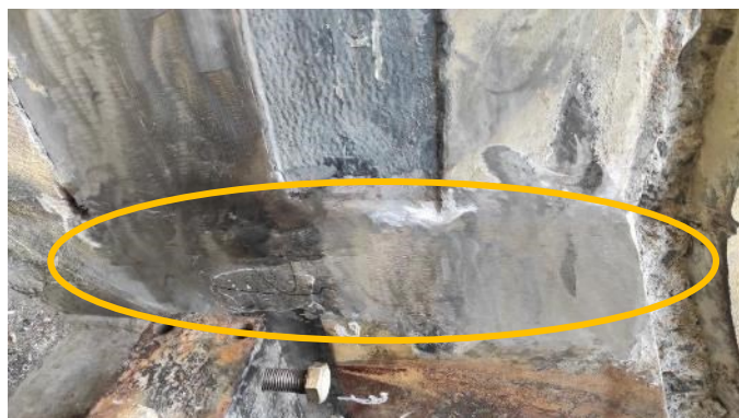
Figura 49 – Reparação de fissura – soldadura com elérodos revestidos E309 MOL
