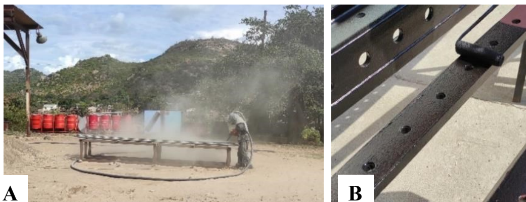
Figura 37 – A – Decapagem por jato abrasivo; B – Aplicação da proteção anticorrosiva
