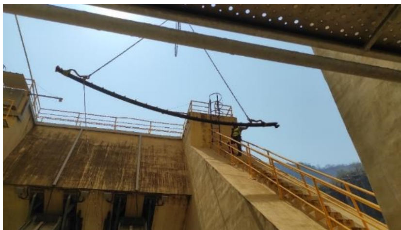
Figura 12 – Suspensão na grua do conjunto da estanquidade lateral
