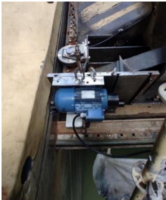
Figura 21 – Máquina nº2 – instalada na parte inferior da comporta a maquinar as peças fixas inferiores
