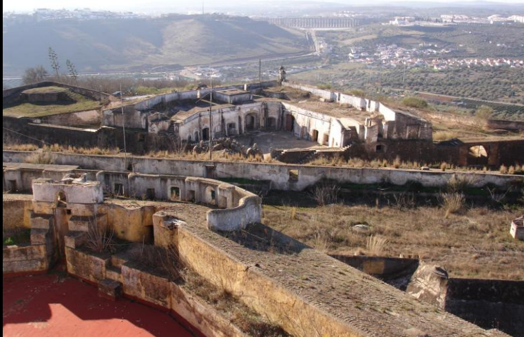
Vista geral da zona de entrada
