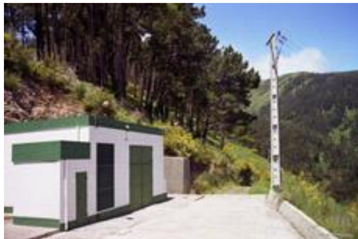
Figura 3.10 – Central Hidroelétrica do Lombo Brasil [25]
