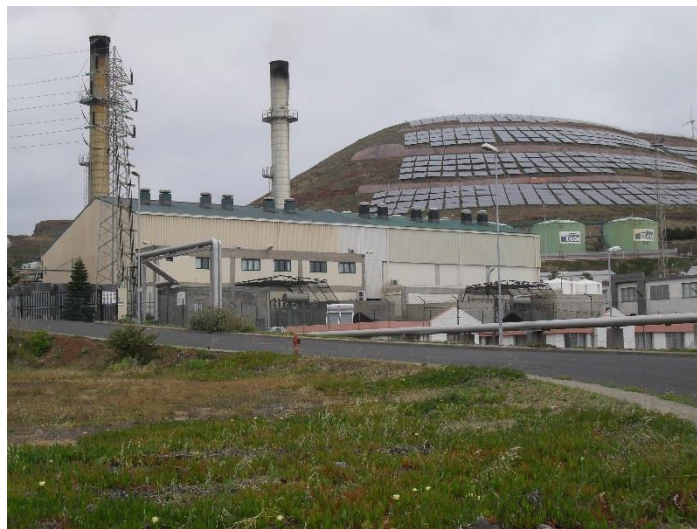
Figura 3.3 – Central Térmica do Caniçal
