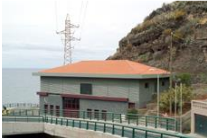
Figura 3.6 – Central Hidroelétrica da Calheta de Inverno [25]
