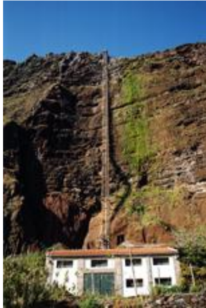
Figura 3.11 – Central Hidroelétrica da Fajã dos Padres [25]
