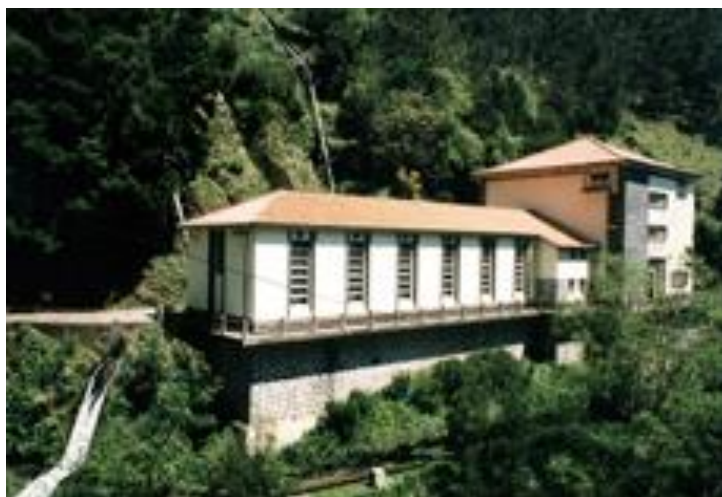
Figura 3.5 – Central Hidroelétrica da Calheta [25]
