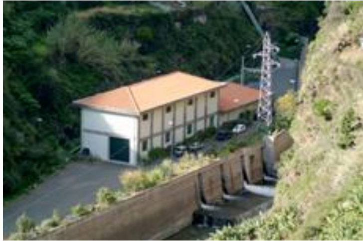
Figura 3.7 – Central Hidroelétrica dos Socorridos [25]
