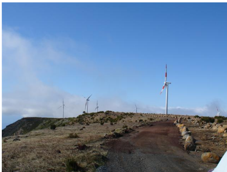
Figura 3.17 – Parque Eólica de Pedras [28]
