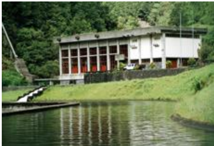
Figura 3.8 – Central Hidroelétrica da Fajã da Nogueira [25]
