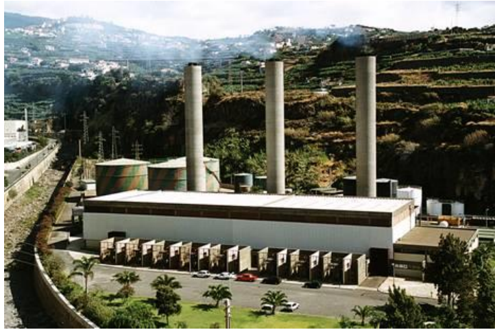
Figura 3.2 – Central Térmica da Vitória [24]
