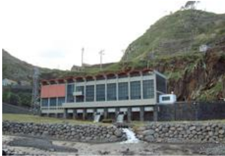
Figura 3.9 – Central Hidroelétrica da Ribeira da Janela [25]
