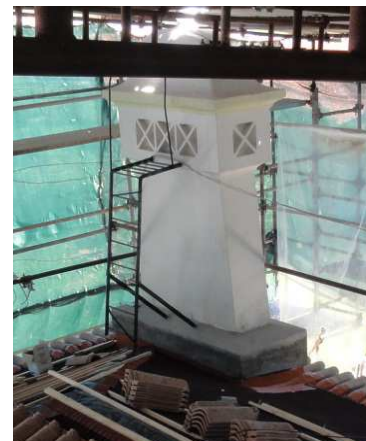
Figura 7 - Chaminé e escada
