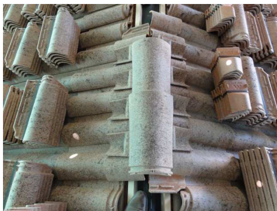
Figura 4 - Revestimento da cobertura
