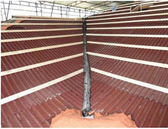
Figura 5 – Caleira de zinco
