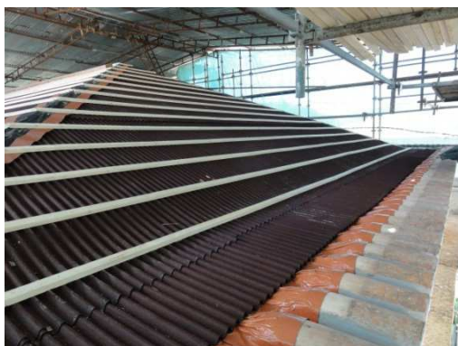
Figura 3 - Placas de subtelha e impermeabilização
