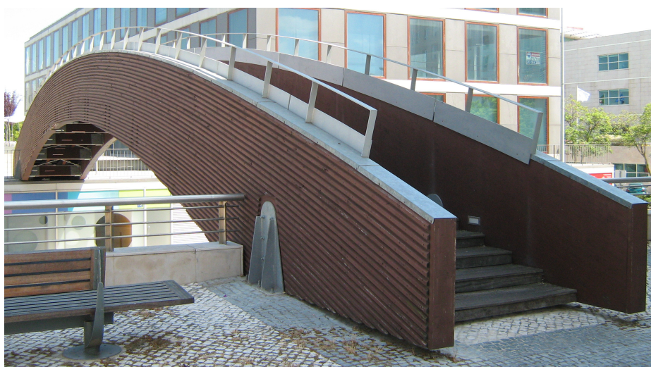
Ponte pedonal Parque das Nações (Lisboa)
