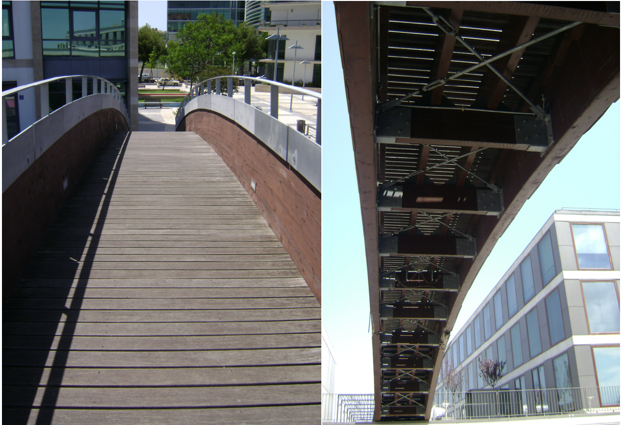
Figura 87 - Passadiço: parte superior, à esquerda; parte inferior, à direita (Almeida, 2013)
