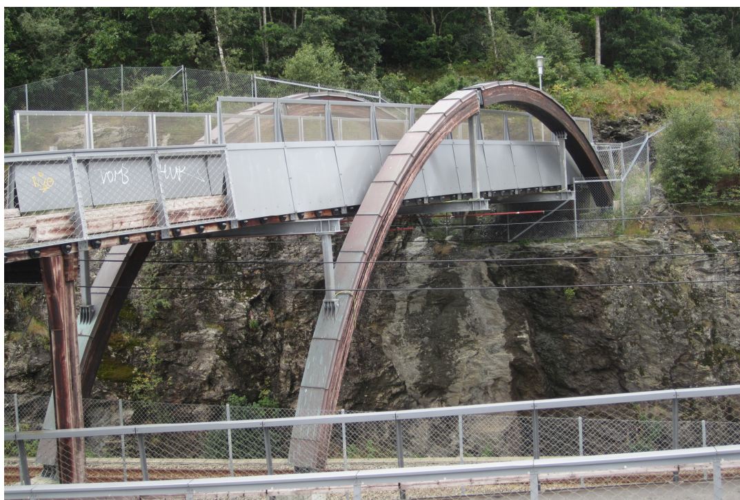
Figura 102 - Ponte Pedonal em Madeira Lamelada Colada - Stavanger – Noruega (Almeida, 2013)
