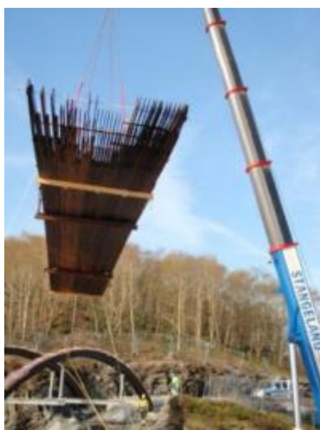
Figura 108 - Colocação do passadiço (Stangeland Maskin AS, 2009)
