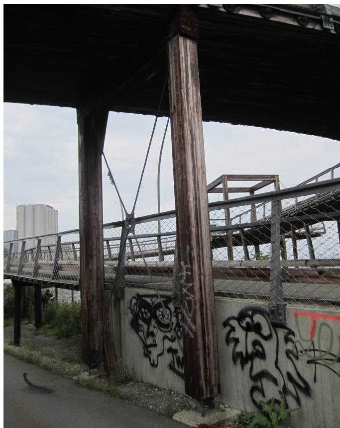
Figura 107 - Pilares da ponte (Almeida, 2013)
