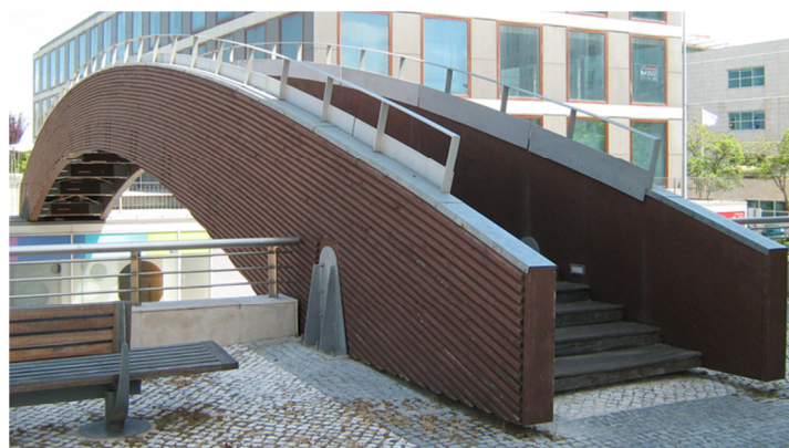
Figura 49 - Ponte Pedonal em Madeira Lamelada Colada - Parque das Nações – Lisboa (Almeida, 2013)
