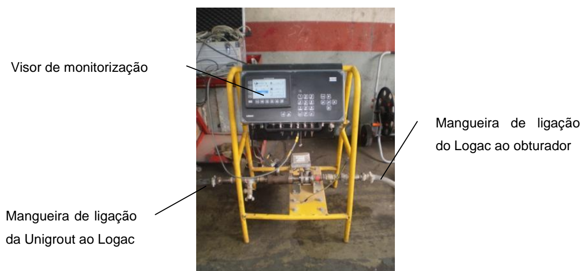
Figura 3.23 – Equipamento de monitorização e registo da pressão injectada na micro-estaca.
