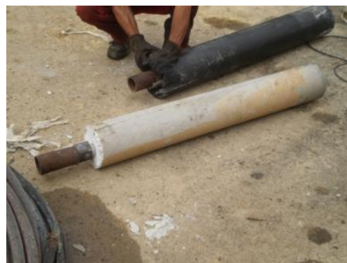
Figura 3.16 – Micro-estaca desmoldada e outra em fase de desmoldagem.
