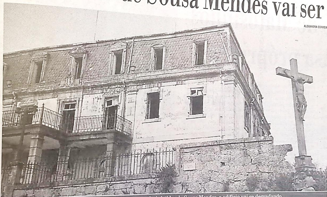
Enquanto não se decide em definitivo o futuro da casa de Aristides de Sousa Mendes, o edifício vai-se degradando
