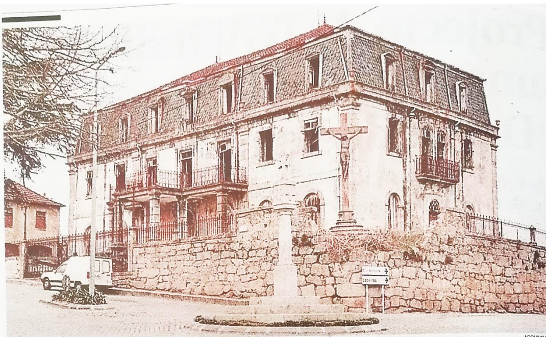
Um monumento em perigo: casa de Aristides de Sousa Mendes, em Cabanas de Viriato
