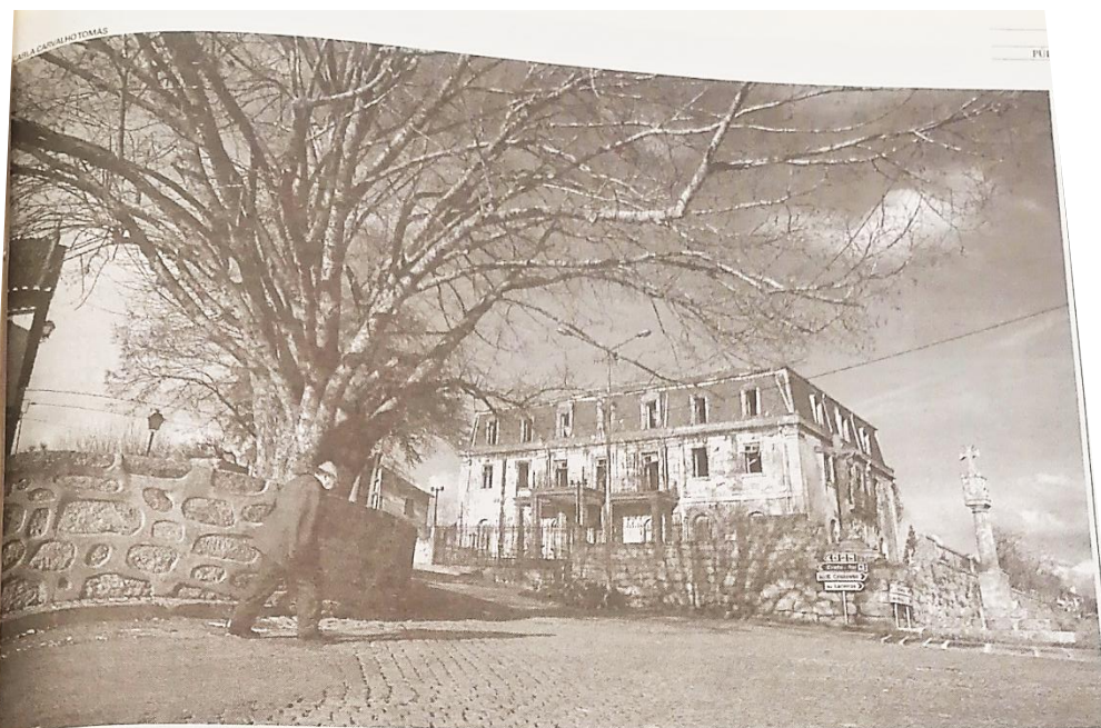
A casa do cônsul que facultou vistos a judeus fugidos do nazismo pode acolher a sede da fundação que lhe perpetua o nome
