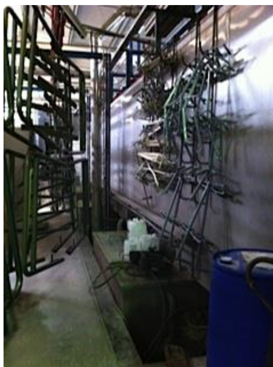
Figura 2.4 – Exterior do túnel de aspersão utilizado no tratamento das estruturas metálicas anterior à pintura
