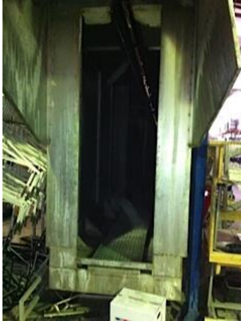
Figura 2.6 – Saída do túnel de aspersão utilizado no tratamento das estruturas metálicas anterior à pintura
