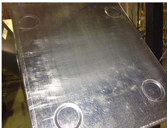
Figura 2.12 – Foto ilustrativa tentativa de, com recurso a abrasivos, melhorar a aderência da tinta à estrutura metálica
