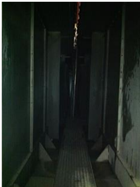
Figura 2.7 – Interior do túnel de aspersão utilizado no tratamento das estruturas metálicas anterior à pintura
