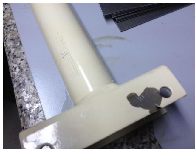
Figura 2.9 – Figura ilustrativa da falta de aderência da tinta à estrutura metálica com o método de fosfatação amorfa
