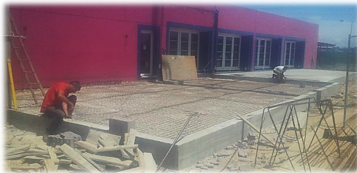
Figura 58 - Armadura AQ50 a ser colocada
