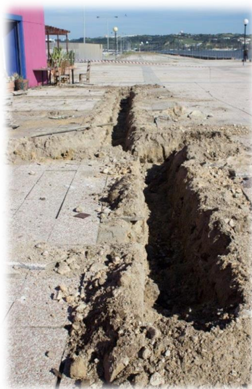
Figura 40 - Abertura de valas para elementos de fundação
