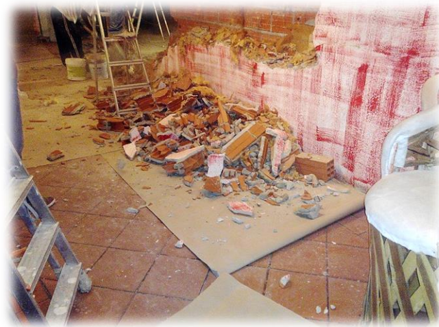
Figura 36 - Entulho proveniente da demolição
