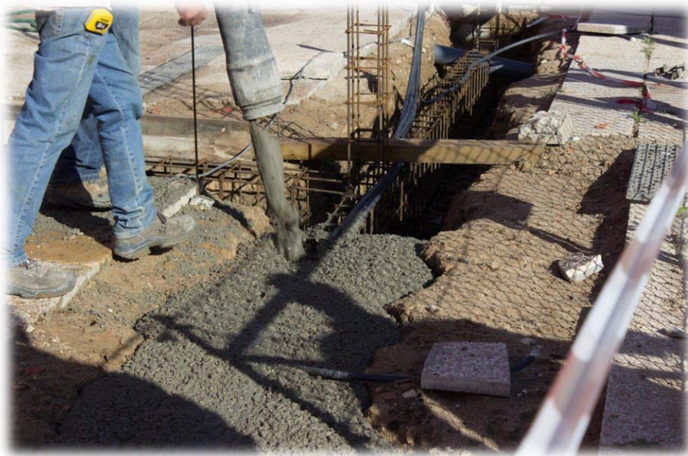
Figura 52 - Betonagem das fundações
