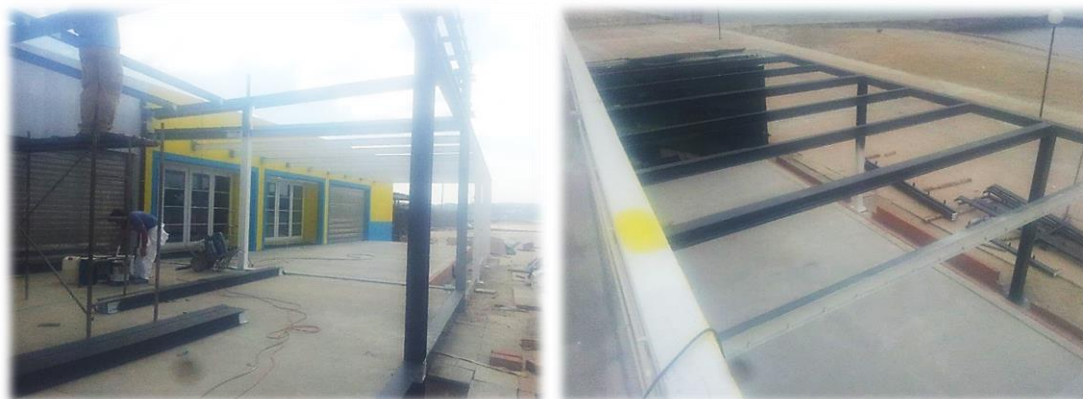
Figura 72 – Montagem da estrutura em conjunto com a pintura da mesma a tinta intumescente
