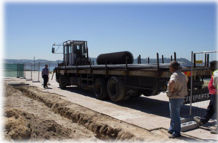
Figura 45 - Chegada do aço
