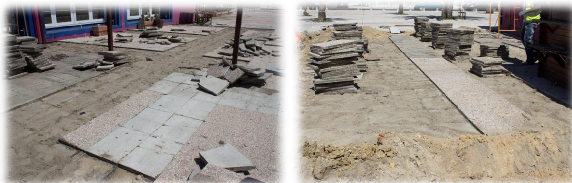
Figura 32 - Remoção de lajetas
