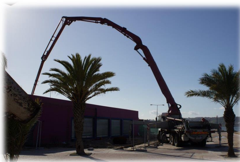
Figura 51 - Bomba em posicionamento
