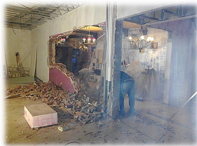
Figura 37 - Vista interior da demolição
