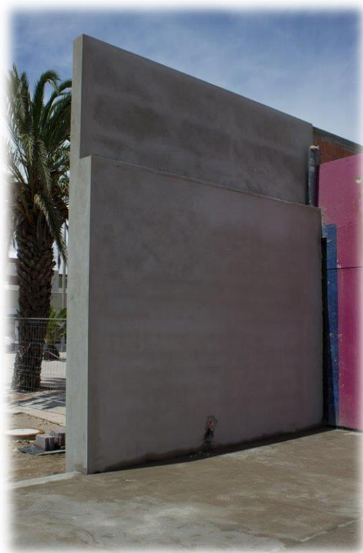
Figura 83 - Aspecto final de parede exterior rebocada
