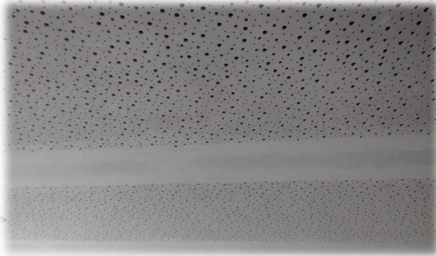
Figura 94 - Aspecto final do tecto já com barramento das juntas e pintura com primário
