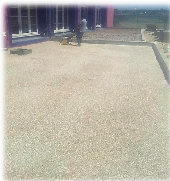
Figura 57 - Camada de brita a ser compactada
