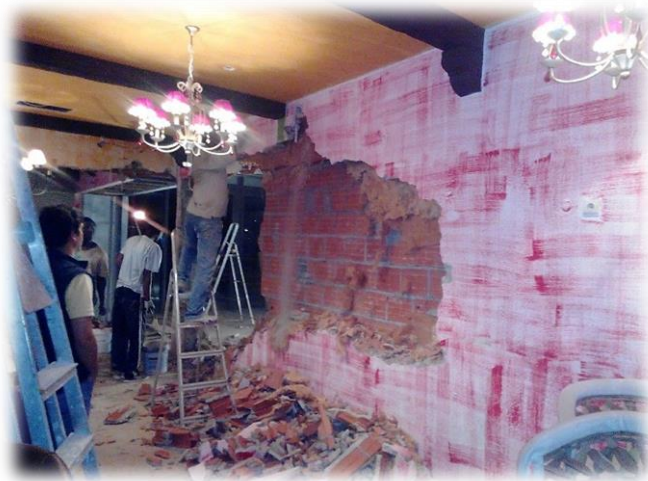
Figura 35 - Demolição de parede exterior para ligação com a ampliação
