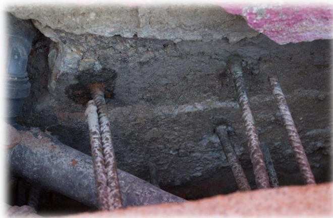
Figura 49 - Selagem de armadura de espera com grout
