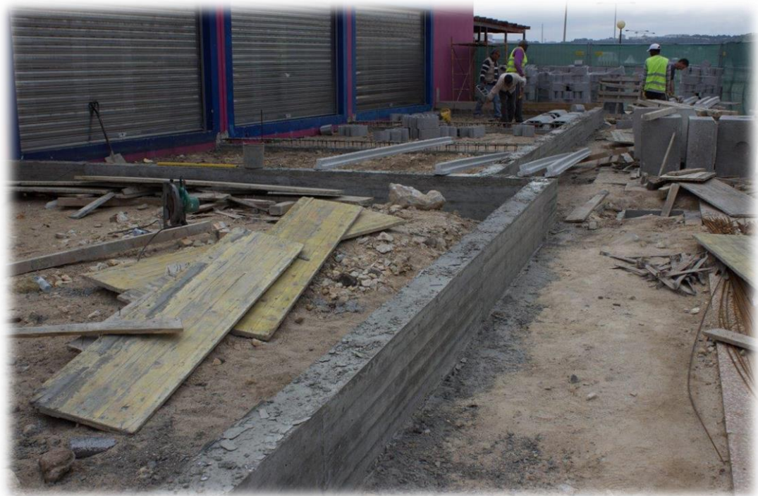
Figura 56 - Lintel de fundação já concluído
