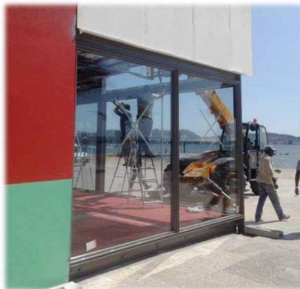
Figura 79 - Aspecto final da caixilharia fixa
