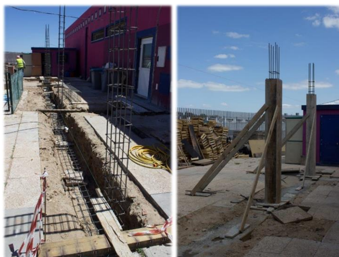
Figura 66 - Armadura e Cofragem dos pilares no tardoz
