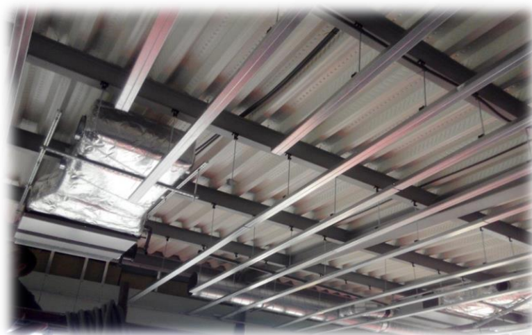
Figura 92 - Perfilaria de fixação das placas
