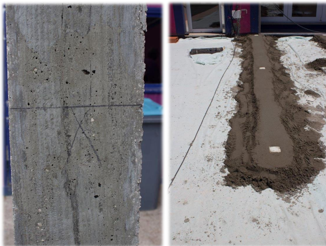
Figura 84 - Marcação do nível de metro (à esq.) Execução de linhas mestras (à dt.)
