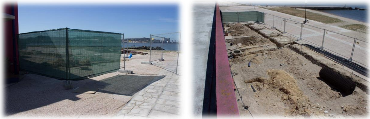
Figura 29 - Vedação do estaleiro com painéis amovíveis
