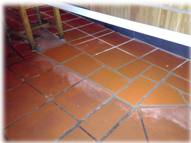
Figura 129 - Remates no pavimento entre o existente e a nova sala
