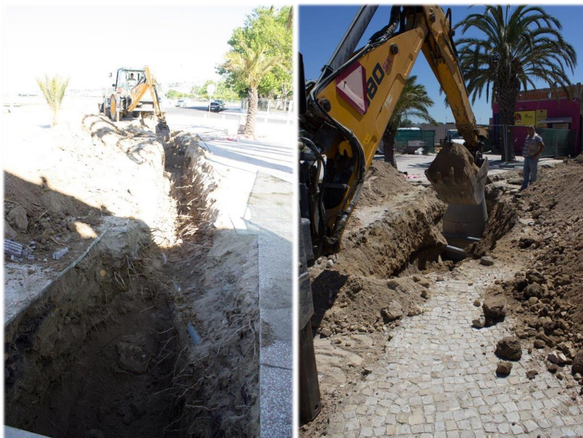
Figura 41 - Abertura de vala para colocação de tubagem
