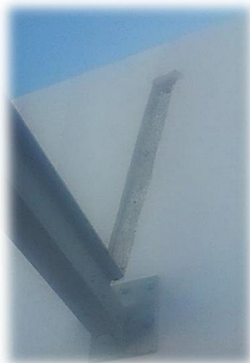
Figura 33 - Abertura de roço para infra-estrutura eléctrica
