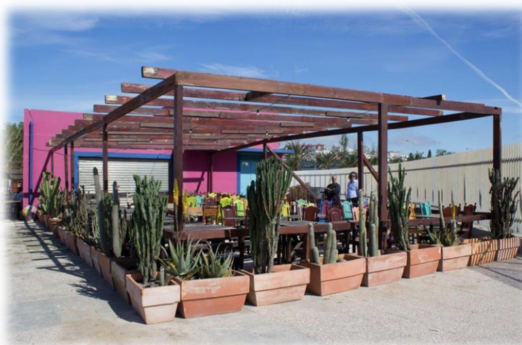
Figura 113 - Esplanada provisória já concluída
