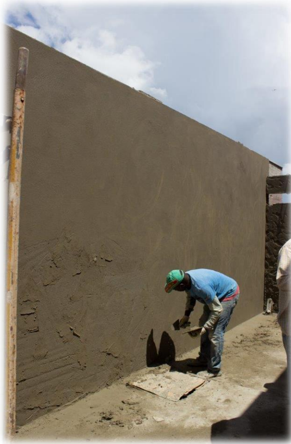
Figura 81 - Rebocagem de parede exterior
