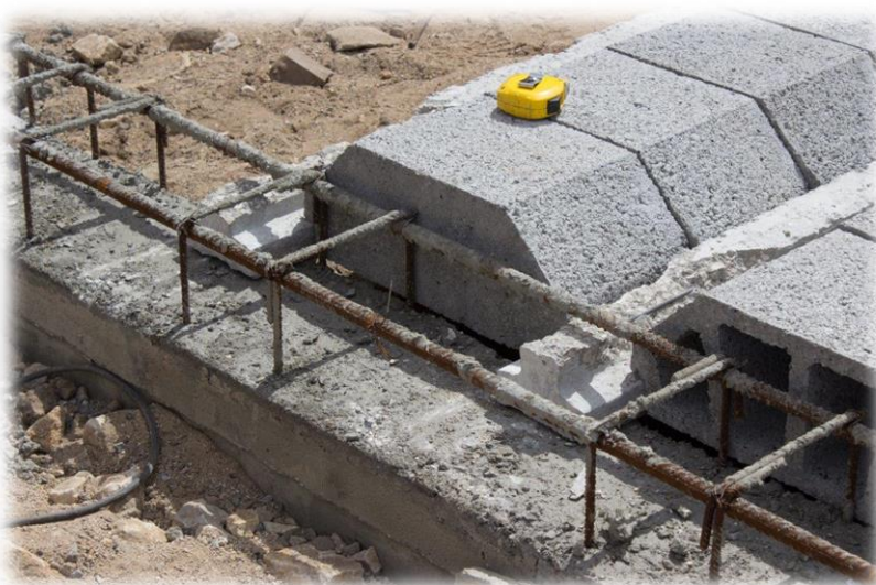
Figura 62 - Assentamento das vigotas no lintel
