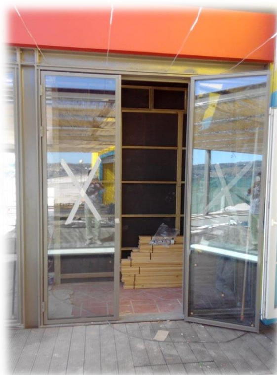
Figura 80 - Vão de batente da caixilharia
