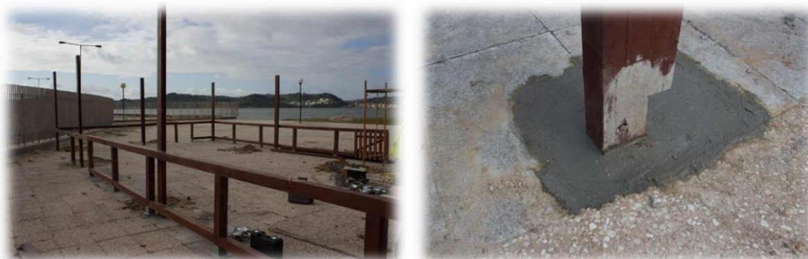
Figura 31 – Trabalhos da realocação da esplanada
