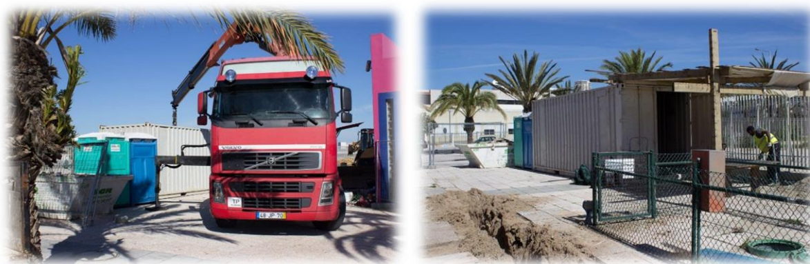
Figura 28 - Entrega e posicionamento de instalações do estaleiro
