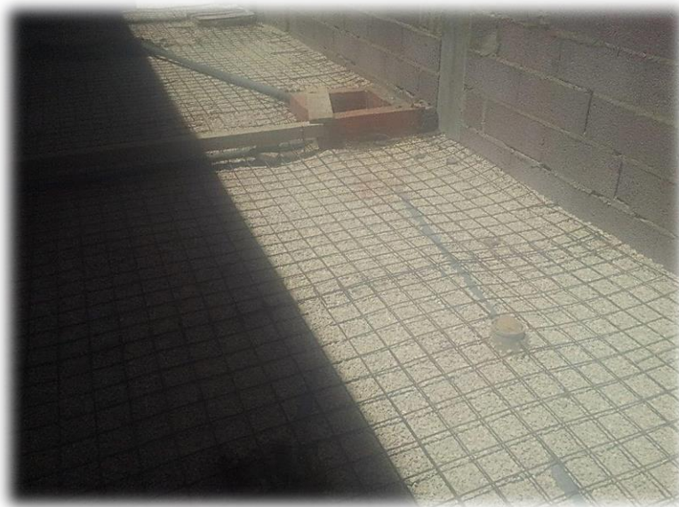
Figura 133 - Implantação dos ralos de pavimentos com ligação à rede de drenagem
