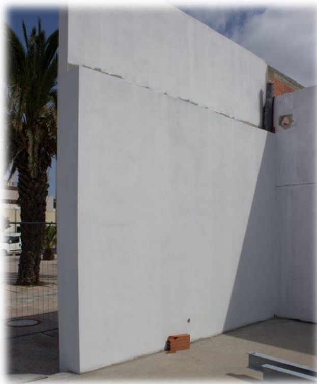
Figura 96 - Parede exterior já com primário
