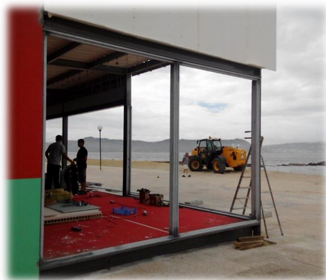
Figura 78 - Caixilharia em processo de montagem
