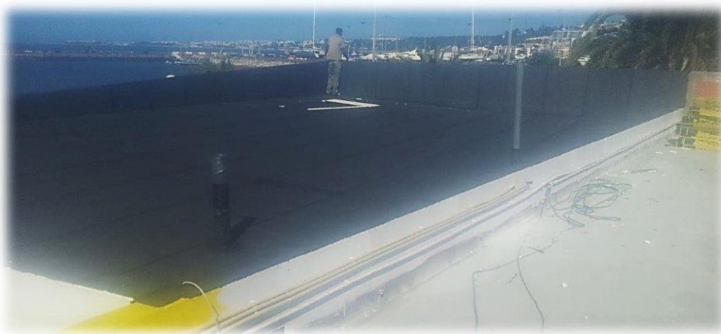
Figura 108 - Cobertura principal já com sistema de impermeabilização aplicado
