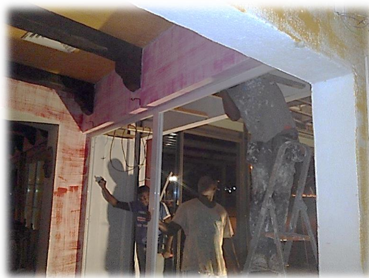
Figura 34 - Remoção de vão de caixilharia existente
