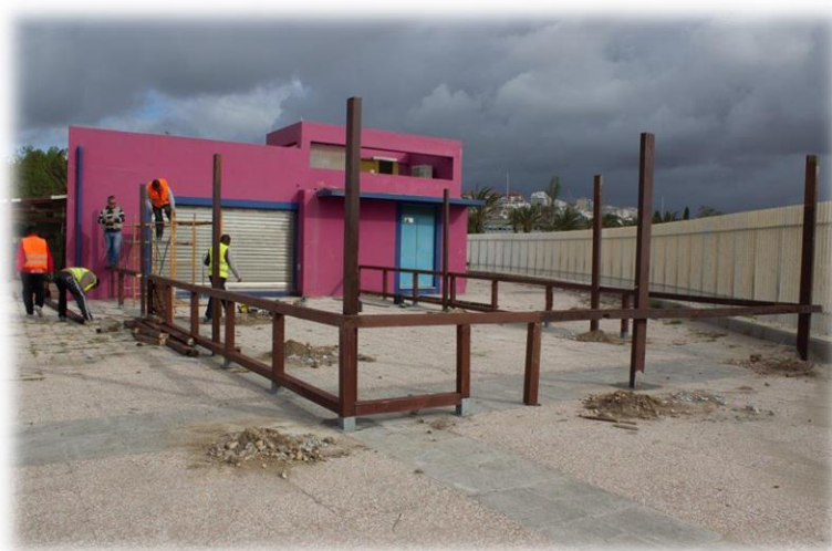
Figura 112 - Durante a montagem da esplanada provisória
