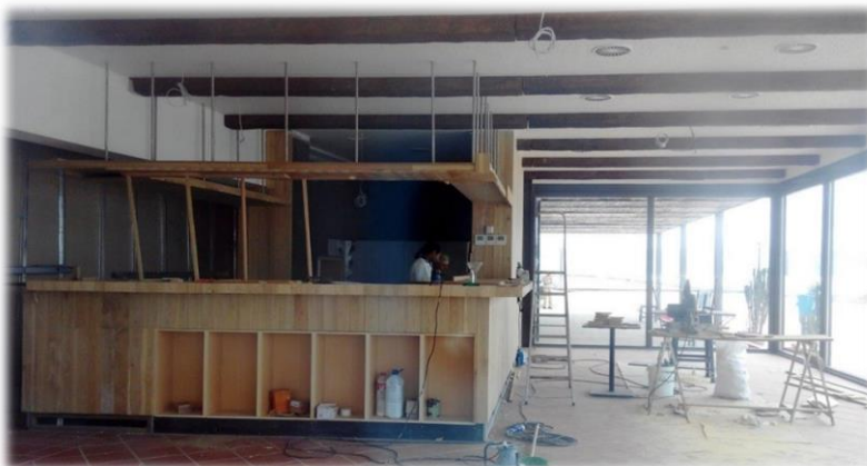
Figura 101 - Bar em fase de aplicação do revestimento exterior
