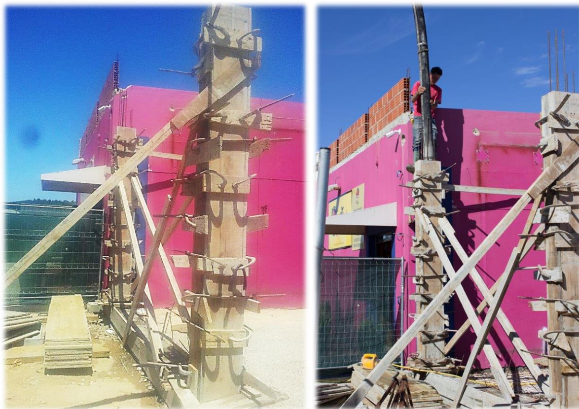
Figura 67 - Cofragem e Betonagem dos pilares no alçado principal
