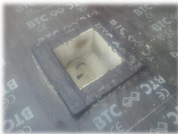
Figura 104 - Impermeabilização à caixa de visita interior
