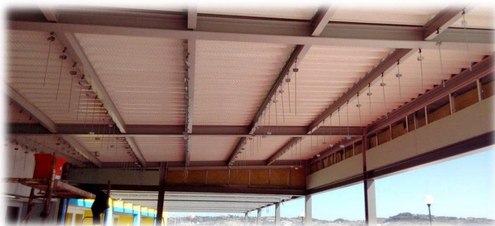
Figura 91 - Suspensões à estrutura da cobertura
