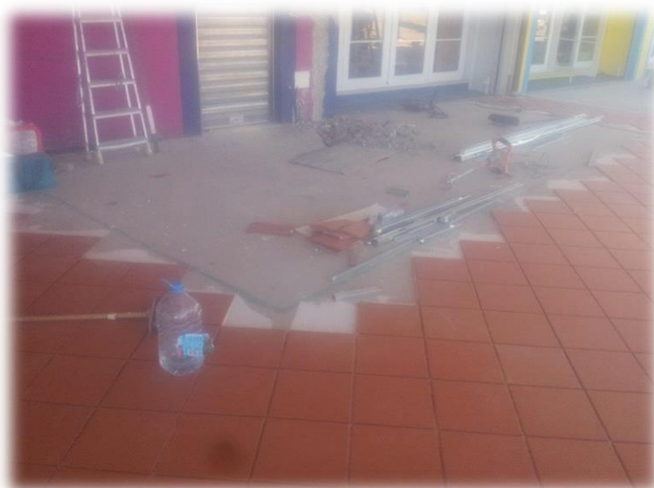
Figura 87 - Revestimento já aplicado até à zona do Bar
