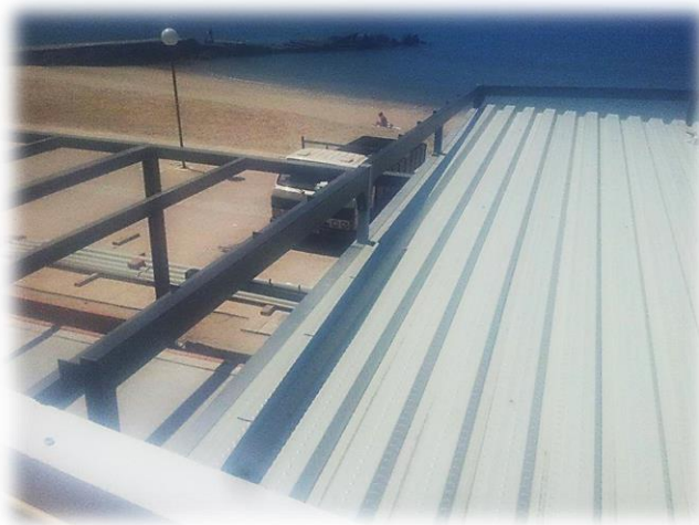
Figura 73 - Chapas autoportantes da cobertura
