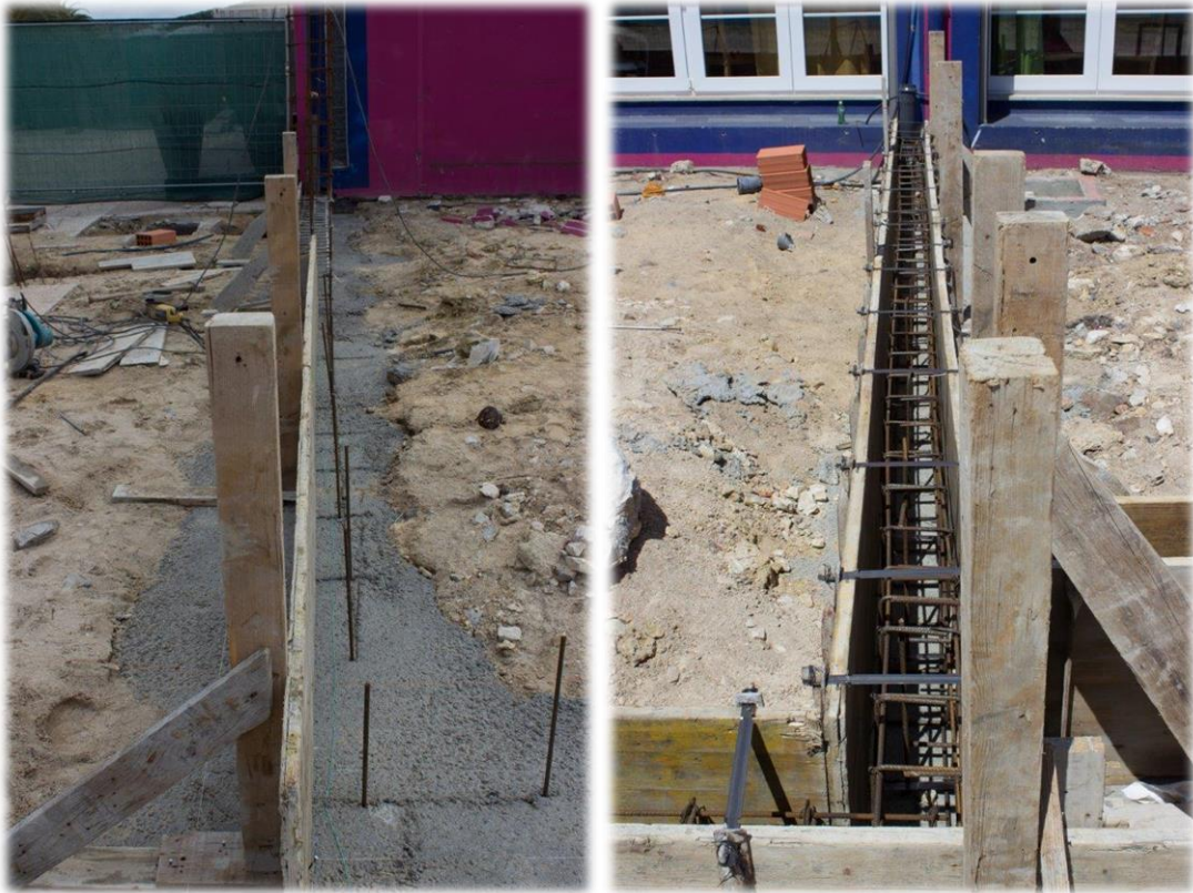
Figura 55 - Cofragem e armadura do lintel
