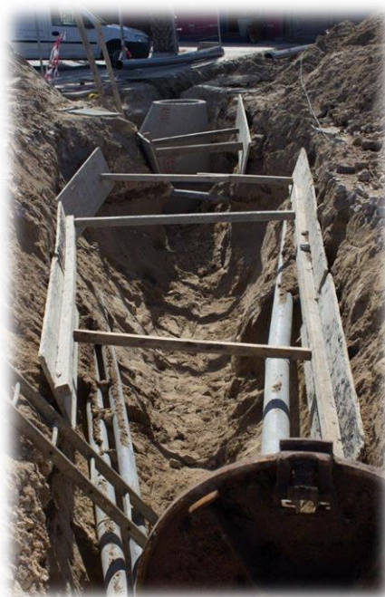
Figura 42 - Entivação da vala para Rede de drenagem
