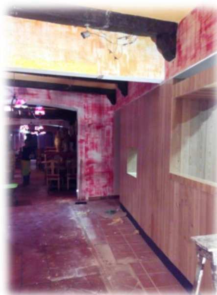
Figura 127 – Divisória falsa já removida
