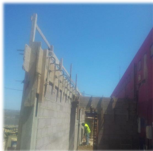
Figura 68 - Cofragem das vigas
