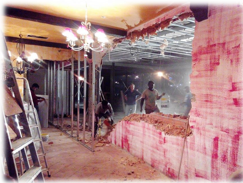
Figura 38 - Demolição quase concluída e já com estrutura para a divisória falsa
