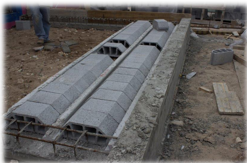
Figura 61 - Colocação das vigotas e abobadilhas
