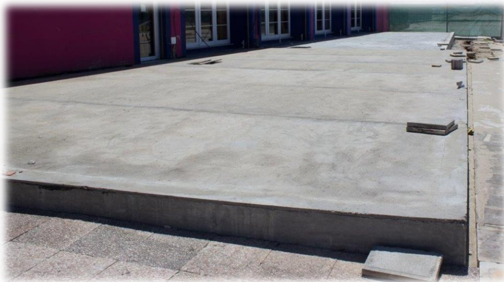
Figura 86 - Aspecto final da betonilha
