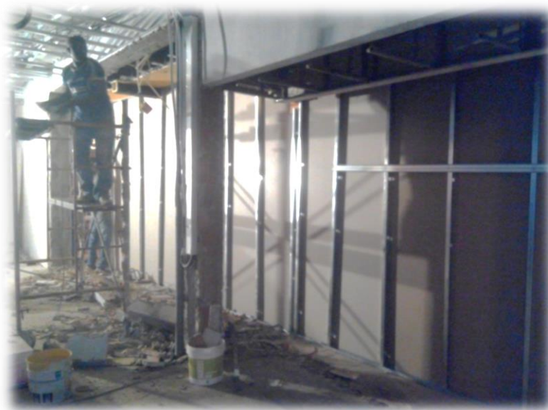
Figura 126 - Divisória falsa vista do lado da obra
