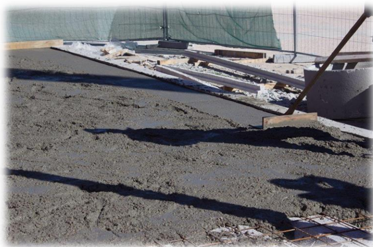
Figura 65 - Regularização da lâmina de compressão
