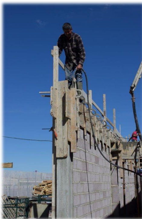
Figura 69 – Vibração do betão das Vigas
