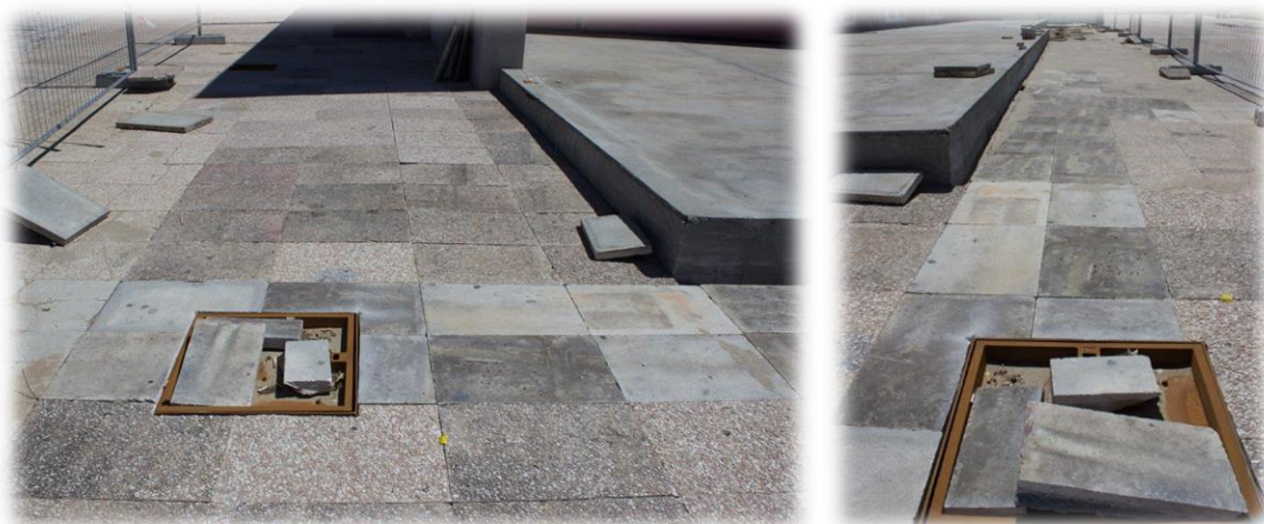
Figura 90 - Lajetas pré-fabricadas recolocadas após intervenções
