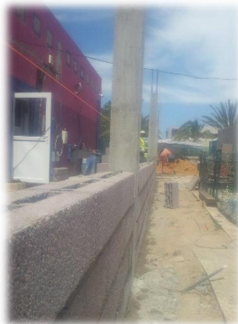
Figura 76 - Paredes exteriores em execução
