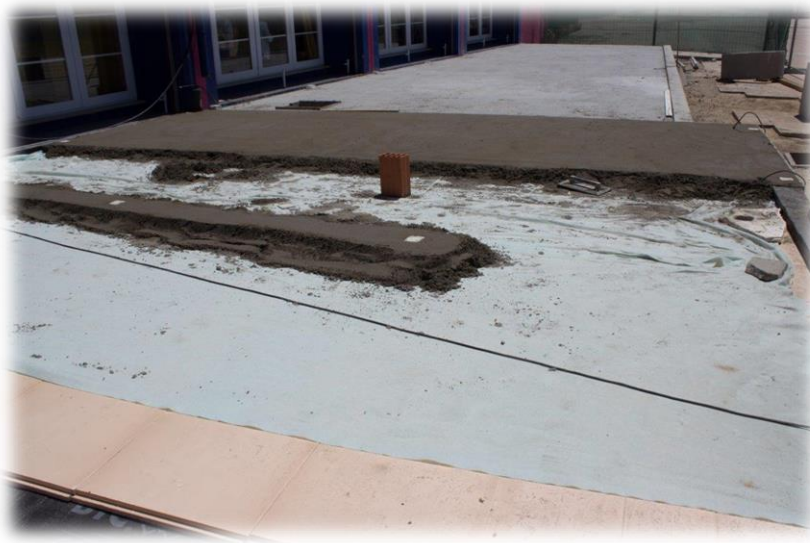
Figura 85 - Execução da betonilha
