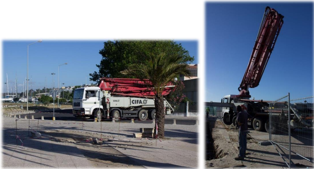
Figura 50 - Chegada da bomba de betão
