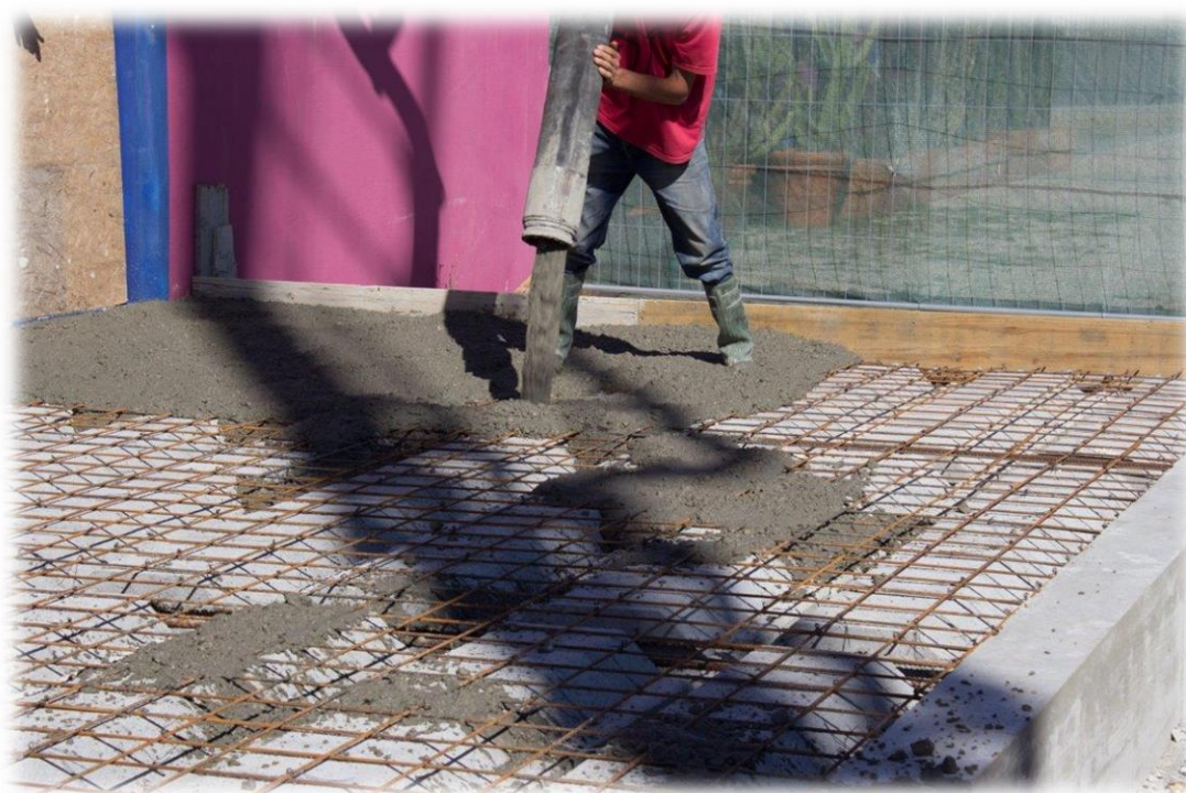
Figura 64 - Betonagem da lâmina de compressão
