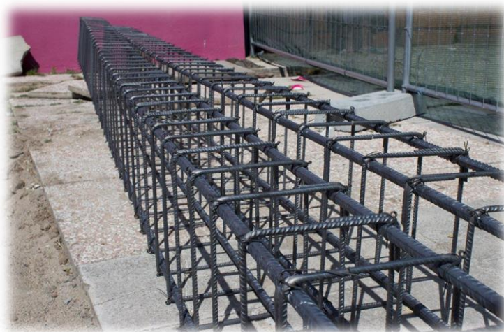
Figura 47 - Elementos de armadura das fundações
