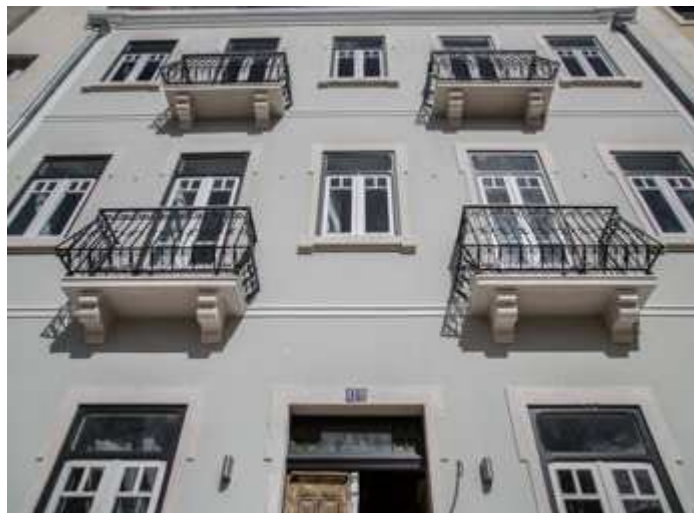
Figura 75 - Edifício residencial de estrutura gaioleira alvo da reabilitação com a mistura em estudo
