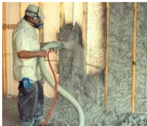
Figura 17 - Projeção de isolamento em celulose (SouthZEB, 2014)
