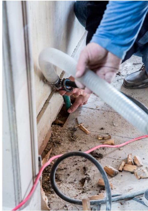
Figura 76 - Aplicação do isolante sem desmontagem do soalho, através da desmontagem parcial do rodapé da divisão
