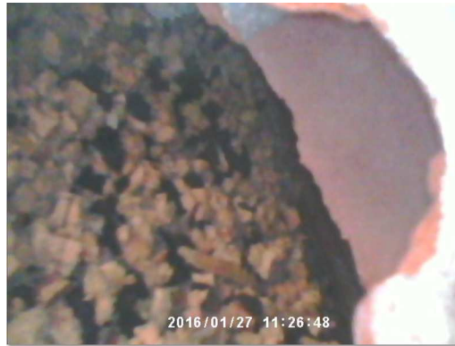
Figura 70 - Imagem com câmara endoscópica da mistura dentro da caixa de ar de uma parede de alvenaria de tijolo
