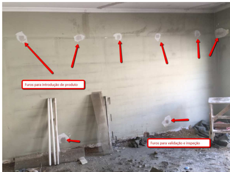
Figura 68 - Parede após intervenção e inspeção do isolante em parede de estuque
