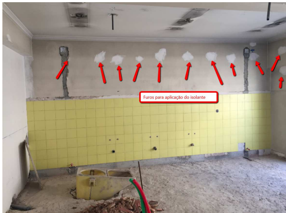
Figura 69 - Parede após intervenção e inspeção do isolante sem demolição dos azulejos dos revestimentos
