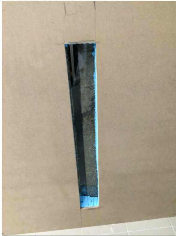
Figura 66 - Janela de visualização do produto depositado na caixa de ar
