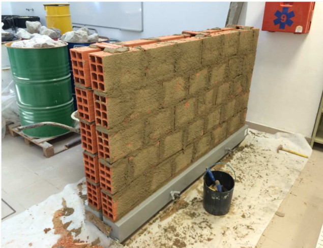
Figura 36 - Construção da parede dupla de alvenaria de tijolo sobre o mecanismo regulador
