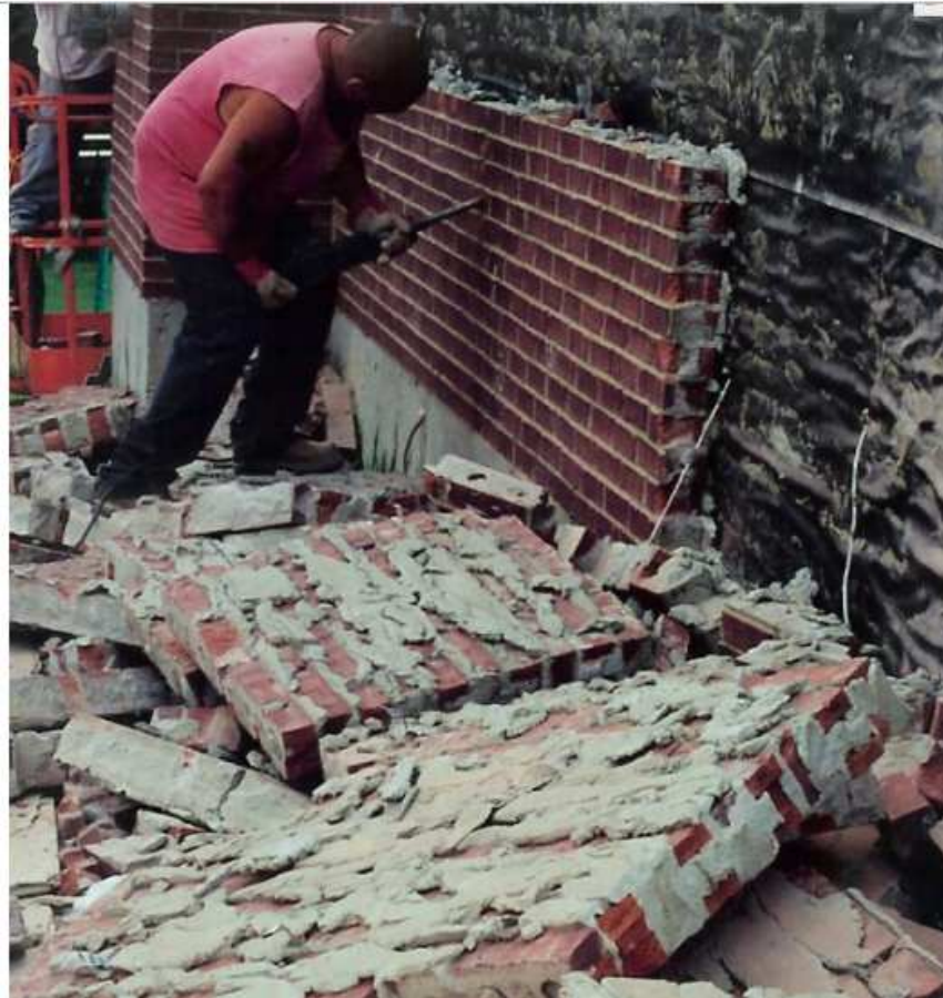
Figura 12 - Espuma de PUR aplicada na caixa de ar de duas paredes, uma de alvenaria de tijolo e uma de alvenaria de pedra (“www.greenbuildingadvisor.com,” 2010)
