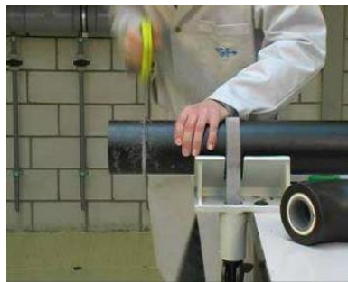
Figura 17- Cortar o tubo. Fonte: Georg Fischer
