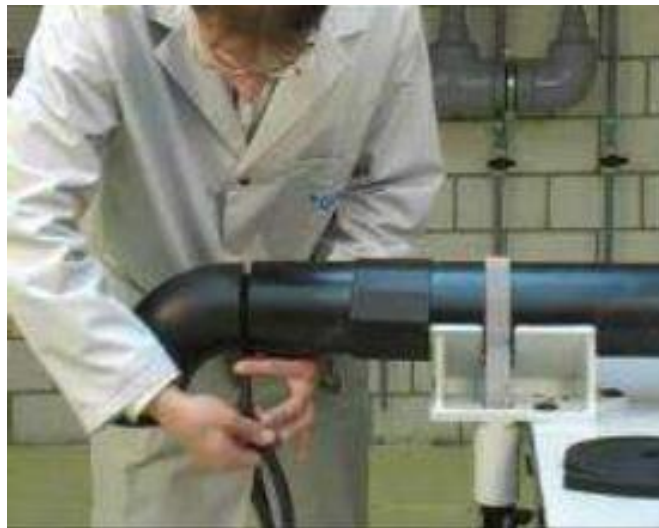
Figura 31 - Enchimento de cordão no espaço de inspeção. Fonte: Georg Fischer
