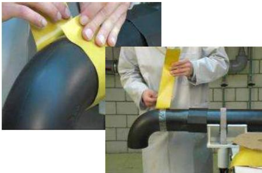
Figura 32 - Aplicação da fita de selagem. Fonte: Georg Fischer
