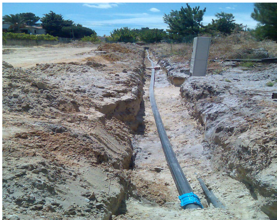
Figura 9 – Tubagem em PEAD ligada à tubagem existente (PVC) através de uma união de tracção
