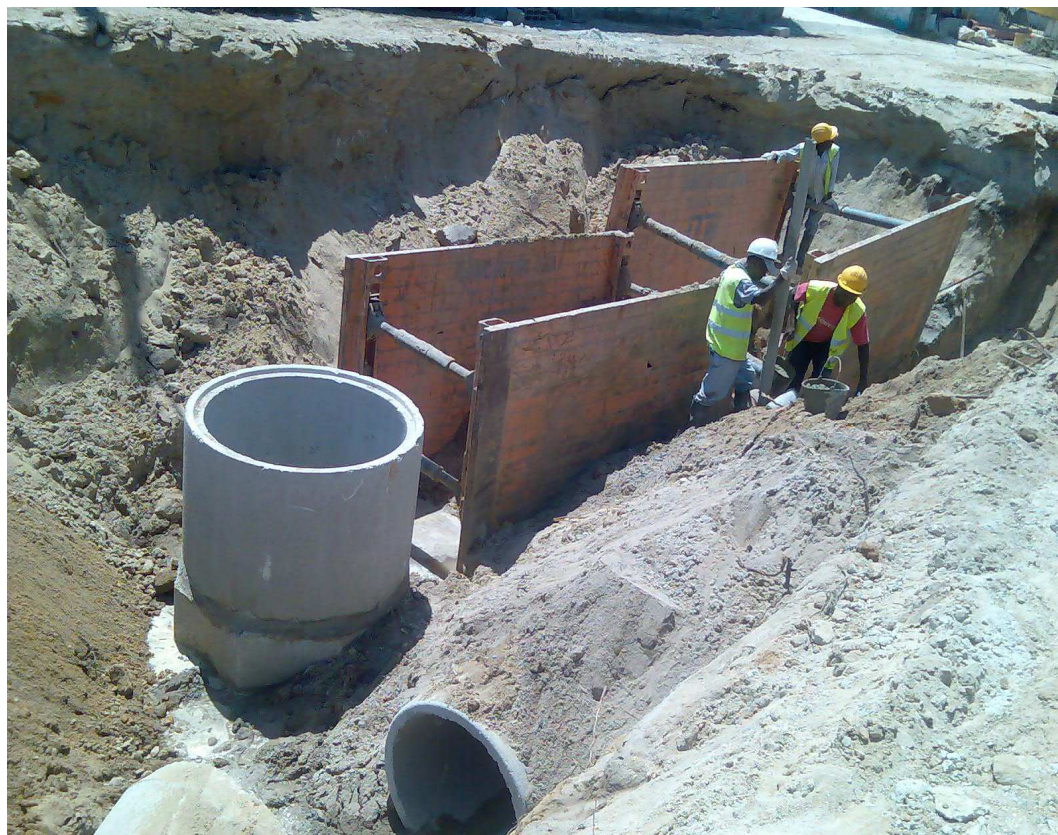
Figura. 5 – Vala com os painéis de entivação
