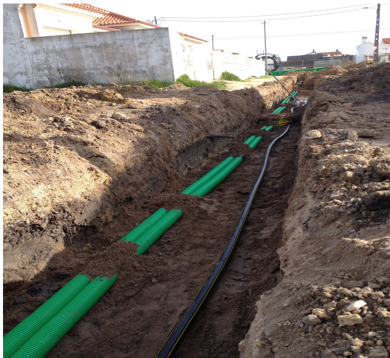
Figura. 14 – Instalação da tubagem na vala
