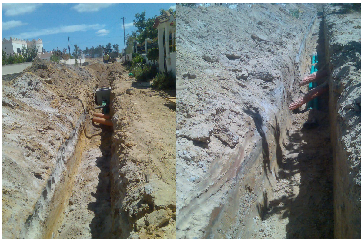
Figura. 15 e 16 – Instalação da tubagem e das caixas de visita
