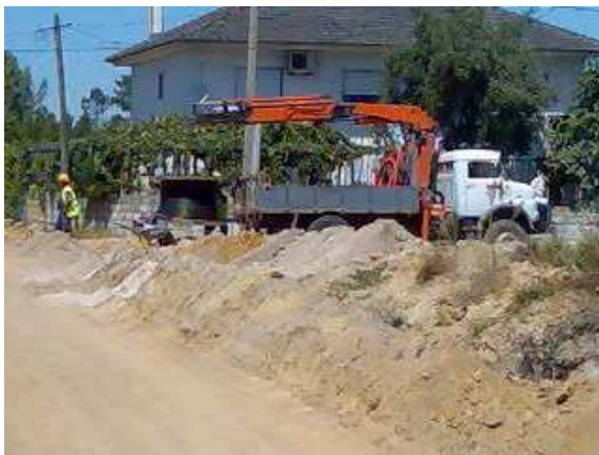
Figura. 10 – Camião de apoio à instalação dos cabos eléctricos
