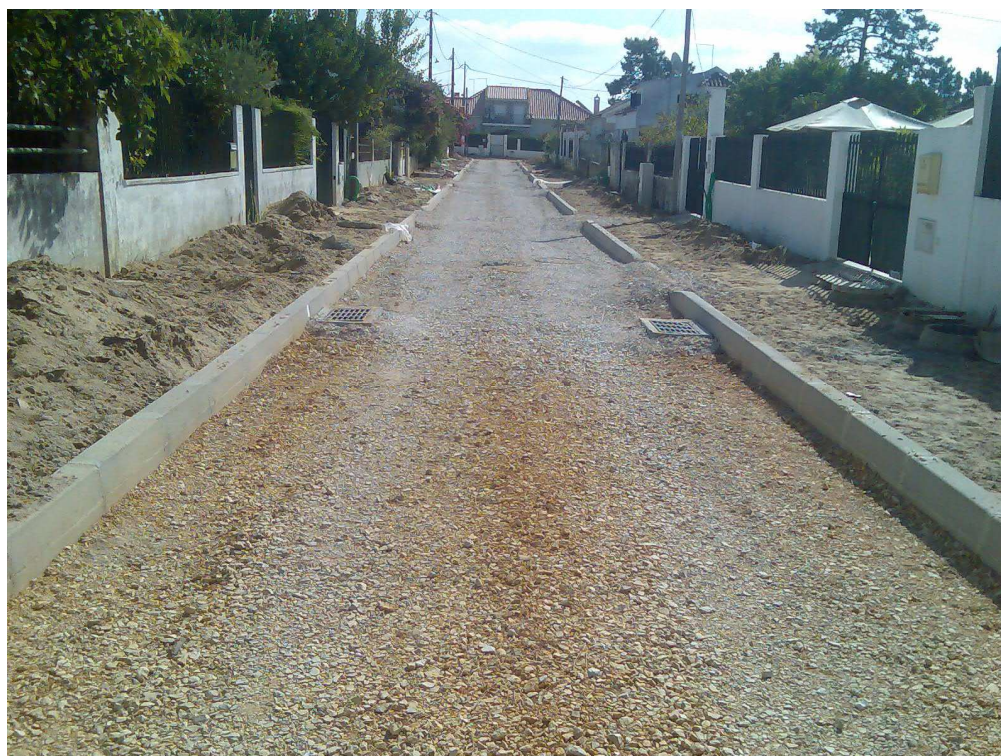
Figura. 18 – Execução de lancis na Rua das Flores
