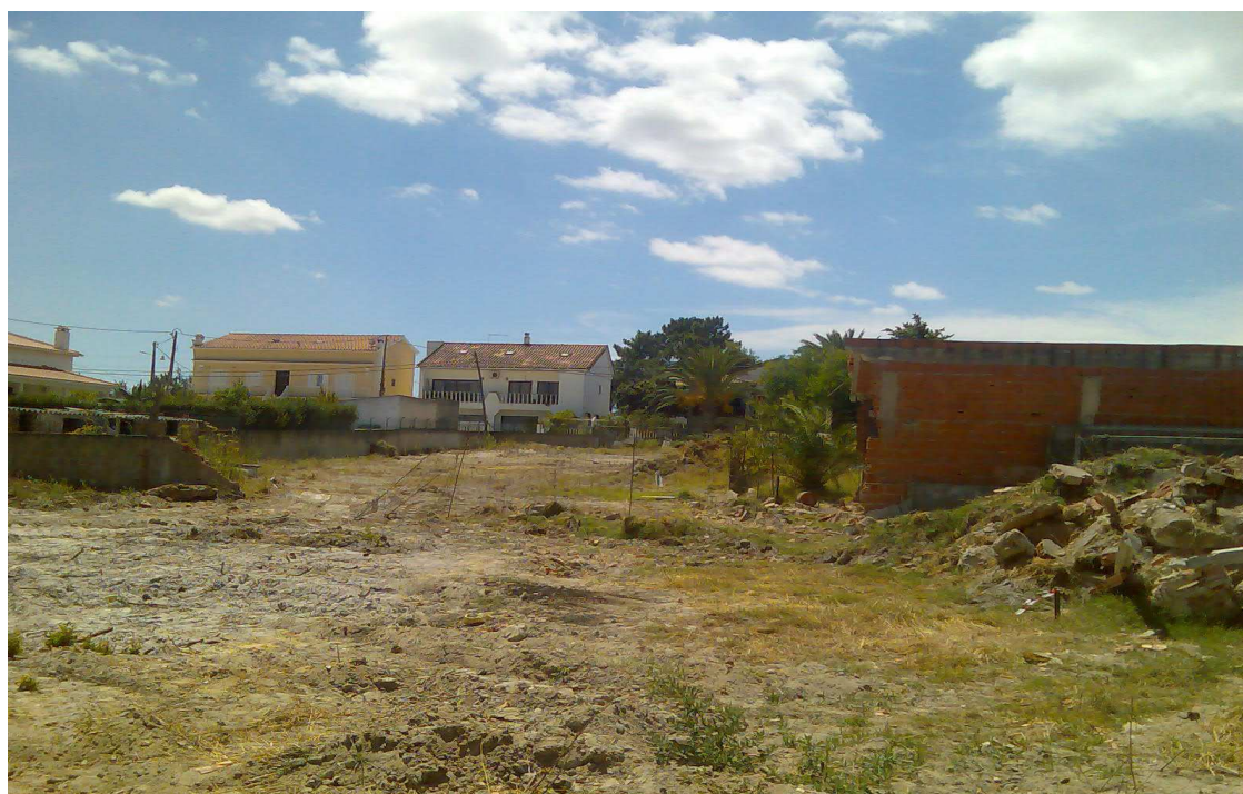
Figura. 17 – Parte da construção demolida de forma a permitir a implantação do arruamento
