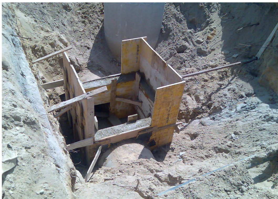
Figura. 6 – Execução da base da caixa de visita em betão armado
