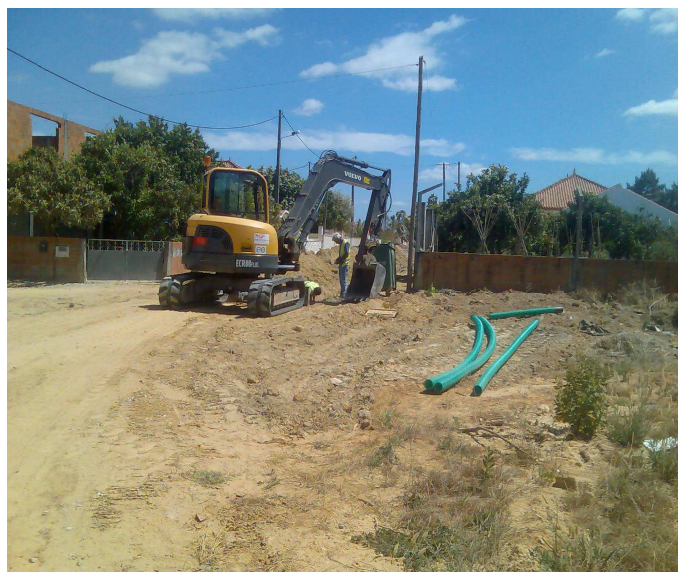
Figura. 13 – Giratória na abertura da vala
