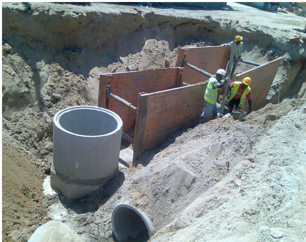
Figura. 5 – Vala com os painéis de entivação
