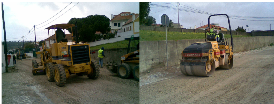
Figura. 20 e 21 – Execução da base do pavimento betuminoso
