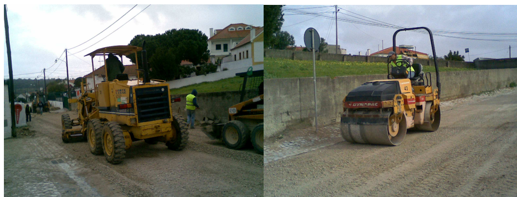
Figura. 20 e 21 – Execução da base do pavimento betuminoso
