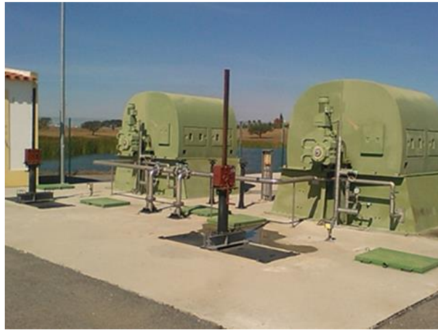
A 4 - Tomada de água do reservatório de Faro do Alentejo.
