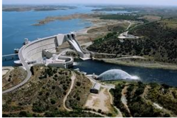
Figura 14 - Barragem do Alqueva com descarregador aberto [www.edia.pt].
