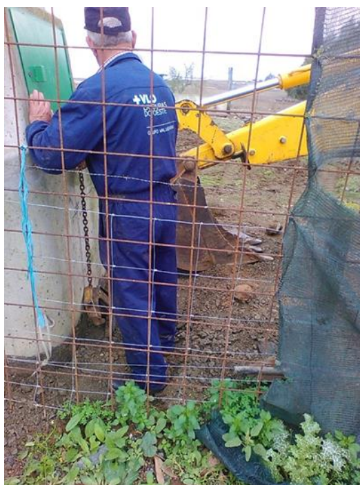
A 18 - Trabalho de retificação da cota de implantação das caixas dos hidrantes do tipo I.
