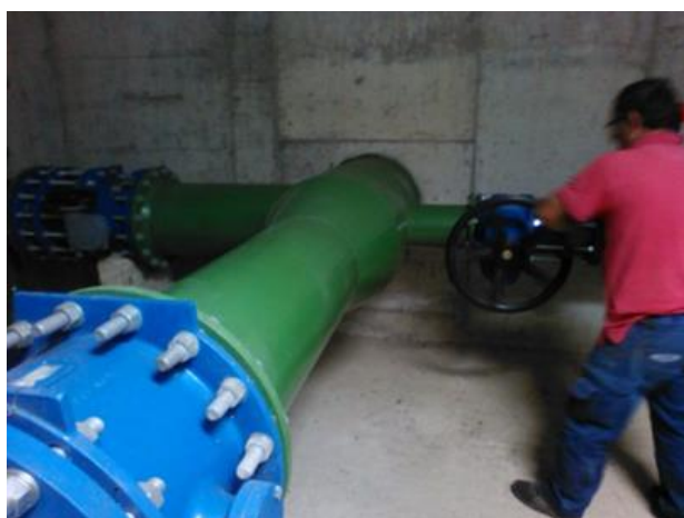
A 17 - Manobra de fecho da válvula de seccionamento.
