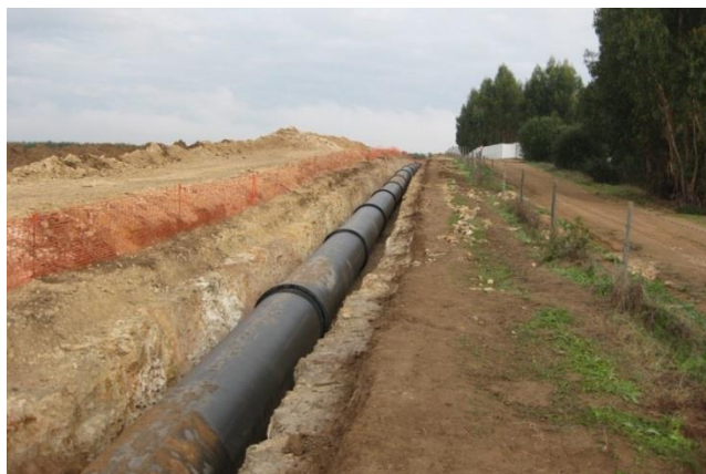
Figura 31 - Tubagem de PEAD em Pedrogão com ligação electro soldada [www.prospectiva.pt].
