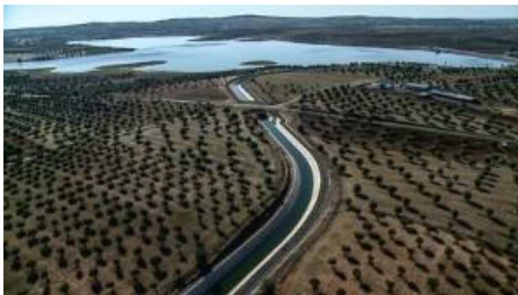
Figura 16 - Sistema de adução a barragem [ www.edia.pt ].
