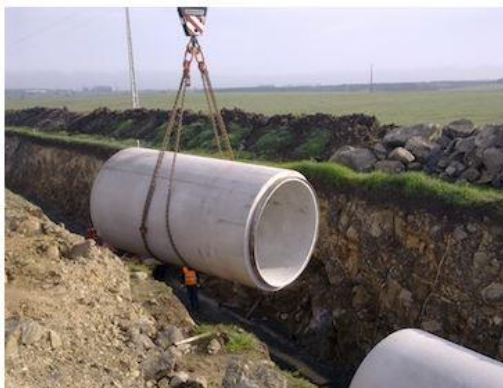
Figura 29 – Assentamento de tubagem de betão armado com alma de aço no adutor Pisão-Beja [www.alentubo.pt].
