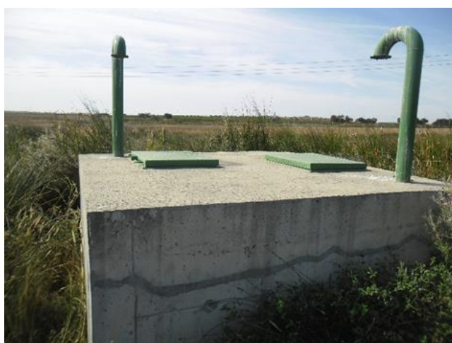
A 3 - Caixa da descarga de fundo da derivação adutora em canal para o reservatório de Faro do Alentejo.
