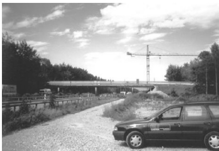
Figura 4.1 – Vista da ponte.
