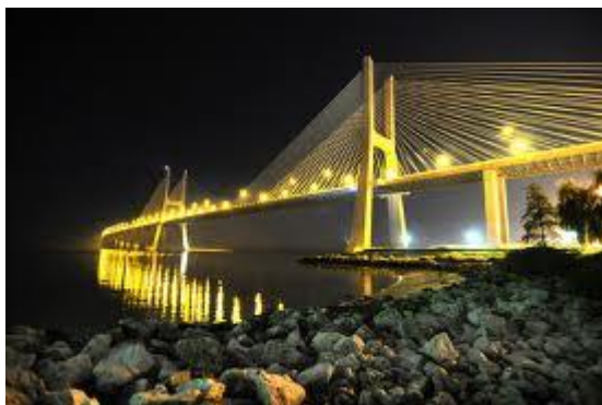
Figura 2.5 – Ponte Vasco da Gama
