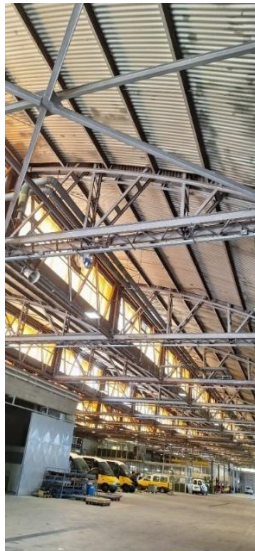
Figura 3.4 - Cobertura do edifício.
