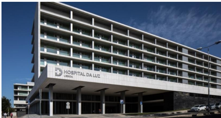
Figura 2. Hospital da Luz Lisboa. Retirado de [27]
