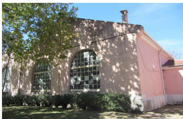
Figura 3. Fachada tardoz. Fonte: Autor, setembro 2017.
