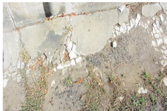
Figura 4- Presença de sujidades no canal de drenagem. (terra, areia, entre outros). Fonte: Autor, outubro 2017.
