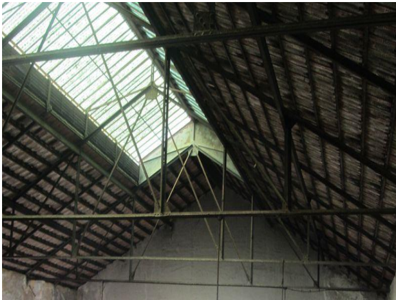
Figura 2- Estrutura da cobertura. Fonte: Autor, outubro 2017.
