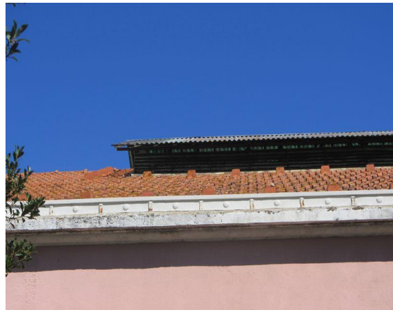
Figura 2- Chapas acrílicas apresentando mudança de cor - exterior. Fonte: Autor, outubro 2017.
