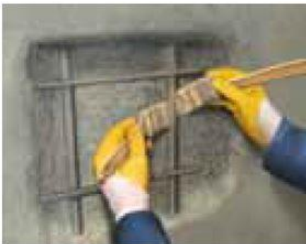
Figura 3 - Aplicação de proteção anticorrosiva
