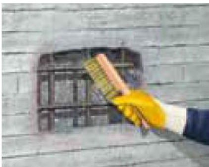
Figura 2 - Escovagem para limpeza de armaduras
