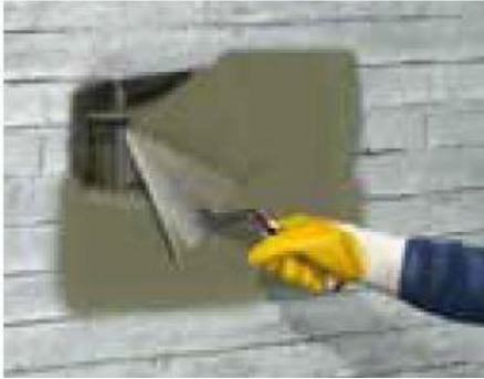
Figura 4 - Aplicação da argamassa com colher
