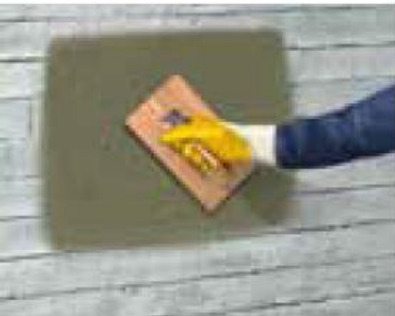
Figura 5 - Alisamento da superfície com talocha
