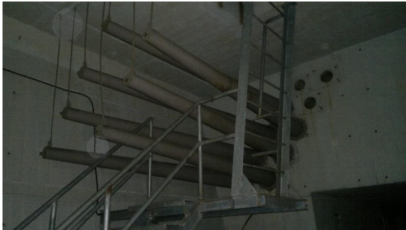
Figura 5.3 - Ancoragem sobre o pilar PE2. (Montante)
