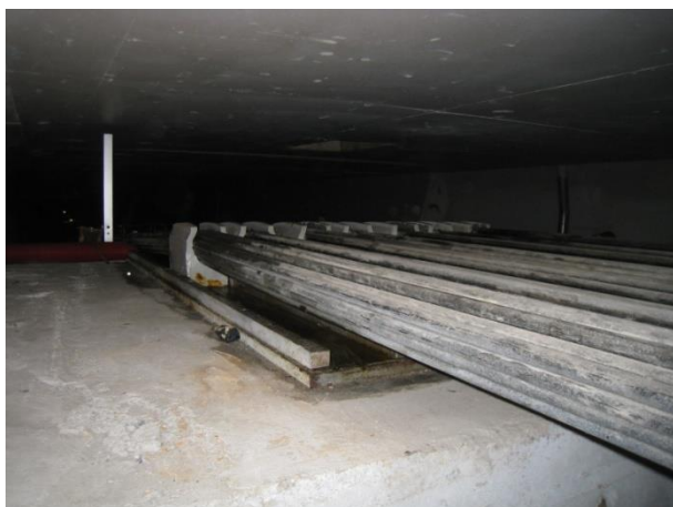
Figura 2.1 - Pré-esforço exterior de continuidade na Ponte de S. João, Porto.
