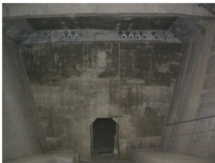
Figura 2.3 - Dispositivos para o desvio de cabos de pré-esforço exterior na Ponte Miguel Torga, Régua.
