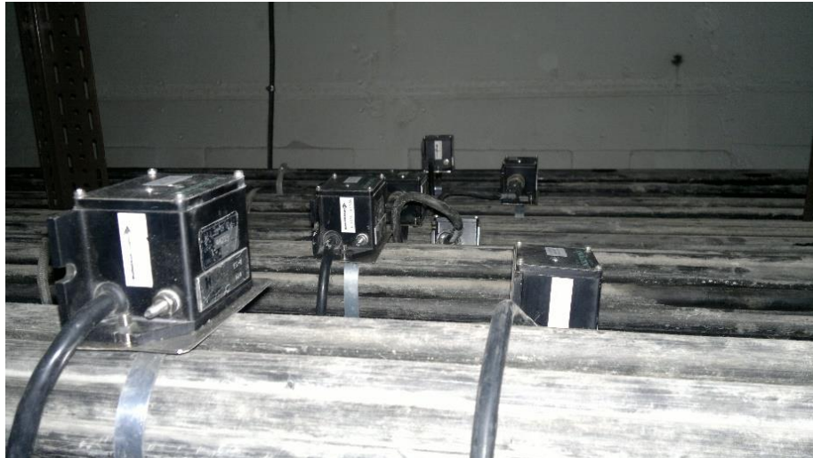
Figura 5.6 - Acelerómetros instalados nos cabos de pré-esforço.
