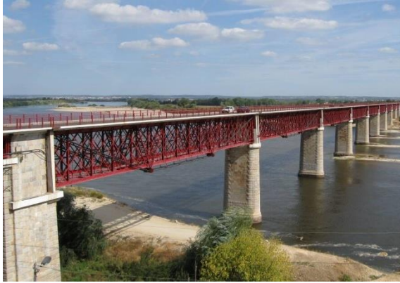
Figura 2.4 - Pré-esforço exterior de reforço da Ponte D. Luís, em Santarém.
