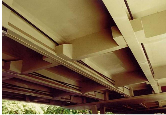
Figura 2.5 - Pré-esforço exterior de reforço no viaduto do Fonte Nova, Lisboa.
