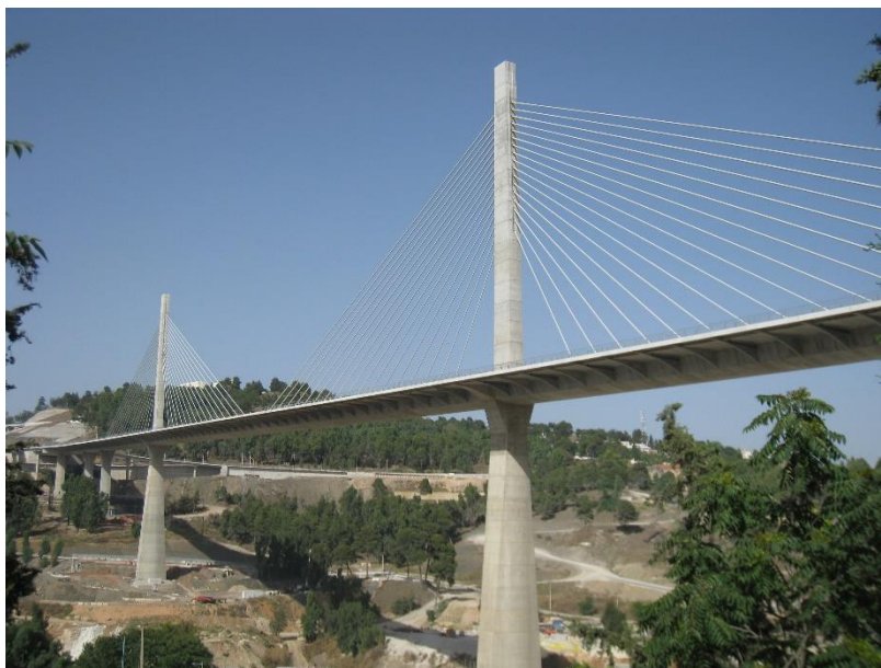
Figura 5.26 - Viaduto Salah Bey.
