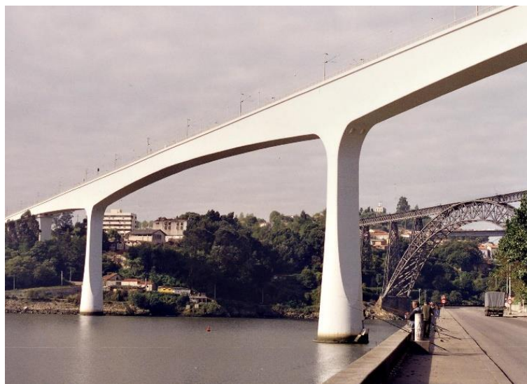
Figura 5.1 - Ponte de S. João.
