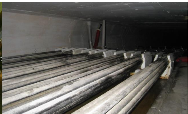
Figura 5.5 - Desviador sobre o pilar PD2 (Jusante).
