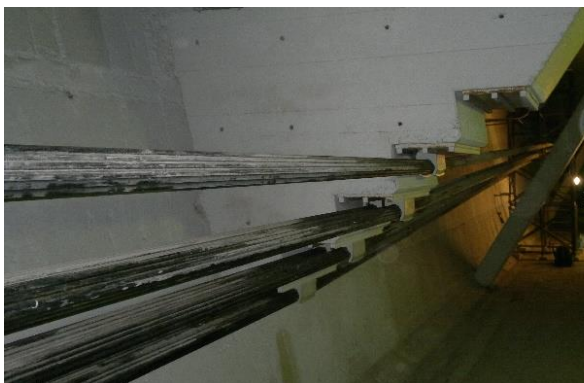
Figura 5.4 - Desviador a 75 m do pilar PE1 (Jusante).
