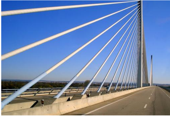
Figura 2.7 - Ponte Salgueiro Maia (Santarém) com atirantamento central.
