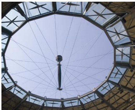
Figura 2.10 - Cobertura da Praça de Touros do Campo Pequeno (Lisboa), 2006.
