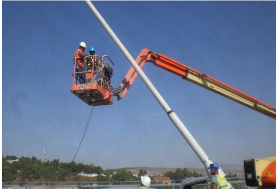
Figura 5.29 - Colocação do acelerómetro no tirante.
