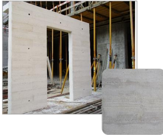
Figura 4.18: Pormenor da anomalia manchas de humidade no betão – Protótipo nº 2, 2015.
