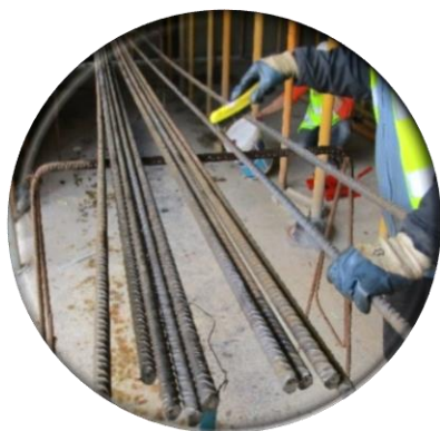
Figura 4.6: Processo de escovagem das armaduras, 2015.
