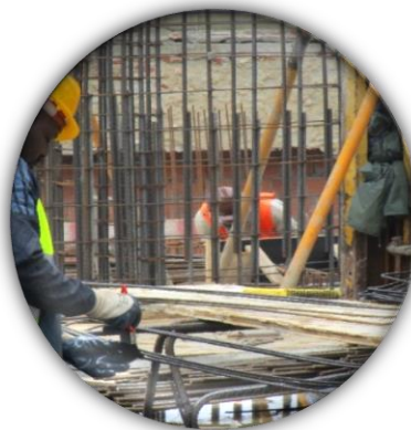
Figura 4.7: Processo de tratamento das armaduras, 2015.
