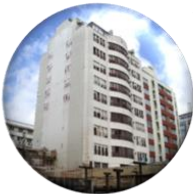
b) Edifício do alçado norte;
