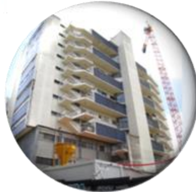
c) Edifício do alçado sul.
