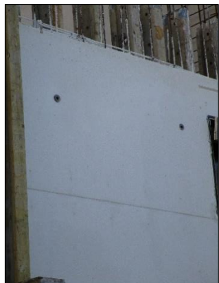
Figura 4.30: Pormenor do terceiro troço betonado, 2015.
