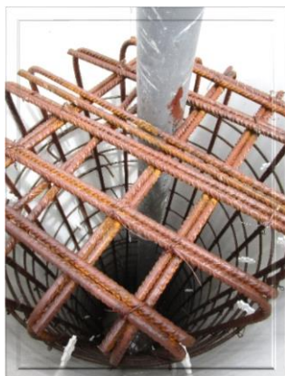
Figura 4.32: Atividade de betonagem do pilar P3, 2015.
