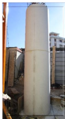
Figura 4.33: Resultado da descofragem do pilar P3, 2015.
