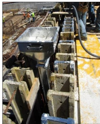
Figura 4.31: Atividade de betonagem do terceiro troço da parede, 2015.
