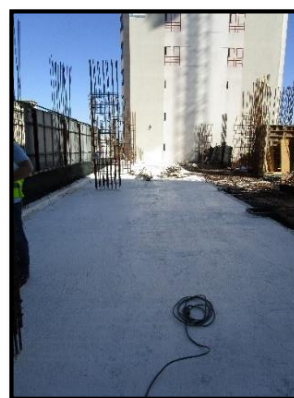
Figura 3.18: Acabamento após a descofragem da pala localizada na laje do piso 1, 2015.
