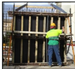
Figura 4.24: Atividade de cofragem do quarto protótipo, 2015.
