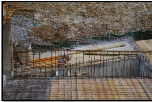
a) Atividades de cofragem e armadura;
