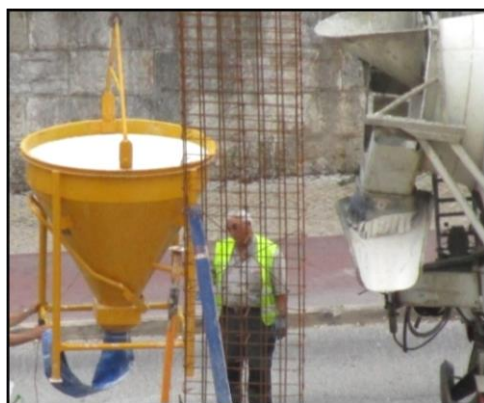
a) Colocação do betão branco no balde;
