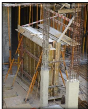
Figura 4.14: Atividade de cofragem do segundo protótipo, 2015.
