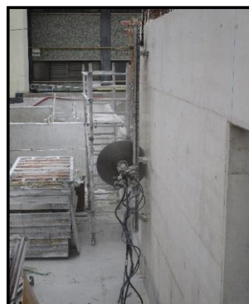
Figura 3.16: Demolição do segundo troço da parede Pa2f por corte diamantado, 2015.
