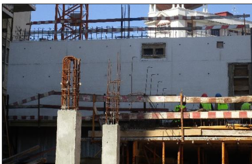
Figura 4.27: Primeiro troço da parede (Pa2f) após a descofragem, 2015.
