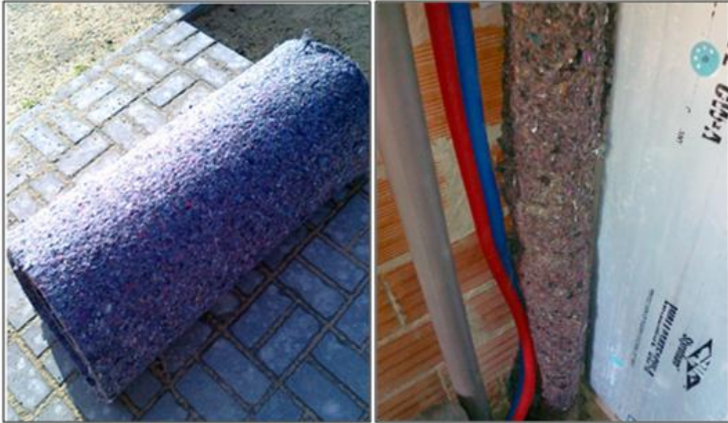
Figura 4.6 - Isolamento de tubo de queda de água pluvial
