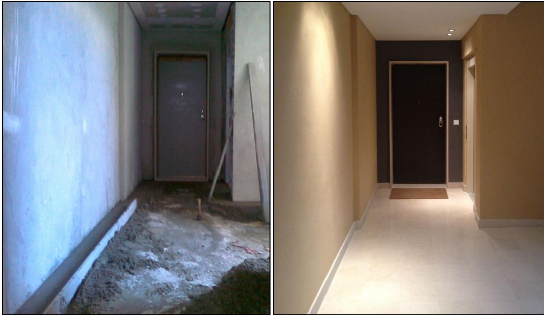
Figura 3.16 - Emboço e posterior acabamento em resinas epóxicas
