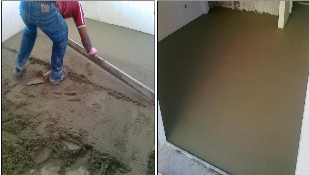
Figura 3.23 - Execução de betonilha
