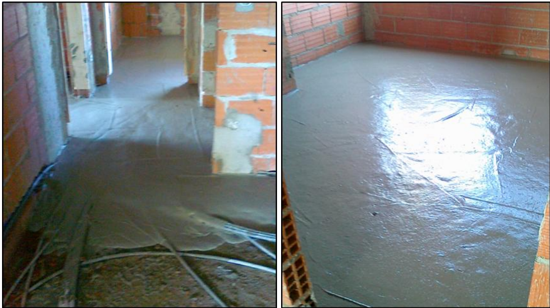
Figura 3.22 - Aplicação de camada de recobrimento - betão celular
