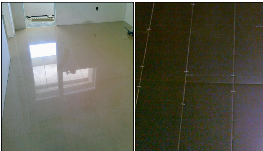
Figura 3.25 - Revestimento cerâmico de pavimentos de cozinhas e casas-de-banho
