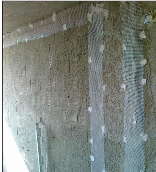
Figura 3.5 - Salpico do pano de alvenaria e aplicação rede de nylon
