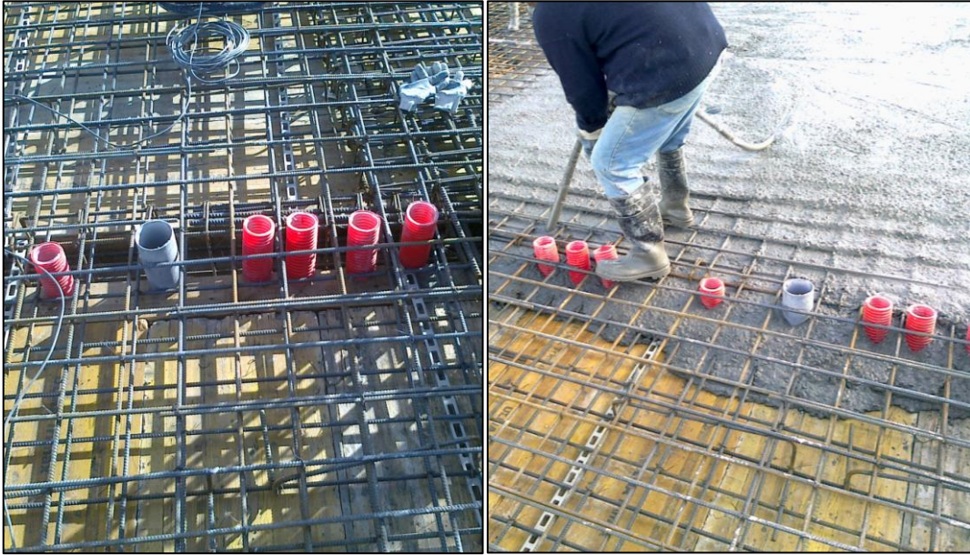
Figura 4.24 - Negativos na laje destinados a passagem de coluna de água
