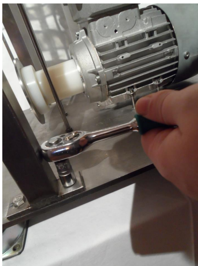
Figura 105-Montagem da armação metálica na base.
