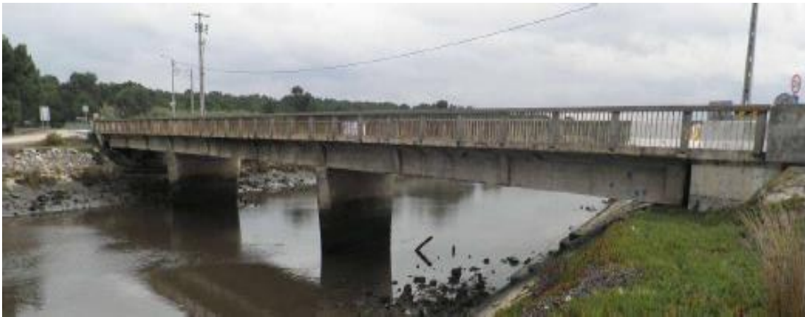
Figura 15 - Vista de Sul para Norte da ponte [22]
