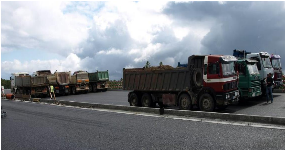
Figura 14 – Posicionamento de veículos (ensaio de carga estático de um viaduto)
