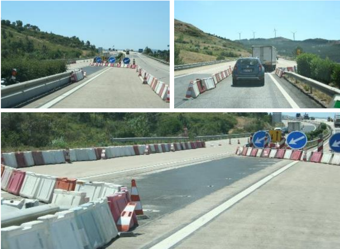
Figura 5.11 - Basculamento do tráfego ao km 34+125
