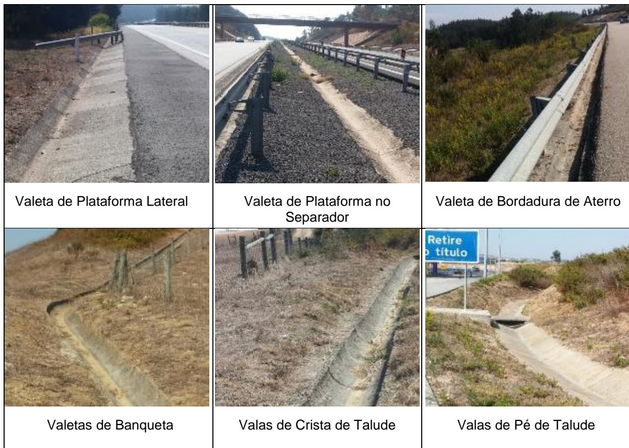
Figura 3.2 – Exemplos de valas e valetas existente na rede da AEA
