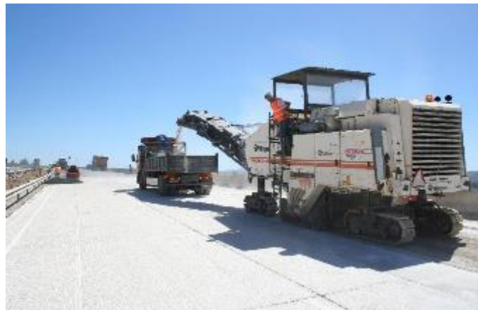
Figura 5.12 - Realização da fresagem
