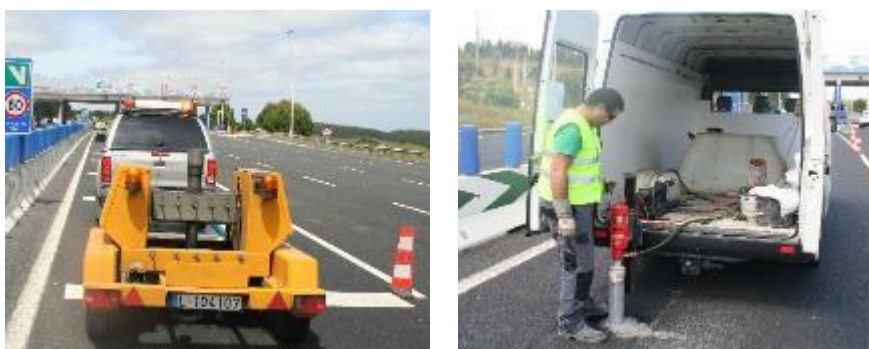
Figura 3.20 - Realização do ensaio para a determinação da deflexão e carotagem na Portagem do Bombarral
