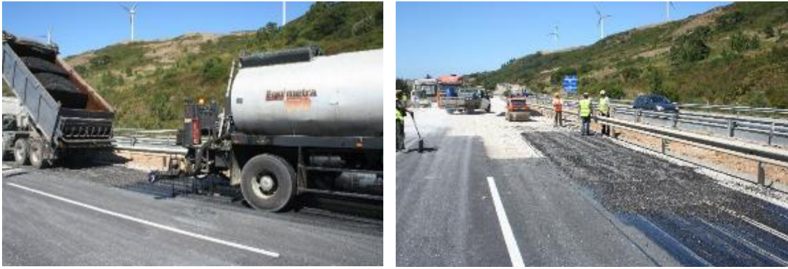
Figura 5.17 - Realização dos enchimentos
