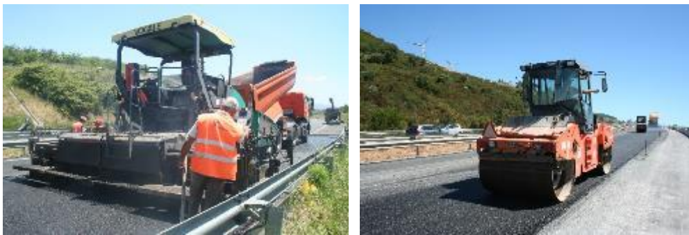
Figura 5.18 - Aplicação e compactação da mistura betuminosa
