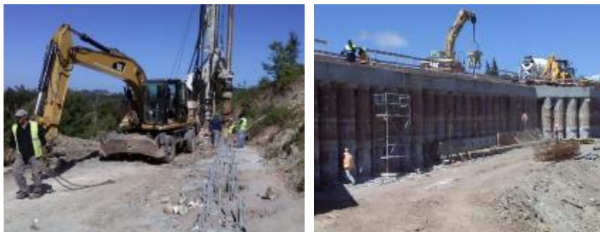
Figura 3.21 - Obras de Estabilização de taludes realizadas na A15
