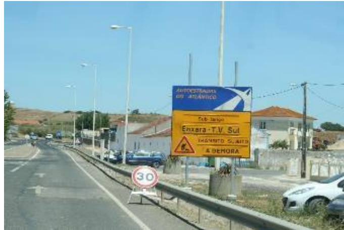
Figura 5.10 - Sinalização temporária (aviso de trabalhos na autoestrada)
