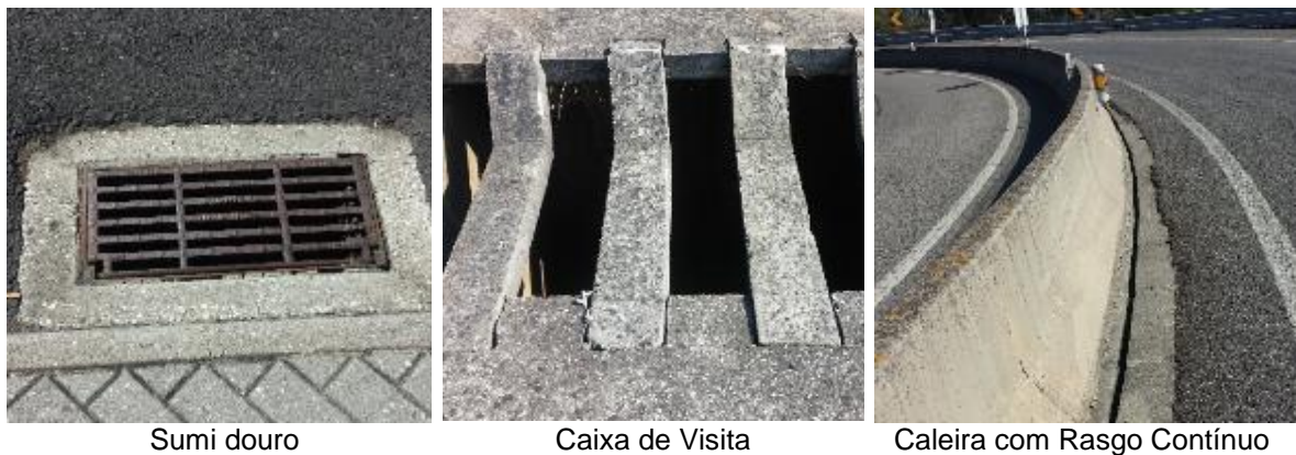
Figura 3.3 - Exemplos de outros órgãos de drenagem existentes na rede da AEA
