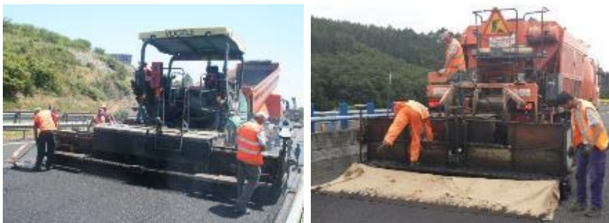
Figura 3.22 - Obra de Reperfilamento e Aplicação do Microaglomerado Betuminoso
