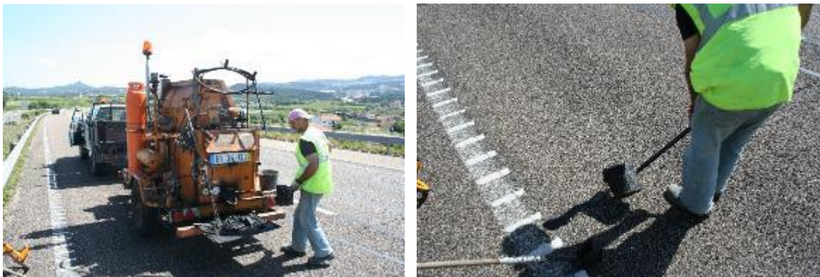
Figura 5.13 - Aplicação do selante
