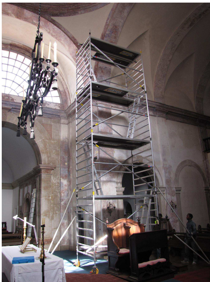
Figura 1.1: Andaime móvel para acesso a fissuras
