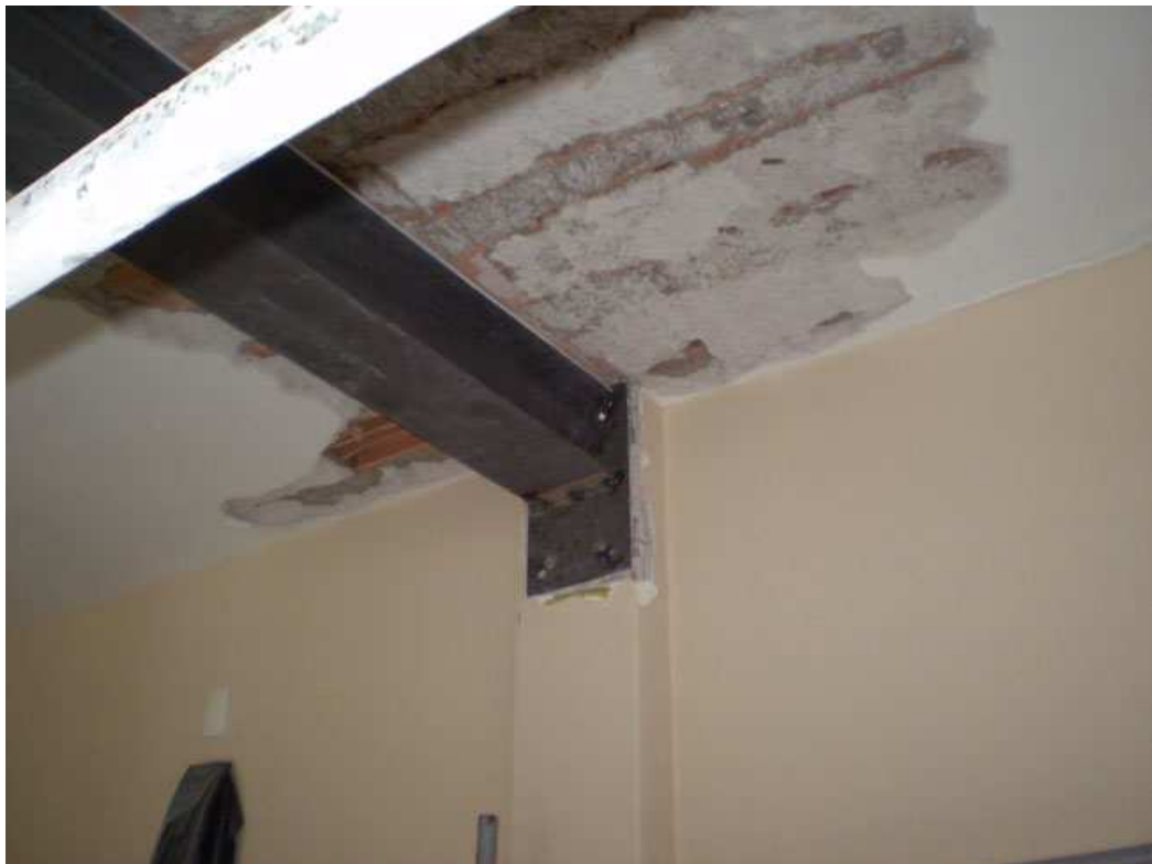
Figura 2.6: Reforço de Laje
