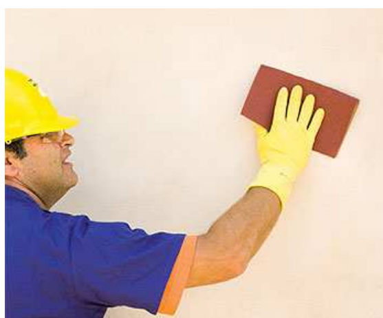
Figura 2.5: Lixagem de parede
