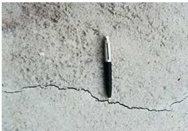
Figura 2.1: Fissuração por retracção
