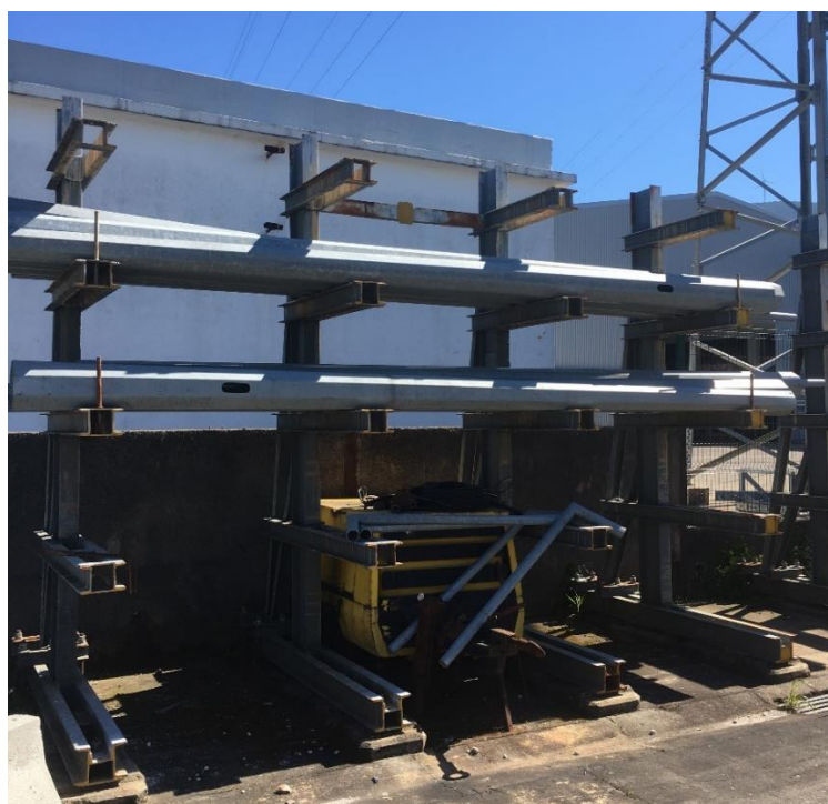
Figura 3.27 – Racks Cantilever em desuso no Armazém Central da Lousã
