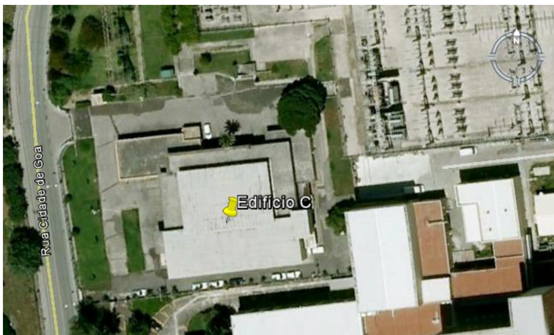
Figura 2.1 – Localização do edifício em estudo Fonte: Adaptado de GoogleEarth
