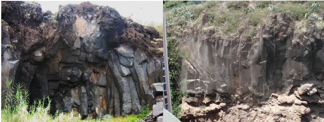
Figura 3.3- Maciço basáltico fracturado e protegido com redes de protecção (cortesia Geofix)
