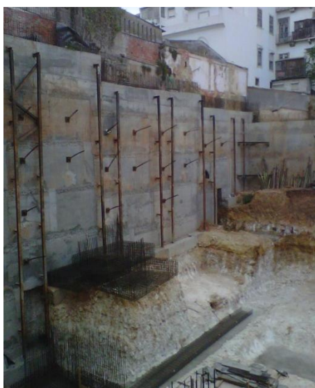
Figura 6.5 - Sapata de fundação
