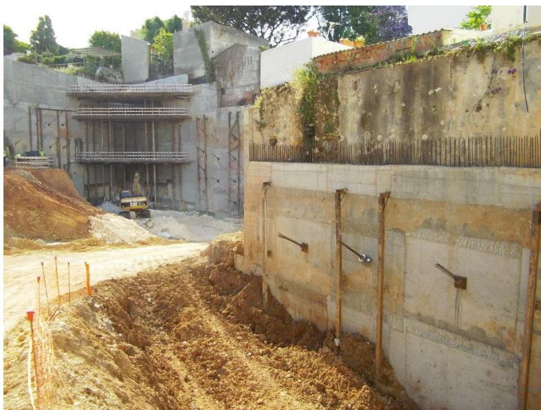
Figura 6.1 - Colocação de perfis metálicos verticais HEB
