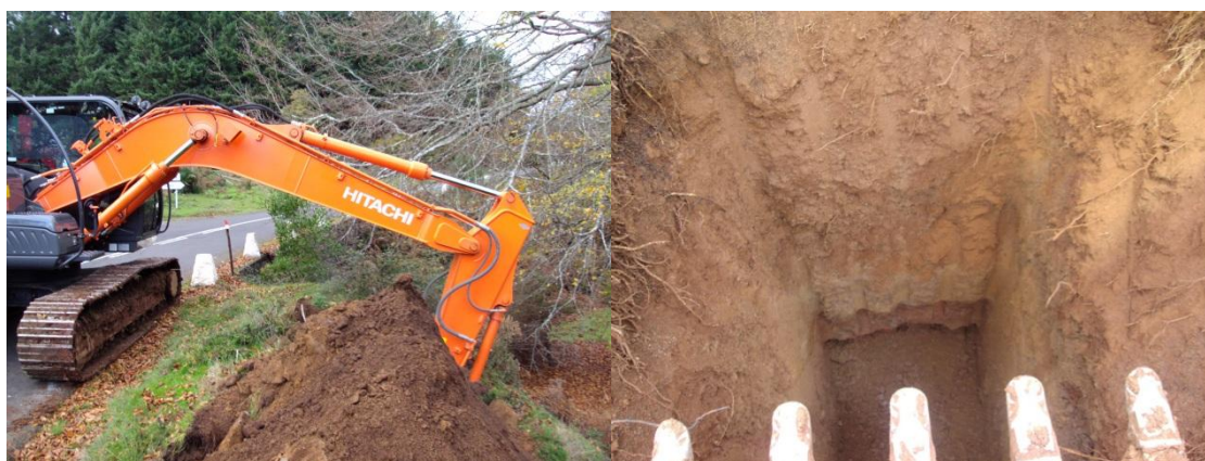
Figura 2.8 - Poço de prospecção executado com meios mecânicos (cortesia Geofix)
