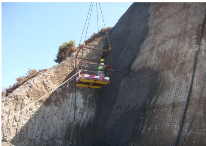
Figura 3.1 - Talude com betão projectado (cortesia Geofix)
