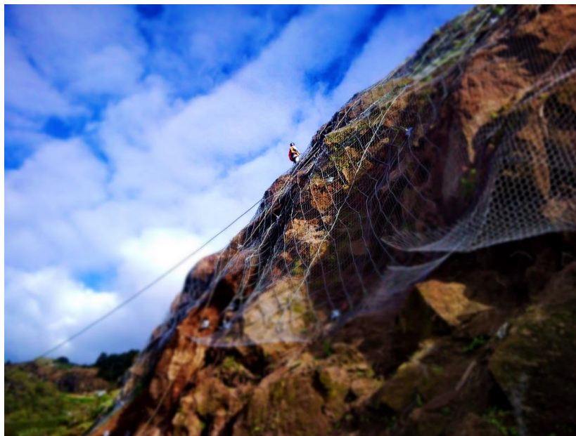
Figura 3.4- Talude com aplicação de rede de dupla torção (cortesia Geofix)
