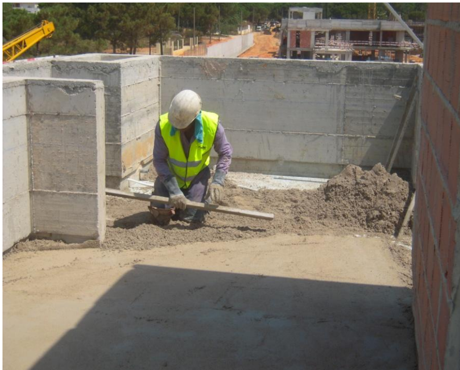
Fotografia 17 – Execução da camada de forma
