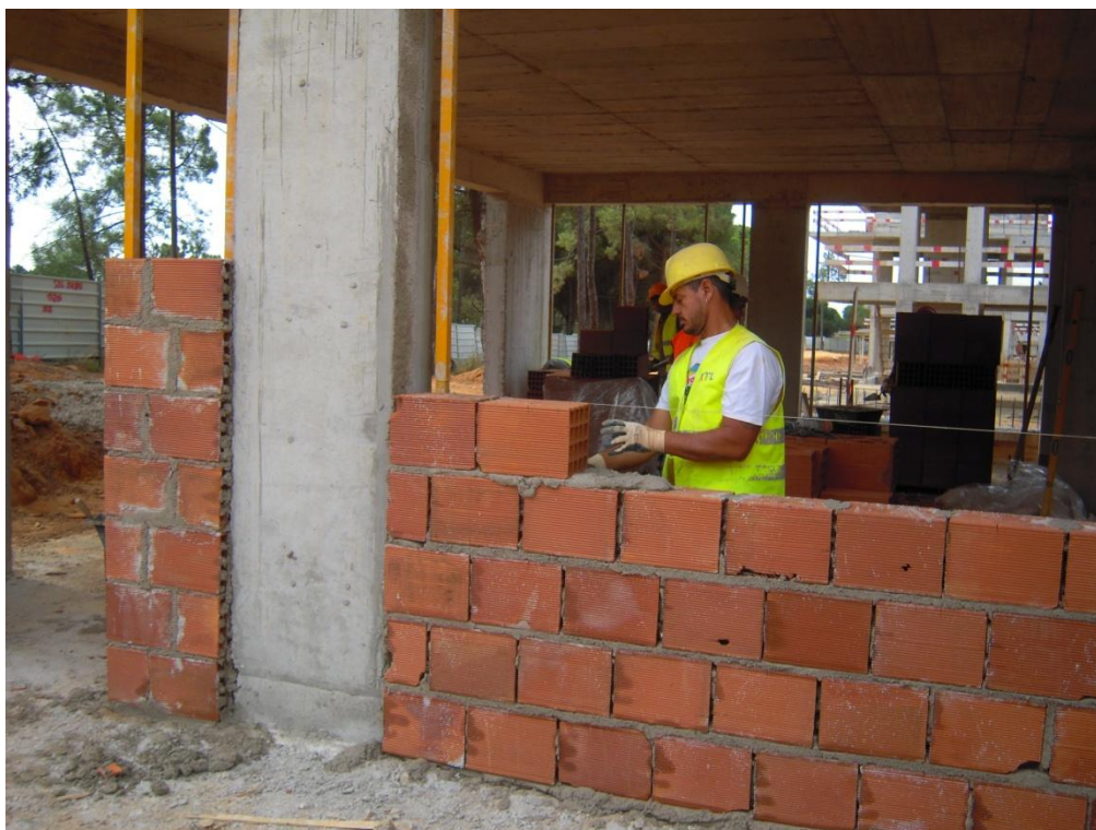
Fotografia 14 – Execução de um pano de alvenaria exterior
