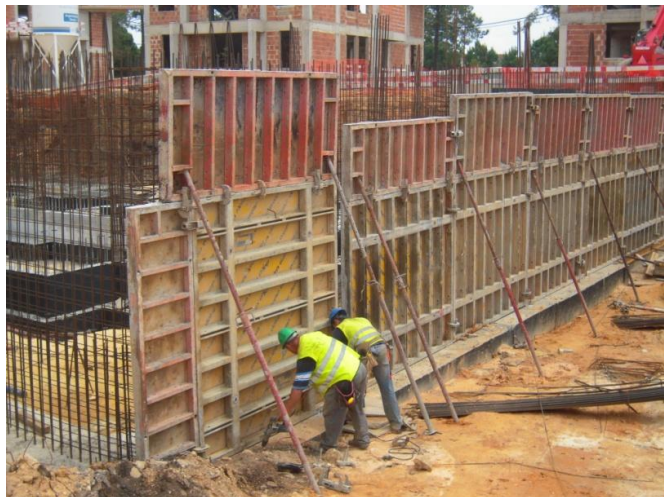
Fotografia 9 – Cofragem de muros periféricos
