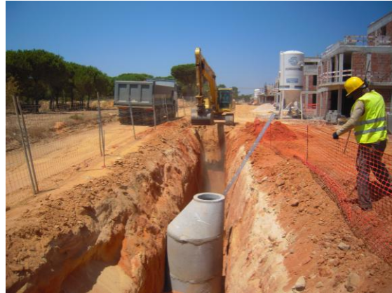
Fotografia 24 - Aplicação de medidas de segurança em escavações.
