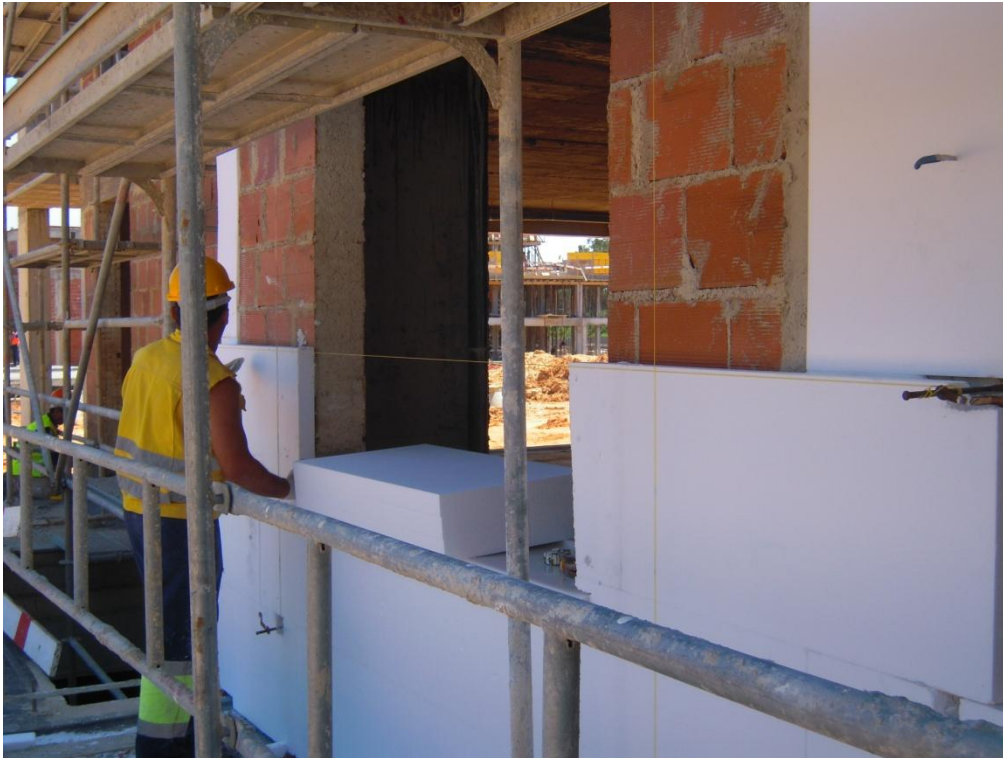
Fotografia 21 – Aplicação do revestimento exterior
