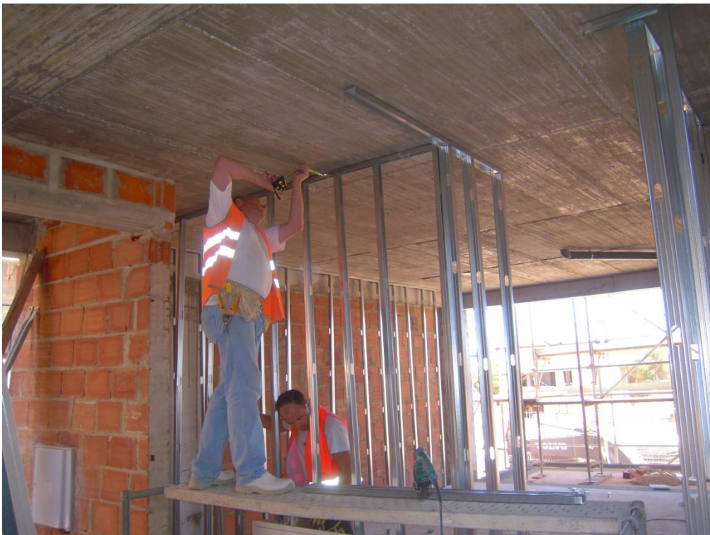
Fotografia 16 – Fixação dos suportes em alumínio para as placas de gesso cartonado
