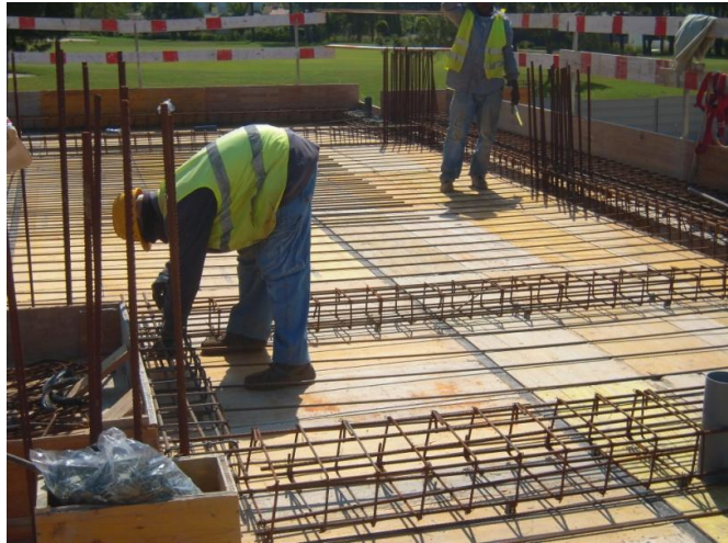
Fotografia 8 – Execução de armadura de uma laje
