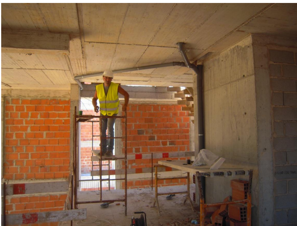
Fotografia 13 – Execução das redes prediais
