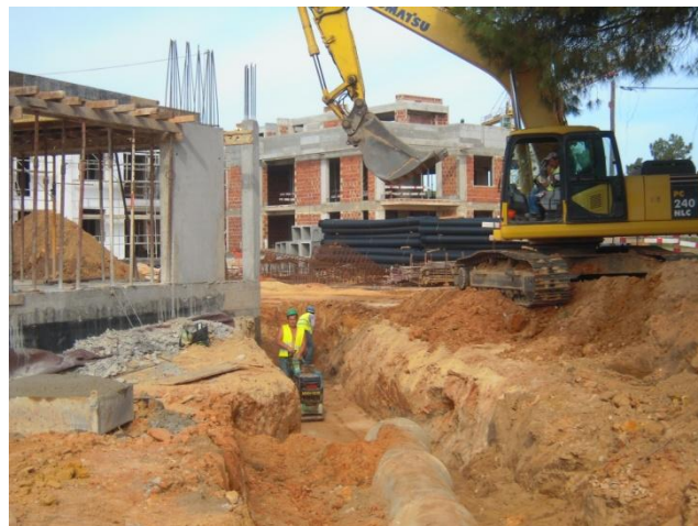
Fotografia 5 - Escavação e preparação do terreno para a correcção da rede.
