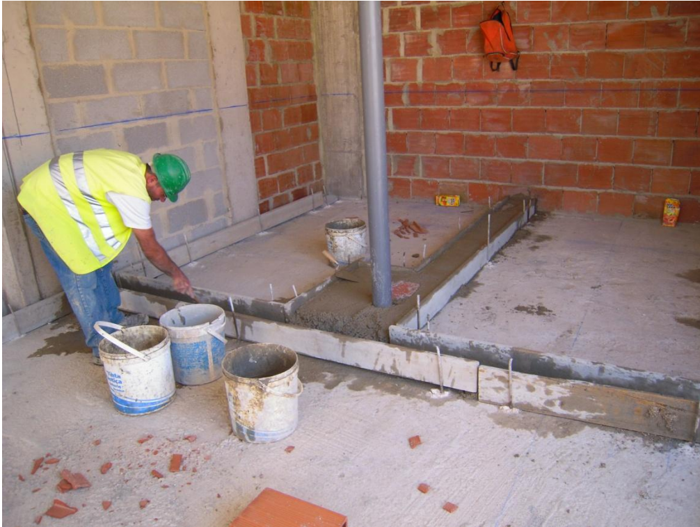
Fotografia 15 – Execução de meio fio
