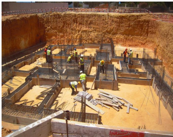
Fotografia 7 - Trabalhos nas armaduras de sapatas e vigas de fundação
