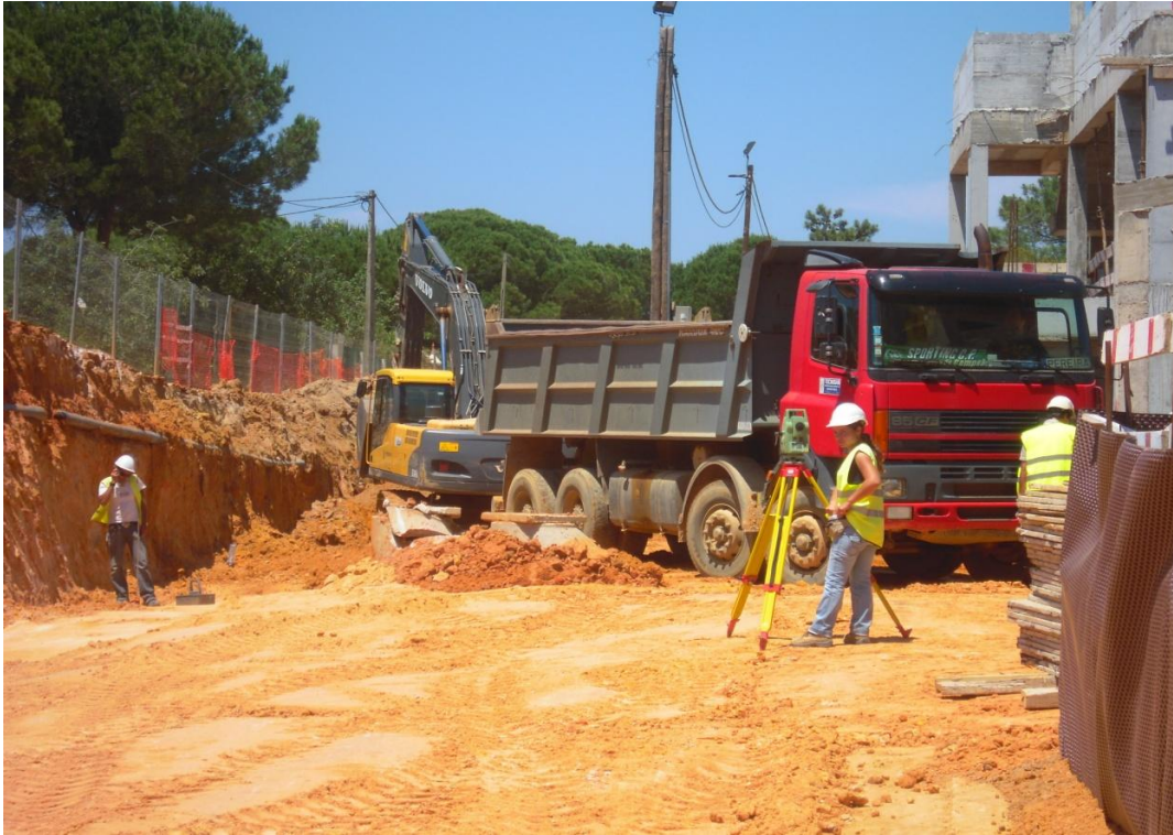
Fotografia 2 – Trabalhos de escavação nos arruamentos exteriores
