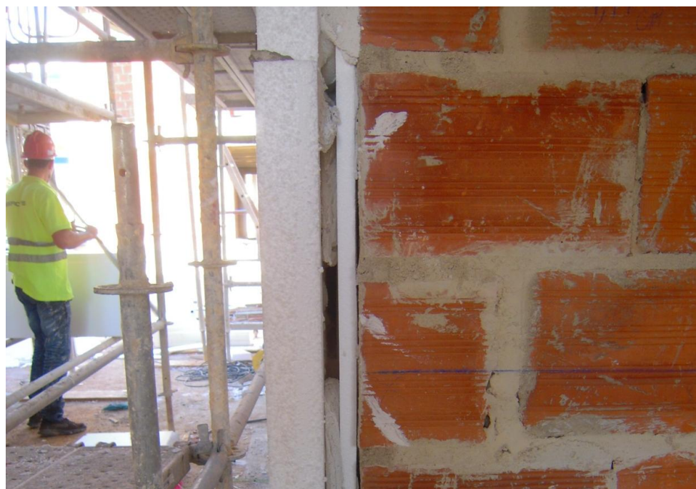
Fotografia 20 – Correção de desvios estruturais utilizando o revestimento exterior
