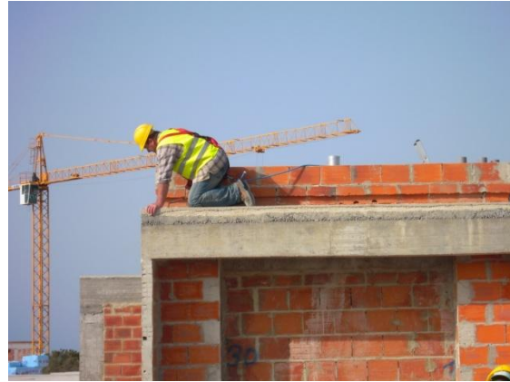
Fotografia 22 - Utilização de EPI, arnês e linha de vida nos trabalhos em altura.
