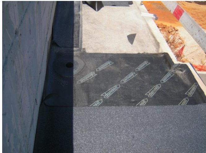
Fotografia 18 – Aplicação de telas asfálticas de impermeabilização
