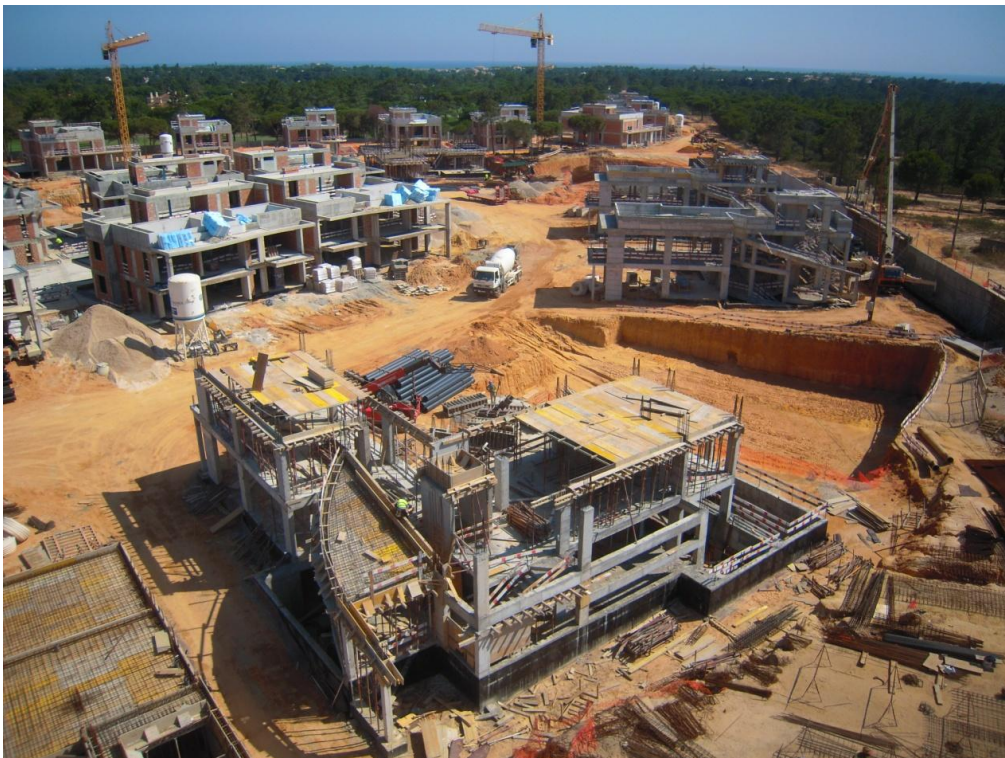
Fotografia 1 – Vista panorâmica do empreendimento, orientação Sul.
