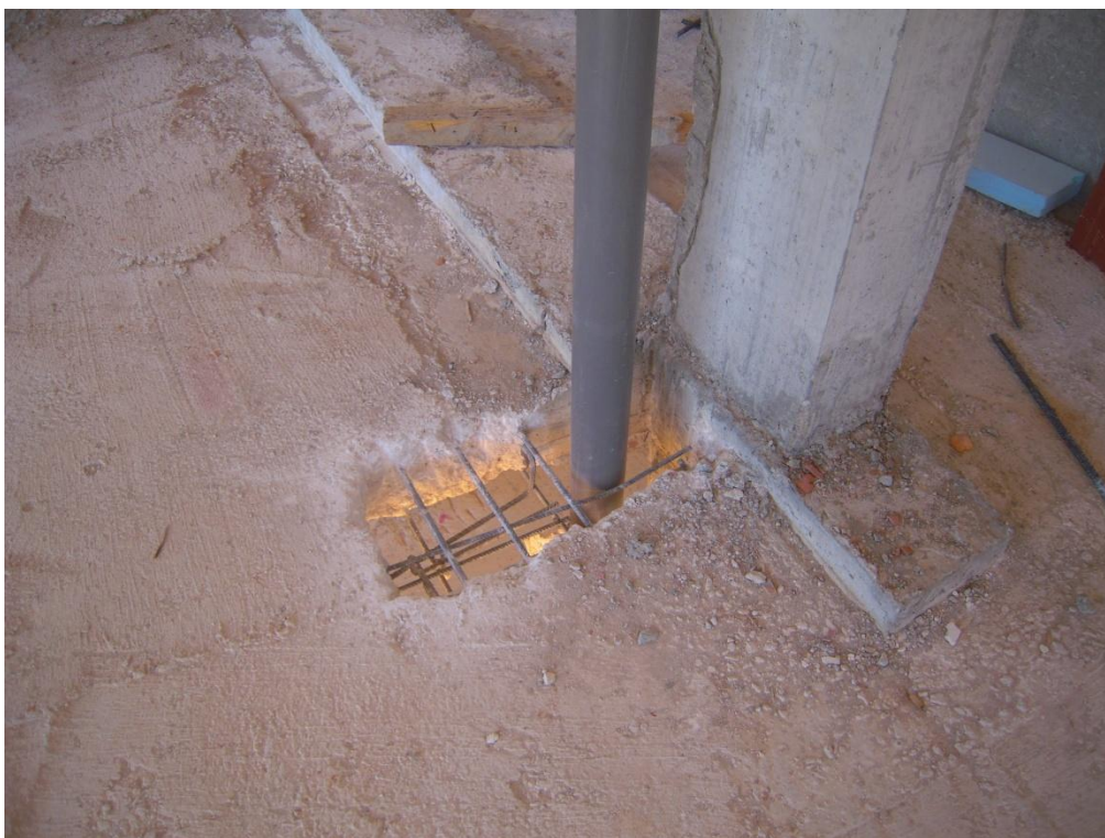
Fotografia 12 – Laje perfurada de forma a passar tubagem da rede pluvial.
