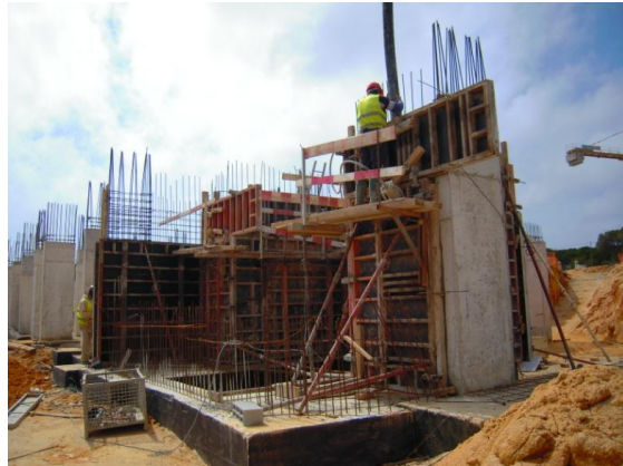
Fotografia 25 - Utilização de medidas de segurança em betonagens.
