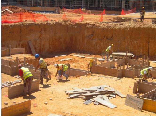
Fotografia 6 - Marcação e cofragem dos elementos de fundação.
