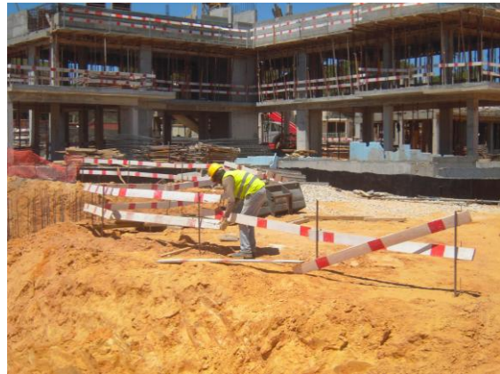
Fotografia 23 – Utilização de EPC, aplicação de tábuas de segurança.
