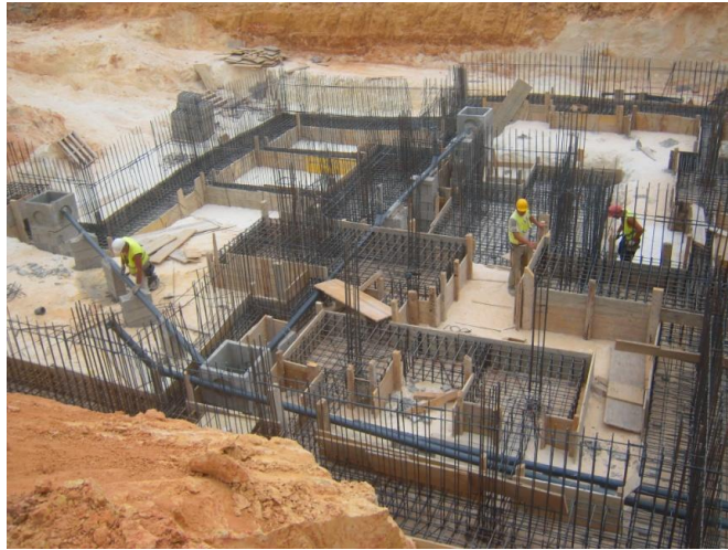
Fotografia 11 – Instalação de tubagem das redes prediais
