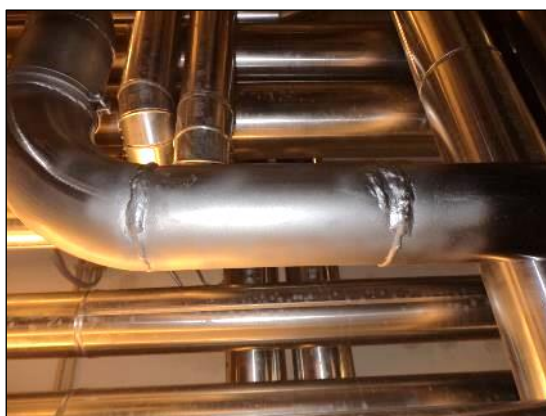
Figura 4.6 - Zonas do circuito com reparação por soldadura.
