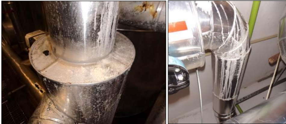
Figura 4.3 - Presença de escorrimentos e depósitos esbranquiçados sobre os revestimentos isolantes de alumínio.
