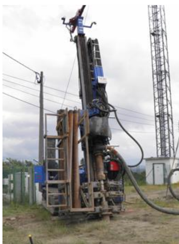
Figura 5.12 – Exemplo de colocação de uma das microestacas
