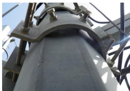
Figura 2.26 – Pormenor de fixação de plataforma em torre multifacetada
