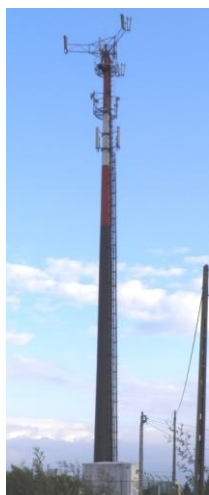
a) Vista geral da torre
