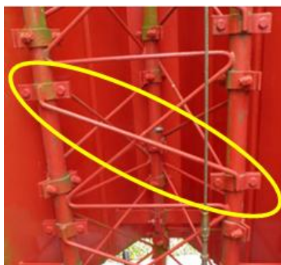
Figura 4.2 – Exemplo de barra de reforço em torre treliçada
