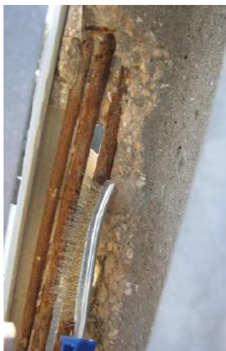
Figura 4.5 – Escovagem de varões após remoção de betão desagregado
