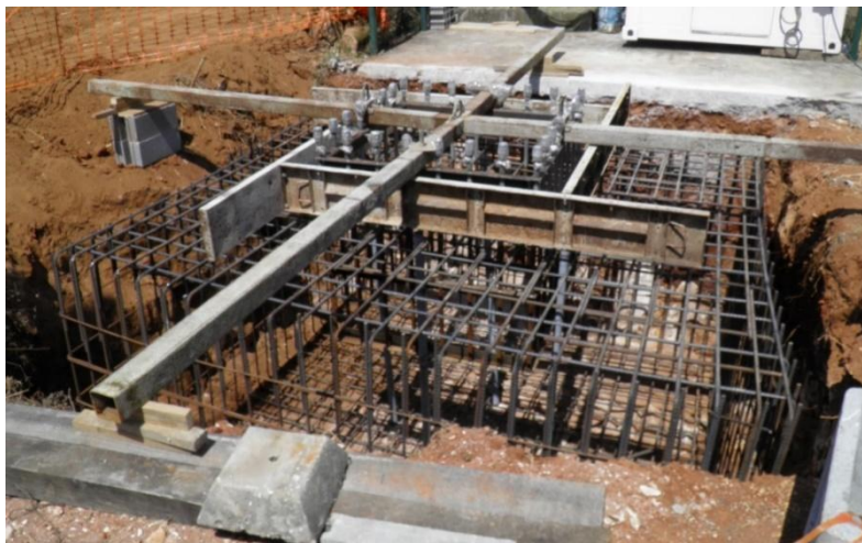
Figura 2.6 – Armaduras e chumbadouros de fundação de torre autossuportada
