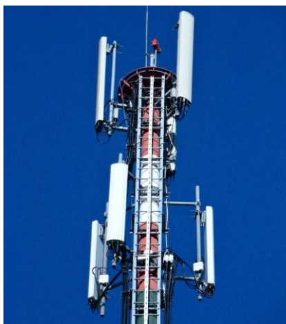
Figura 2.33 – Interfaces fixos ao fuste
