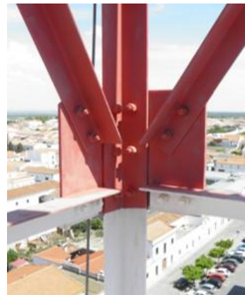
Figura 2.12 – Ligação entre montantes em cantoneira
