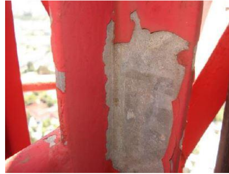
Figura 3.16 – Destacamento da película de tinta numa cantoneira
