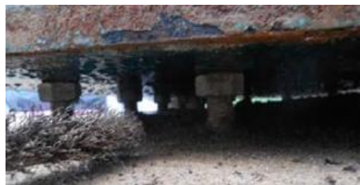
Figura 4.13 – Escovagem dos varões dos chumbadouros
