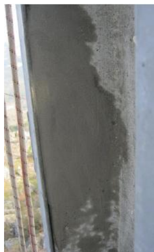
Figura 4.6 – Aplicação de argamassa
