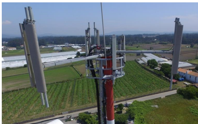
Figura 2.30 – Braços de afastamento fixos à plataforma
