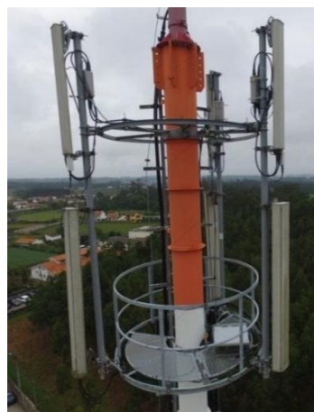
Figura 2.32 – Sistema de plataforma e anel superior
