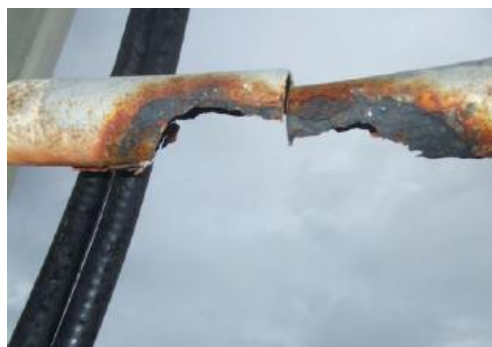
Figura 4.10 – Exemplo de varandim com perda de secção
