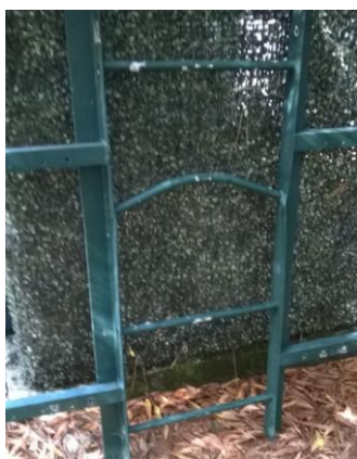
Figura 4.7 – Exemplo de degrau empenado
