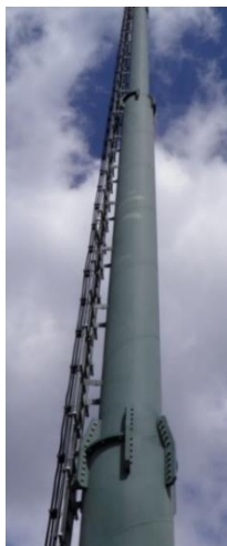
Figura 2.1 – Torre metálica de secção tubular
