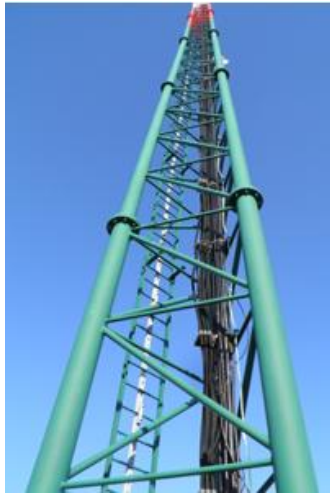
Figura 2.9 – Torre treliçada triangular
