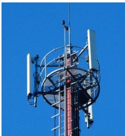
Figura 2.24 – Plataforma simples com varandim
