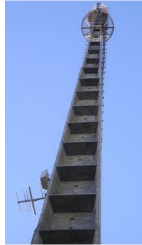
Figura 2.18 – Torre de betão de secção H
