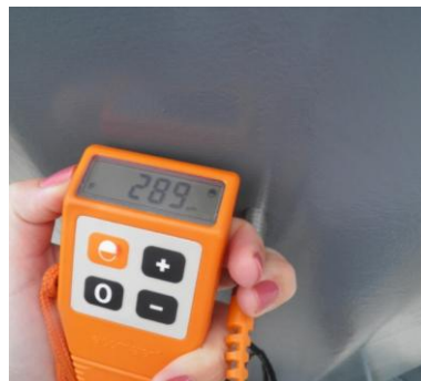
Figura 3.17 – Medição de espessura de película de tinta no fuste de uma torre metálica
