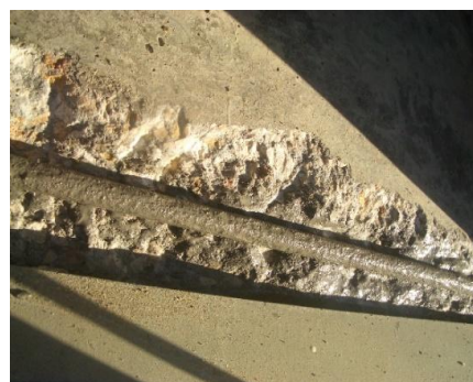
b) Aplicação de inibidor de corrosão na armadura
