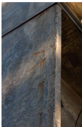
Figura 5.21 – Varões horizontais à vista
