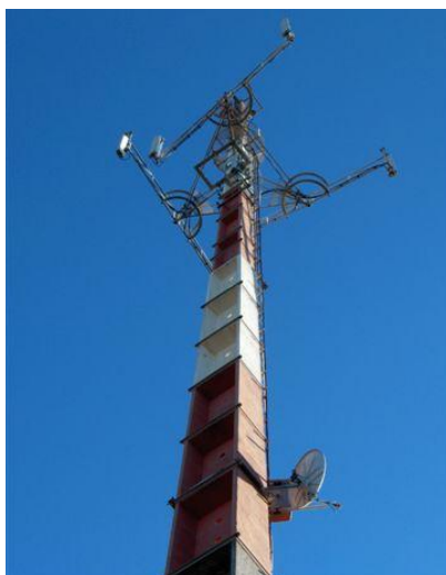
Figura 5.19 – Vista geral da torre de Montedor
