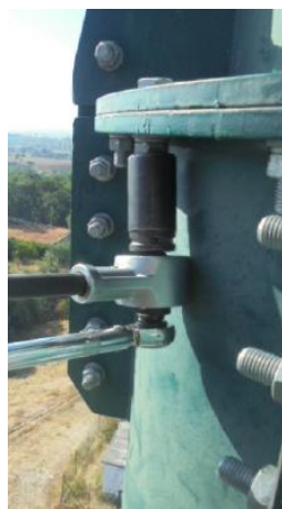
Figura 5.14 – Aperto dos ligações aparafusadas entre troços
