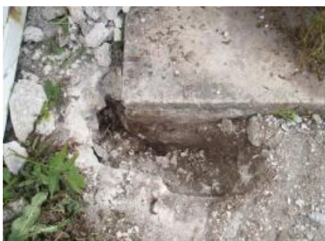
Figura 5.7 – Remoção de laje junto ao maciço de fundação
