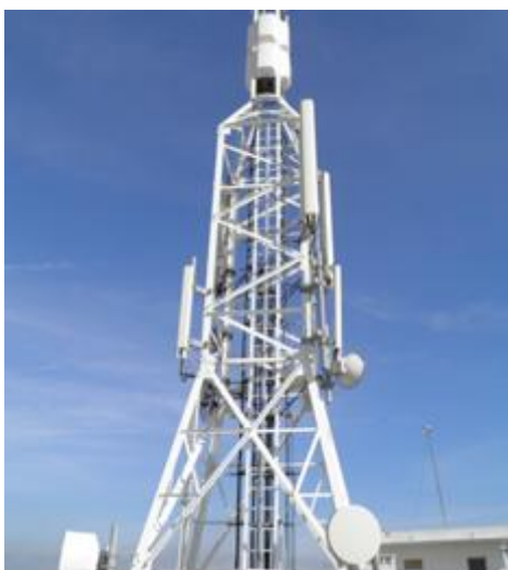
Figura 2.13 – Torre treliçada de secção variável em altura
