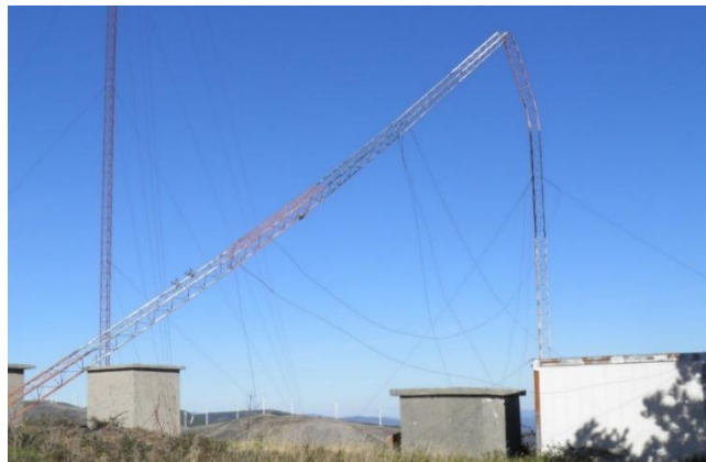
Figura 3.4 – Colapso de torre espiada
