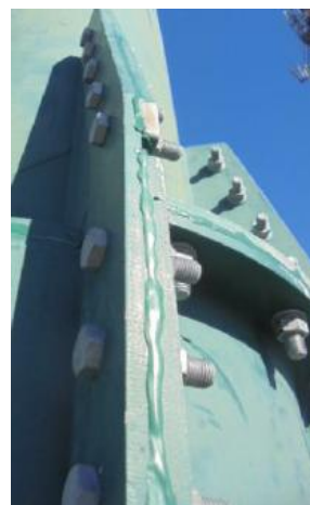
Figura 5.15 – Vedante colocado nas flanges
