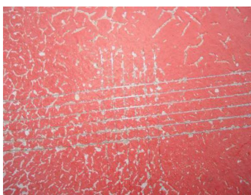
Figura 3.18 – Exemplo de ensaio de quadrícula no fuste de torre
