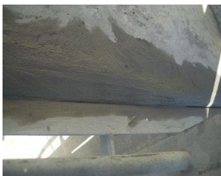
c) Reperfilamento da secção
