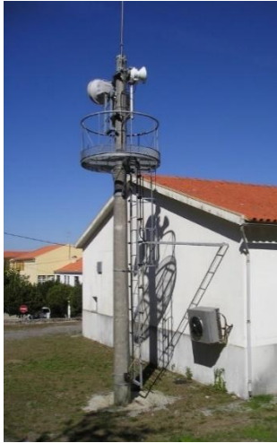
Figura 2.17 – Torre de betão de secção circular
