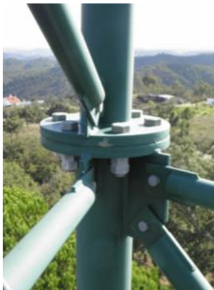
Figura 2.11 – Ligação entre montantes em bolacha
