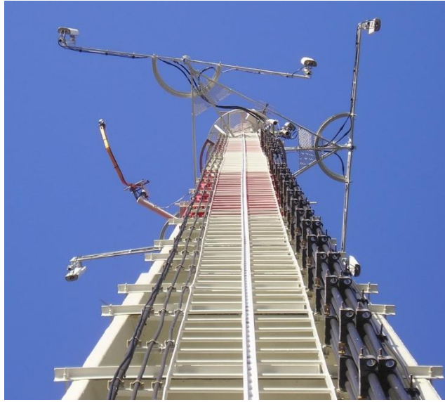
Figura 5.26 – Vista final da torre de Montedor após conservação
