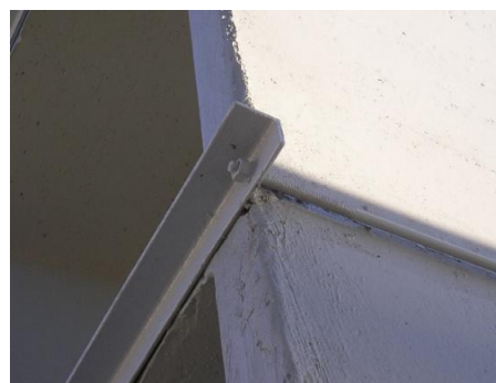
d) Revestimento por pintura
