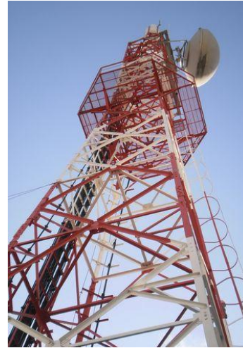
Figura 2.10 – Torre treliçada quadrangular
