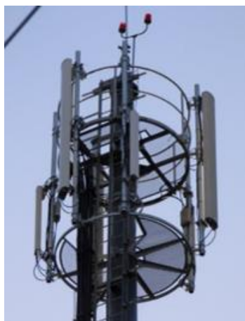
Figura 2.31 – Sistema de plataformas duplo, com varandim em apenas uma
