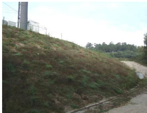
Figura 5.6 – Vista do aterro onde se encontra implantada a estação
