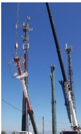
Figura 5.13 – Posicionamento dos dois troços superiores
