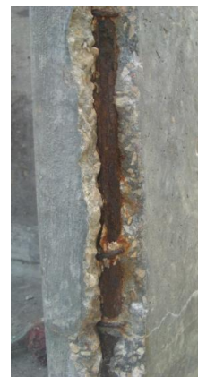
Figura 5.22 – Esboroamento do betão, com varão corroído
