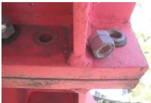
Figura 3.10 – Ligação sem sistema de aperto
