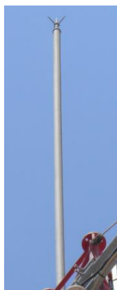
Figura 2.35 – Exemplo de para-raios
