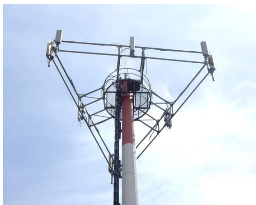
Figura 2.28 – Interface tipo cabeça triangular
