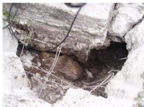
Figura 5.8 – Pedras graníticas sobre o maciço de fundação da torre
