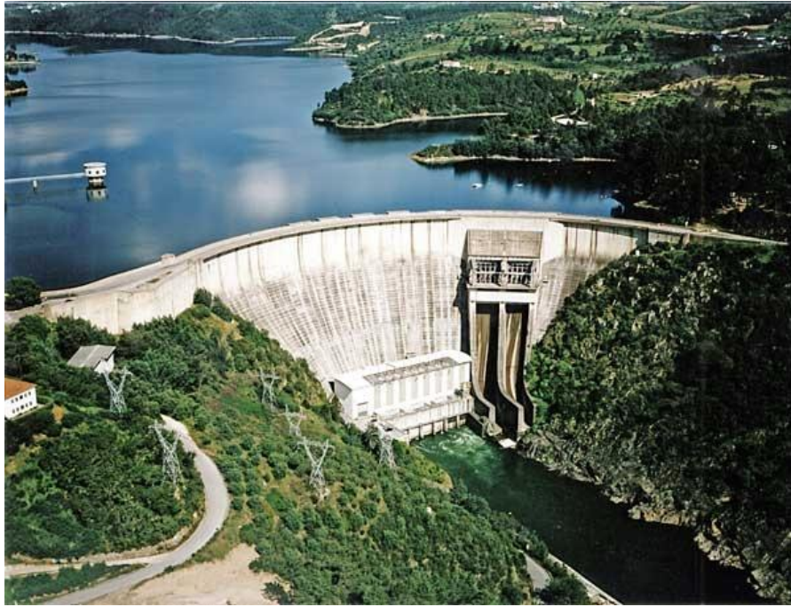
Figura 2.3 - Central Hidroelétrica de Castelo de Bode. [84]
