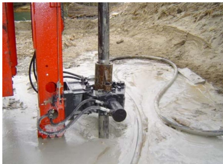
Figura 2.37 – Material rejeitado à superfície [26]
