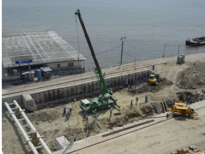
Figura 3.19 – Vista da obra da estação do metro Terreiro do Paço [56]
