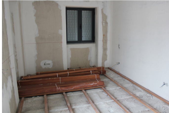
Figura 26 - Sarrafos fixos à betonilha através de cola [40]
