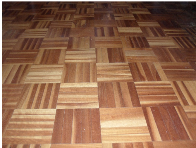
Figura 31 - Revestimento de piso em parquet
