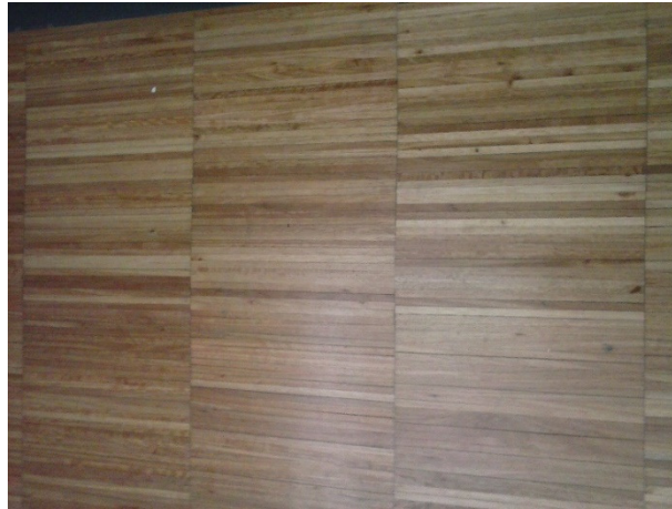
Figura 33 - Revestimento de piso em parquet industrial
