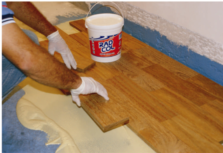
Figura 28 - Aplicação de soalho por colagem [42]
