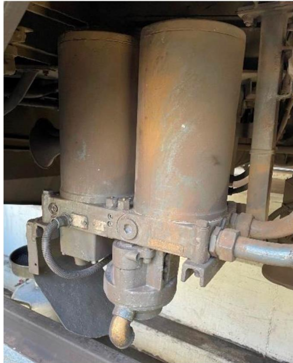
Figura 6.12 - Torre de secagem (A4).
