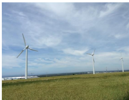
Figura 2.34 – Parque eólico de Sines, Portugal (1992) [20].
