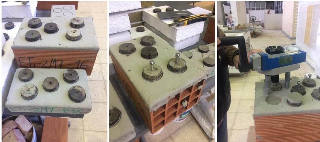
Figura 4.33 a), b) e c) - Montagem do aparelho de arrancamento.
