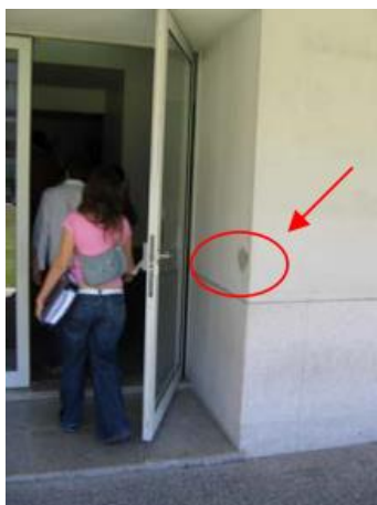
Figura 2.12 - Lacuna de material provocada pelo choque da porta [19].
