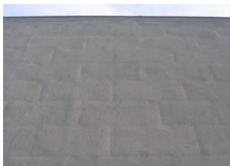
Figura 2.11 - Visualização de juntas entre placas de isolante [19].
