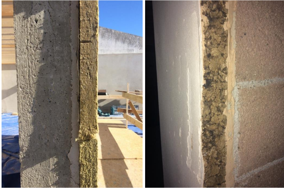
Figura 2.3 - Sistemas ETICS com diferentes isolantes: a) - Lã Mineral, b) - Aglomerado de cortiça expandida.
