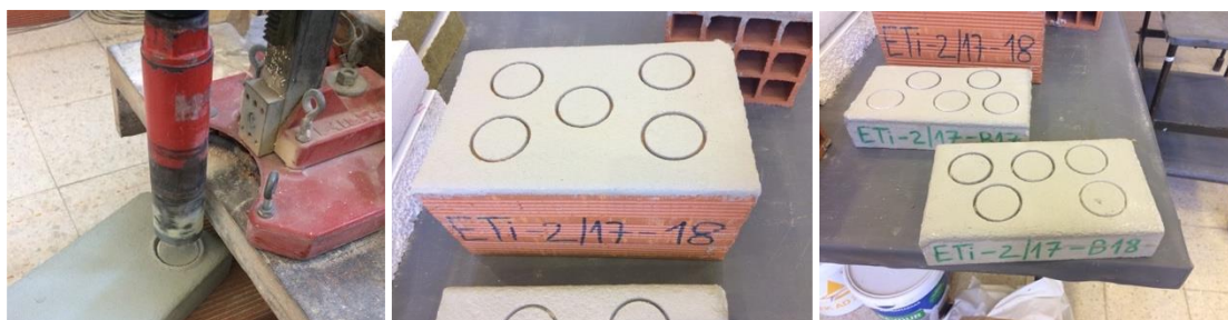
Figura 4.30 a), b) e c) - Execução de carotes nos provetes.
