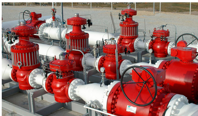
Figura 2.2 Linha convencional de redução de pressão num PRM (Pietro Fiorentini S.p.a., 2015)
