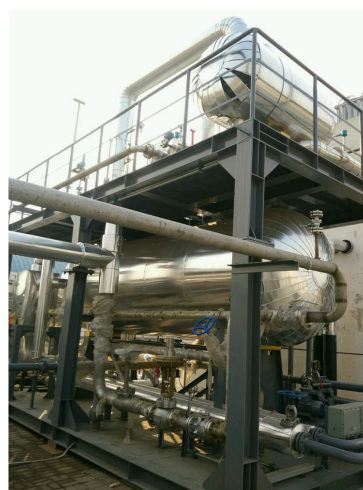
(b) Tanque de óleo lubrificante
