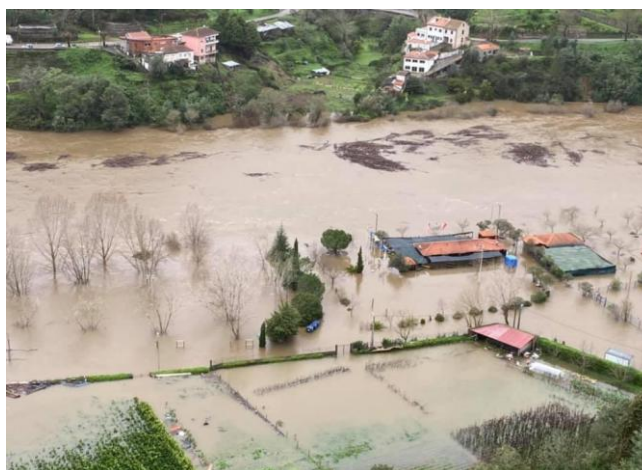
Figura 2.3 – Rotura de dique fluvial no rio Mondego, em 2019 (TVI, 2019)
