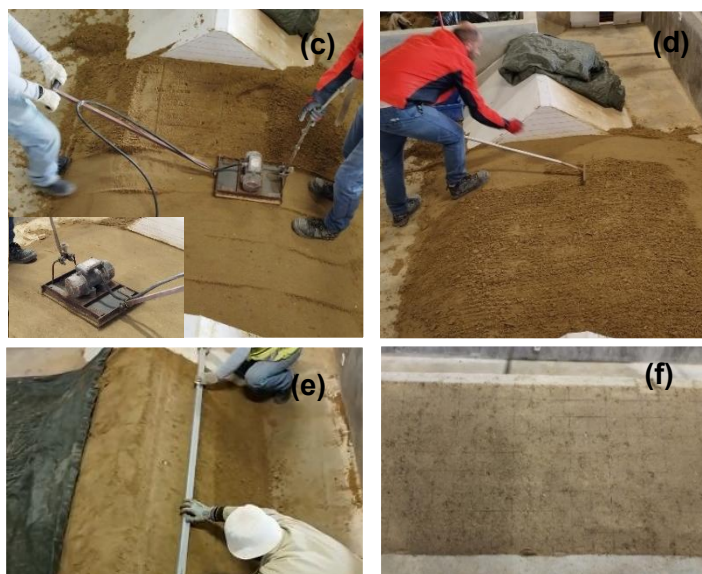
Figura 4.6 – Passos para a construção do dique
