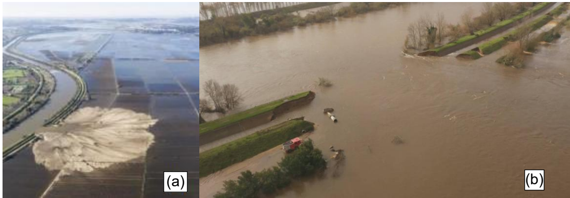
Figura 1.1 – (a) e (b) Exemplo de imagens da rotura do 1º dique do Mondego ocorrida no dia 22 de dezembro de 2019 (Lusa A., 2020)
