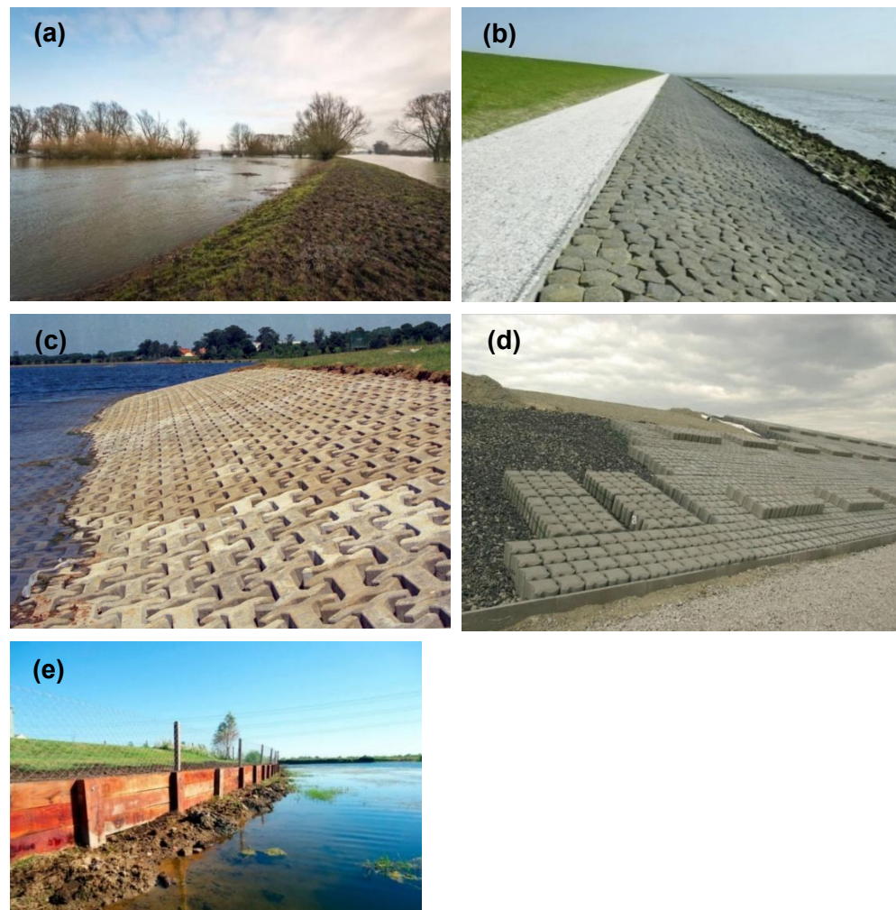
Figura 2.6 – Tipos de diques. (a) dique de aterro (RuudMorijn, 2018); (b) dique de enrocamento (iStock, 2016); (c) dique pré-fabricado (rpc, 2023); (d) dique pré-fabricado com camada de cimento (Joziassse, 2009); (e) dique de estacas (Maderas Ruta 25, 2013)
