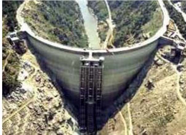
Figura 2.7: Barragem do Cabril, vista da albufeira vazia e da torre de tomada de água.
