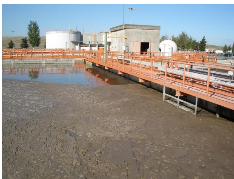
Figura 16 – Sistema de lamas ativadas da ETAR de Beirolas
