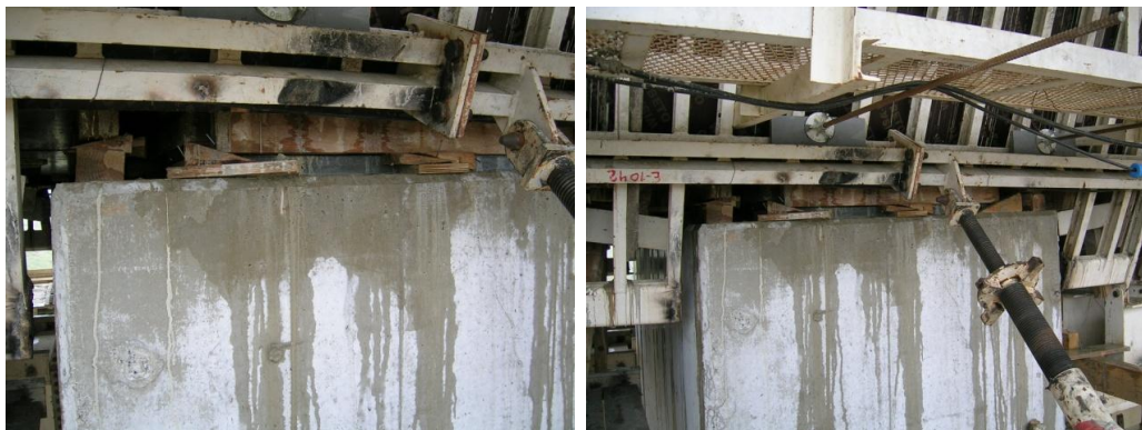
(À Esq.) Figura 2.41 – Travamento dos Aparelhos de apoio durante fase de betonagem, (Viaduto 1).
