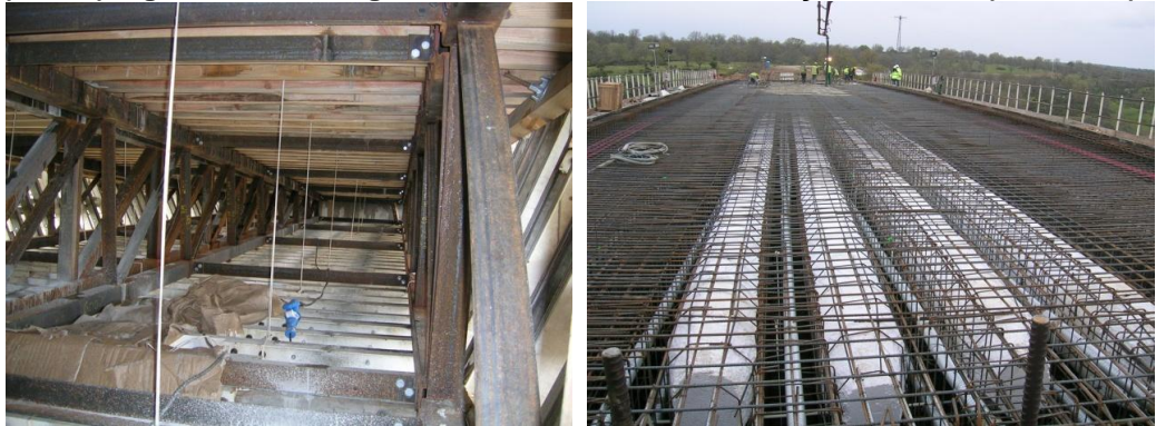
(À Esq.) Figura 2.5 – Cofragem inferior da nervura de secção variável, (Viaduto 1).
