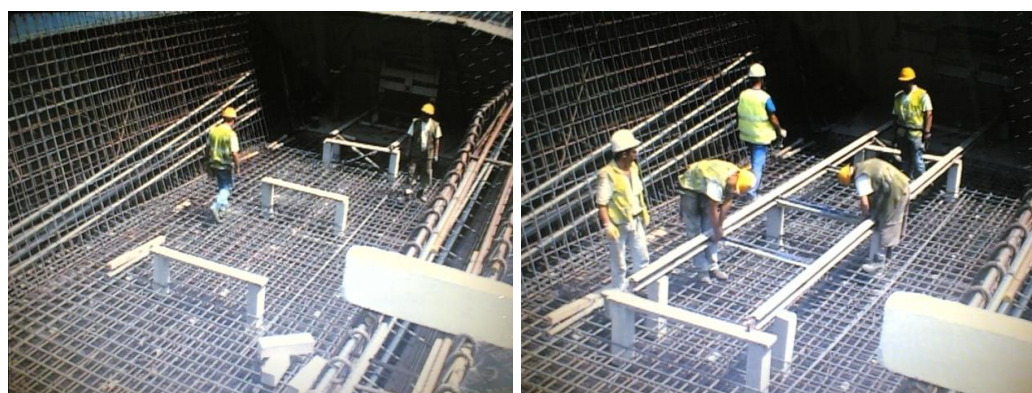
(À Esq.) Figura 3.14 – Colocação de espaçadores para colocação de carris, (Viaduto 2).
