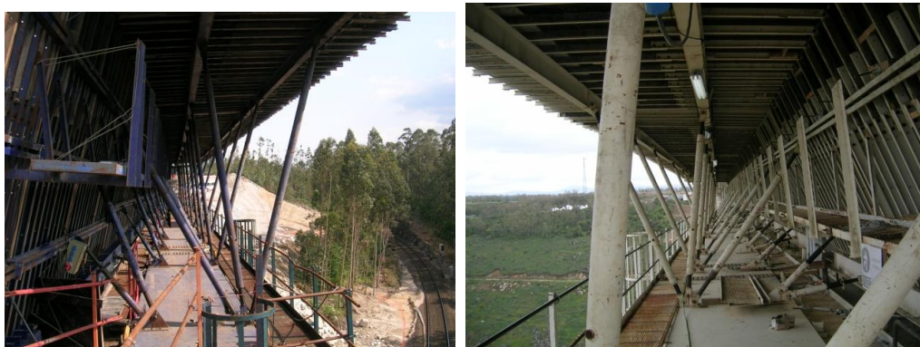
(À Esq.) Figura 2.32 – Estrutura lateral exterior de cofragem e escoras de fixação, (Viaduto 2).
