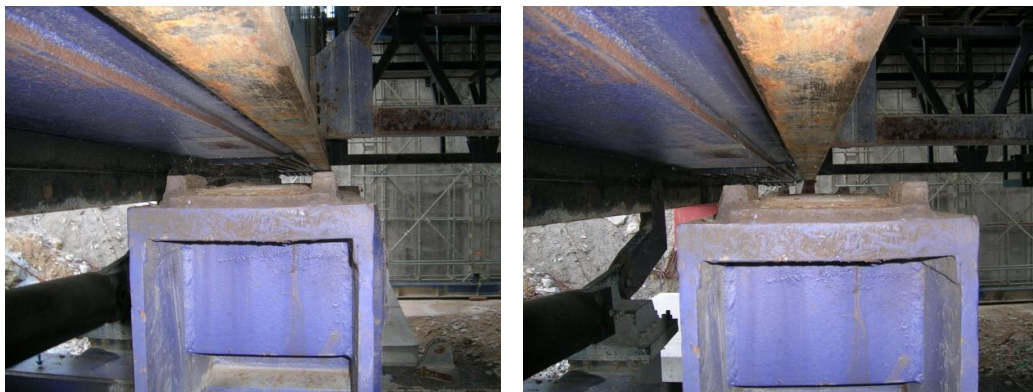
(À Esq.) Figura 2.54 – Boggies e calha de deslizamento, (Viaduto 2). (À Dta.) Figura 2.55 – Boggies e calha de deslizamento, (Viaduto 2).
