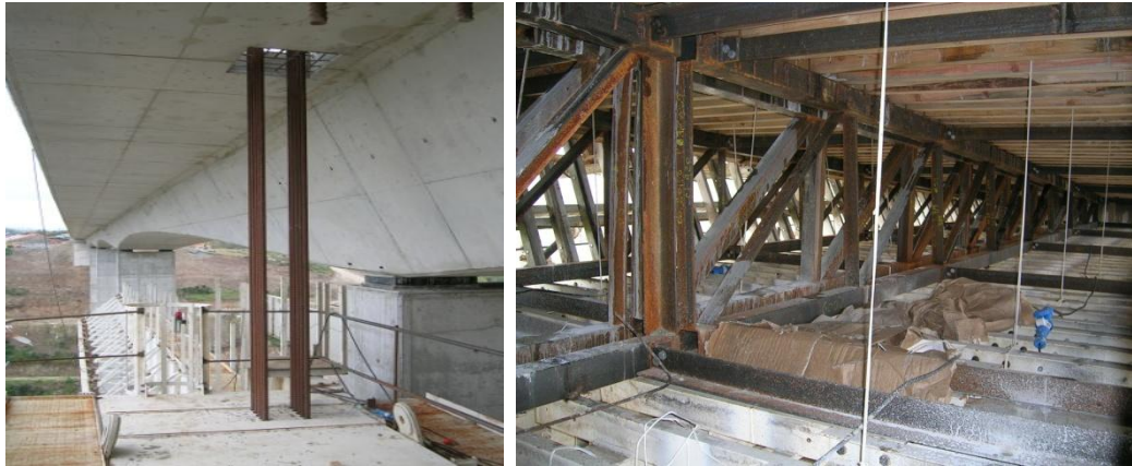
(À Esq.) Figura 2.3 – Tabuleiro com nervura única com secção variável aligeirada, (Viaduto 1).
