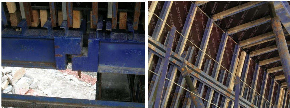
(À Esq.) Figura 2.30 – Estrutura base de cofragem, (Viaduto 2).
