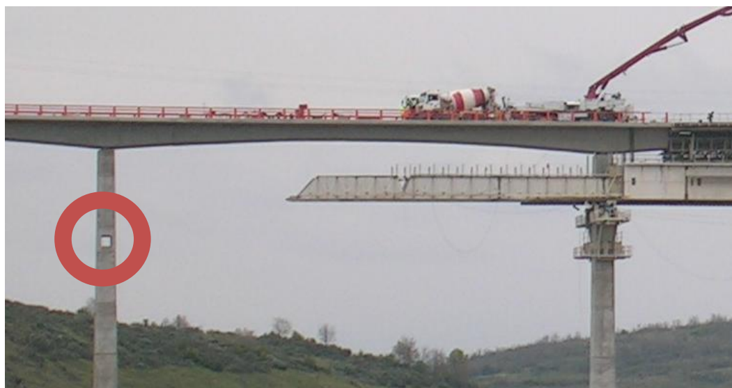
Figura 2.45 – Consolas montadas em negativos, (Viaduto 1).
