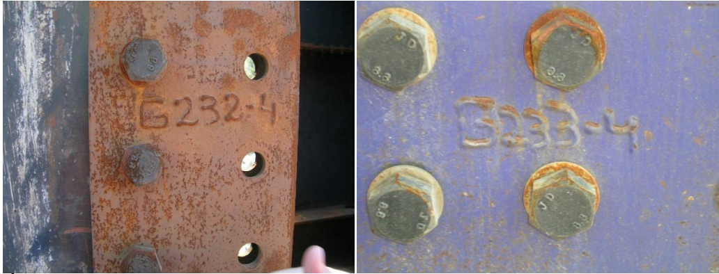
(À Esq.) Figura 3.3 – Código numérico para a montagem da V.L., (Viaduto 2). (À Dta.) Figura 3.4 – Código numérico para a montagem da V.L., (Viaduto 2).
