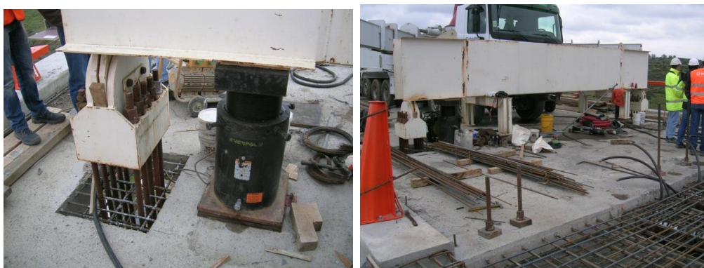
(À Esq.) Figura 2.28 – Hidráulico de 500ton que suporta a traseira da viga e/ou o pórtico de suporte dependendo da fase de construção, (Viaduto 1).
