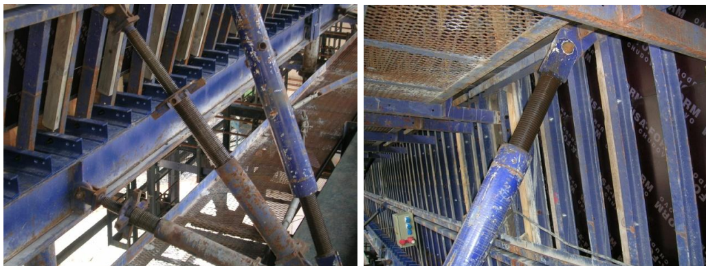
(À Esq.) Figura 2.43 – Escoras, (Viaduto 2).
