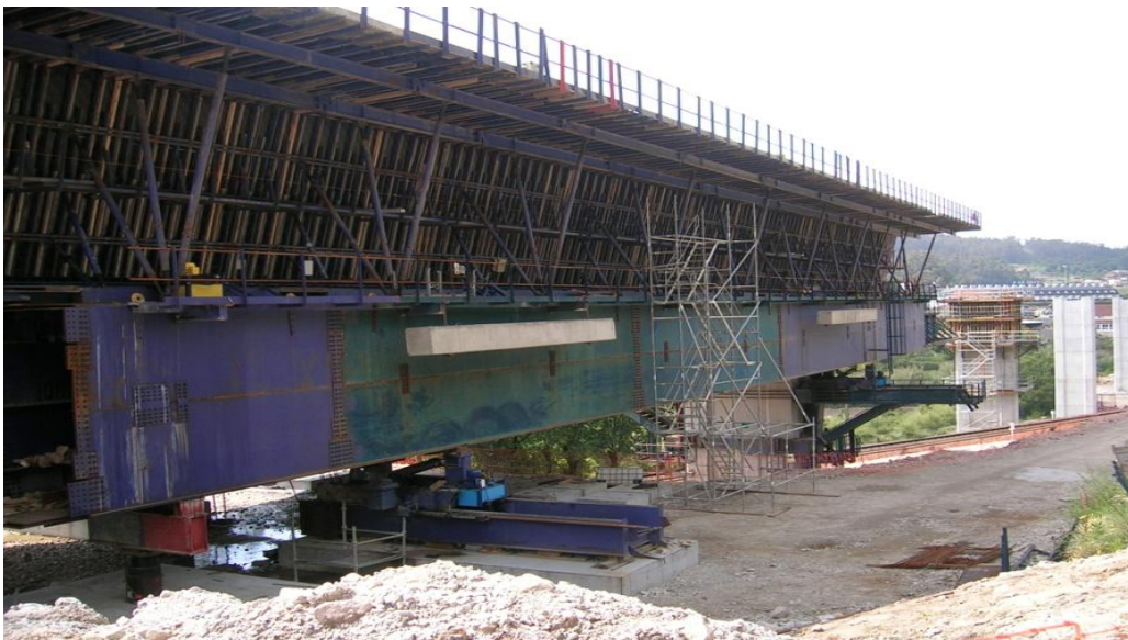
Figura 3.5 – Aspecto visual após montagem da V.L. no primeiro vão construir.
