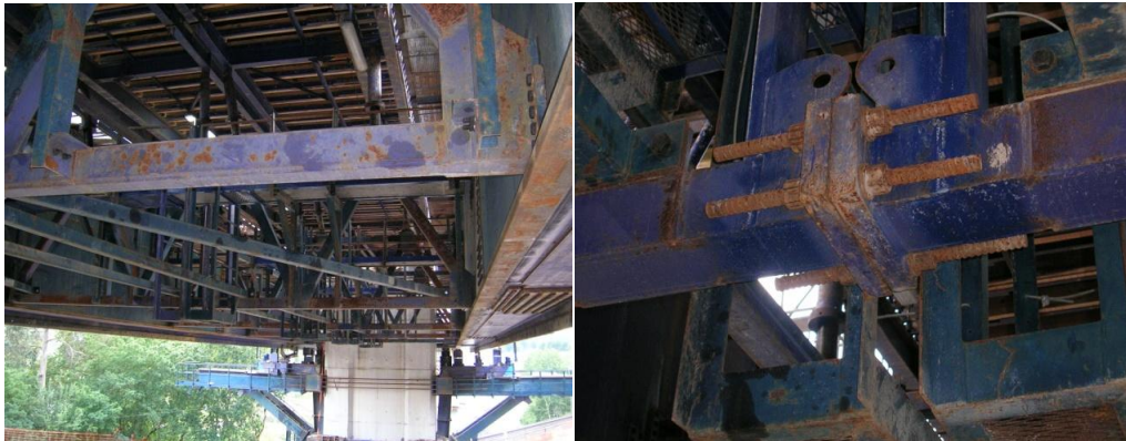
(À Esq.) Figura 3.6 – Vigas transversais unidas através de barras "dywidag", (Viaduto 2).
