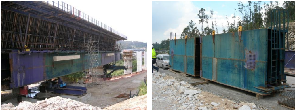
(À Esq.) Figura 2.8 – Viga de Lançamento parcialmente montada, (Viaduto 2). (À Dta.) Figura 2.9 – Parcelas desmontadas das vigas caixaão, (Viaduto 2).
