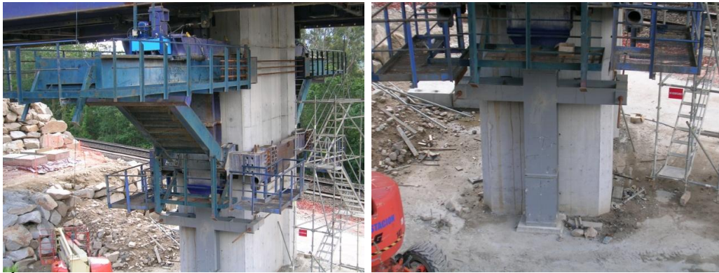
(À Esq.) Figura 2.48 – Estrutura de suporte das consolas, (Viaduto 2). (À Dta.) Figura 2.49 – Estrutura de suporte das consolas, (Viaduto 2).
