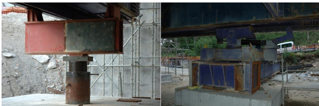
(À Esq.) Figura 3.1 – Hidráulico de elevação da estrutura global da Viga de Lançamento, (Viaduto 2).
