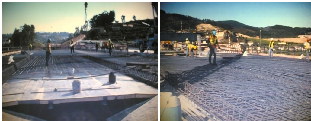
(À Esq.) Figura 3.18 – Colocação de armadura na zona superior do tabuleiro, (Viaduto 2).
