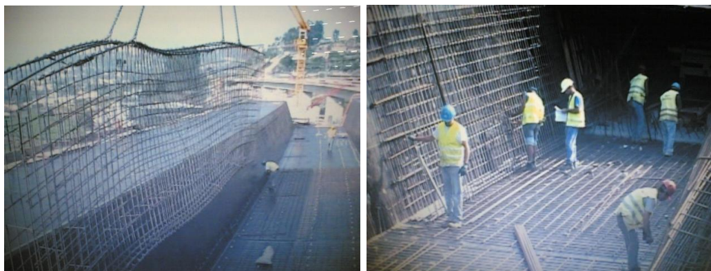
(À Esq.) Figura 3.12 – Colocação de armadura, (Viaduto 2).
