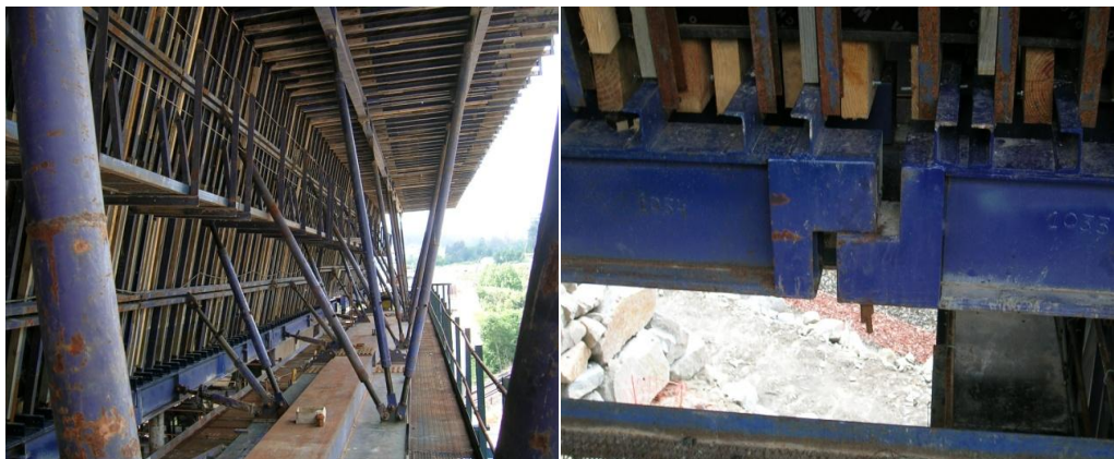
(À Esq.) Figura 3.8 – Escoras de suporte e afinação da estrutura lateral exterior de cofragem, (Viaduto 2).
