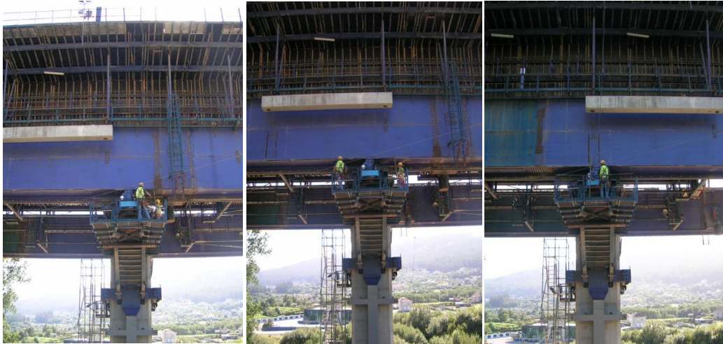
Figura 3.35, 3.36 e 3.37 – Movimentação da V.L., (Viaduto 2).
