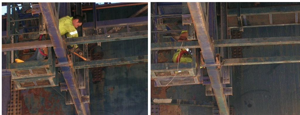
(À Esq.) Figura 3.26 – Remoção das barras dywidag para abertura da V.L., (Viaduto 2).
