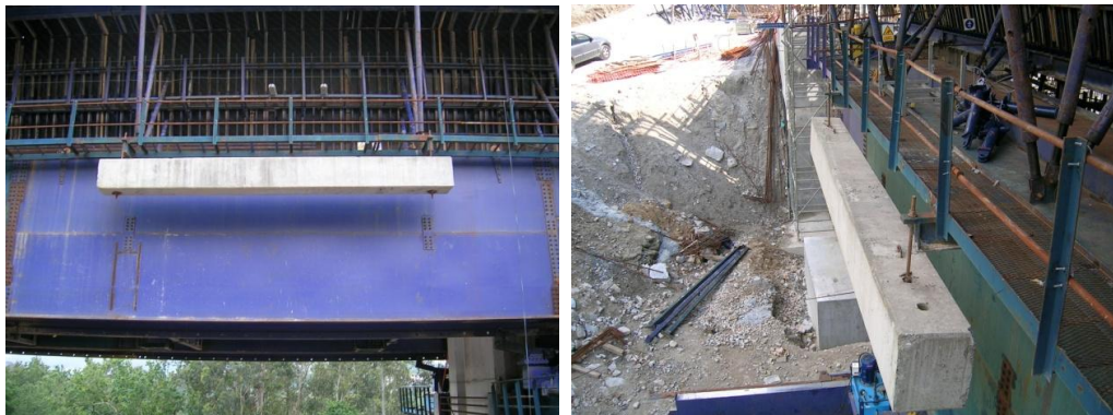
(À Esq.) Figura 2.52 – Contrapeso, (Viaduto 2).
