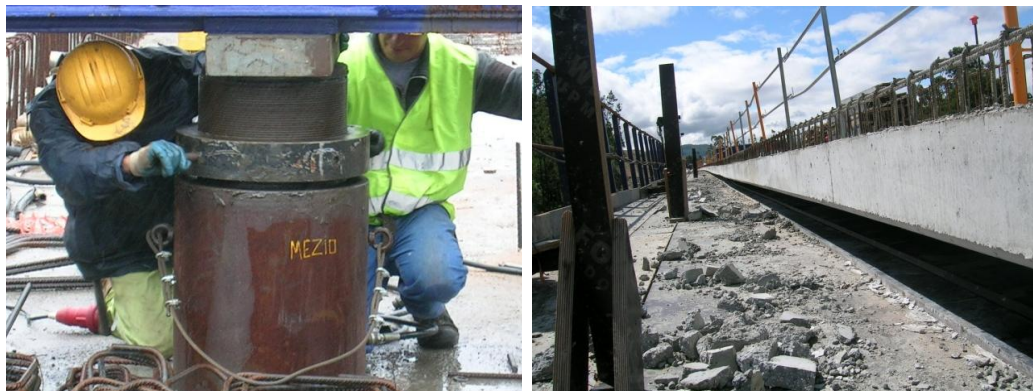
(À Esq.) Figura 3.24 – Abaixamento de hidráulicos de elevação, (Viaduto 2).
