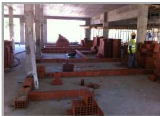
Fig. 201-Execução da primeira fiada
