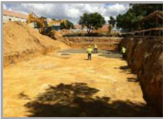
Fig. 124- Colocação de betão de limpeza
