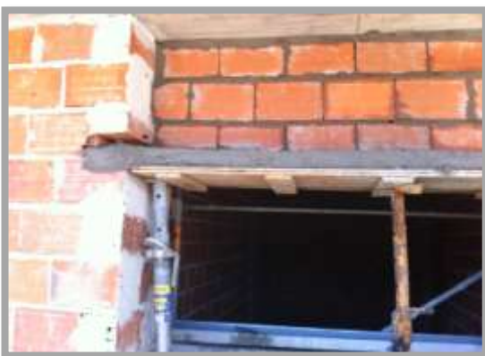
Fig. 208-Execução da padieira
