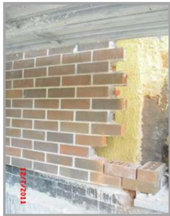
Fig. 233-Execução da parede de tijolo “klinker”
