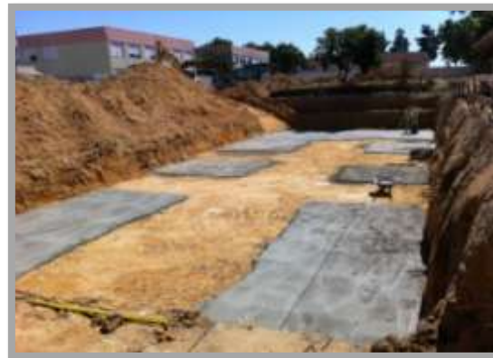
Fig. 125- Colocação de betão de limpeza
