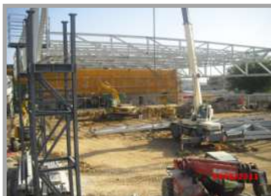
Fig. 171-Pormenor do pilar de montagem
