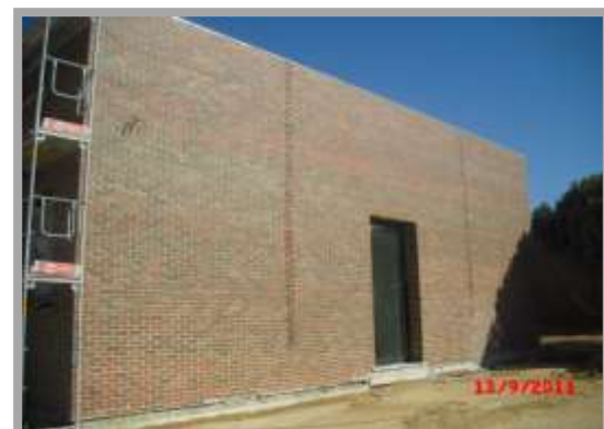
Fig. 235-Parede de tijolo “klinker” concluída.
