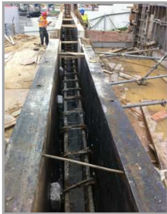
Fig. 112- Colocação de espaçadores
