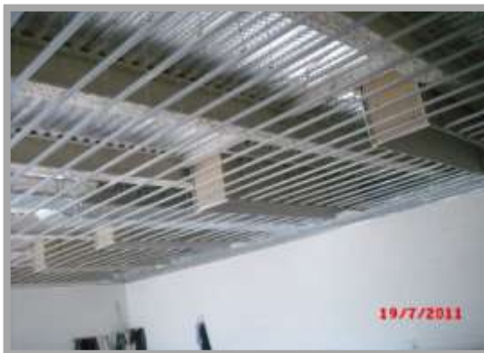
Fig. 230-Execução da estrutura metálica de suporte
