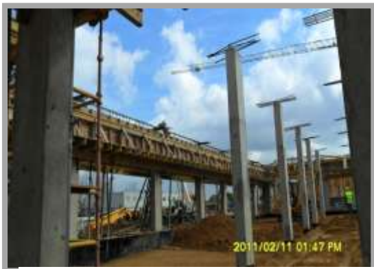
Fig. 146-Pilares de laje fungiforme
