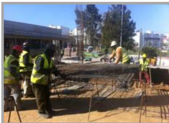
Fig. 140-Armação do pilar
