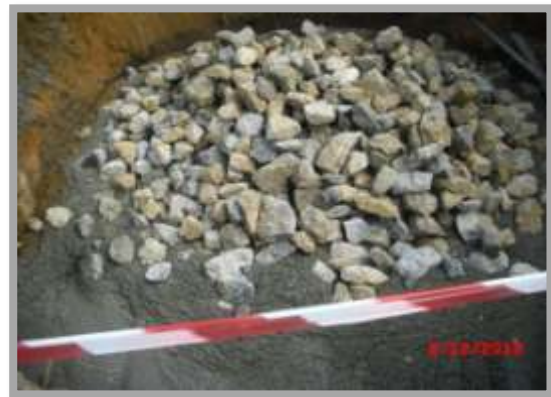
Fig. 121-Colocação de pedra e betão
