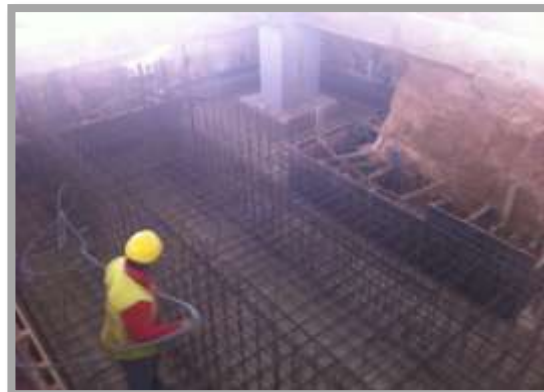
Fig. 82-Limpeza da superfície a betonar
