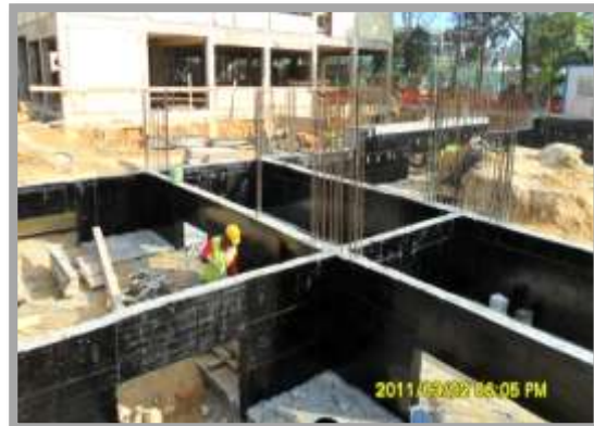
Fig. 139- Pintura betuminosa nos elementos enterrados
