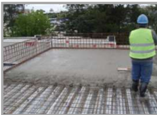
Fig. 163-Betonagem da laje colaborante
