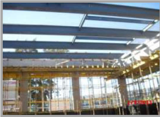
Fig. 154-Colocação dos perfis HEA500
