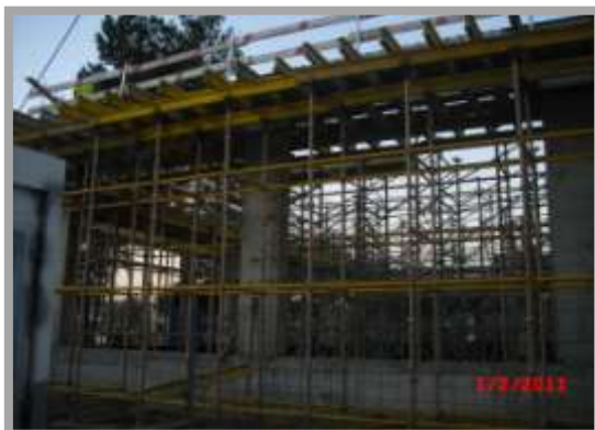
Fig. 152-Execução de viga de bordadura
