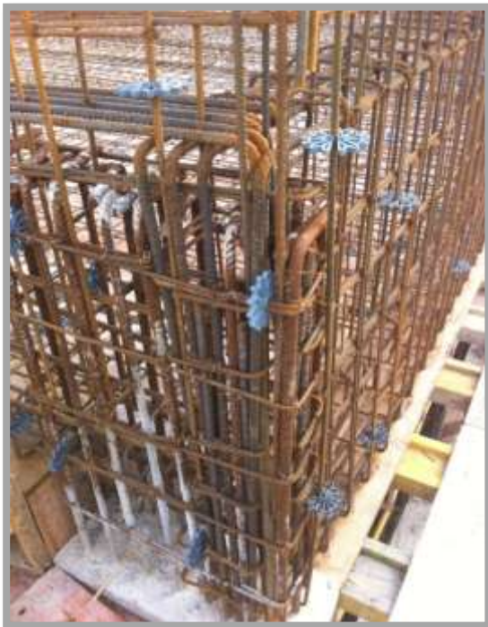
Fig. 111-Colocação de espaçadores
