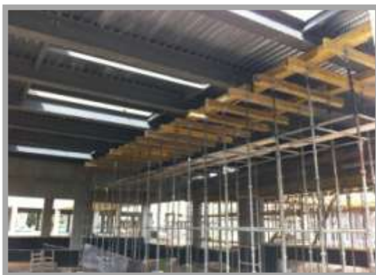
Fig. 160-Colocação de cimbra para execução de contra flecha
