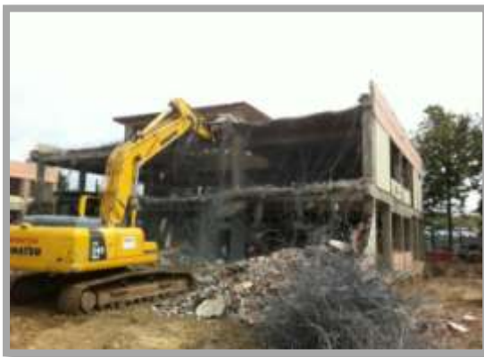
Fig. 93-Demolição bloco B
