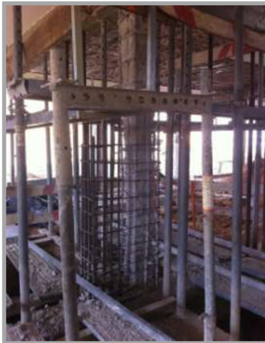
Fig. 90-Colocação de armaduras adicionais
