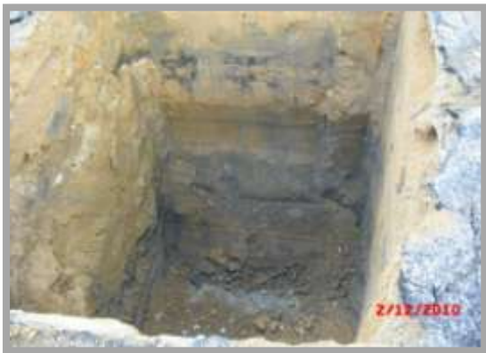
Fig. 120-Escavação de poço
