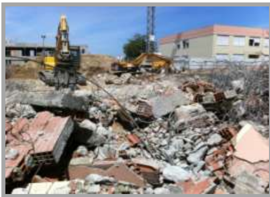
Fig. 95-Demolição bloco B
