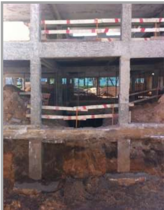
Fig. 79-Sapatas do Bloco C
