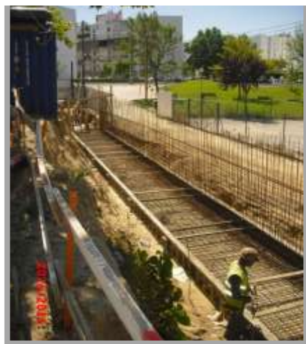
Fig. 183-Execução da armadura de arranque do muro
