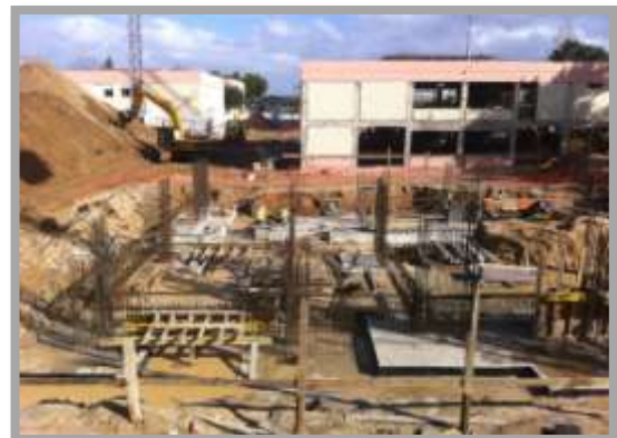
Fig. 45-Fundação do Bloco B
