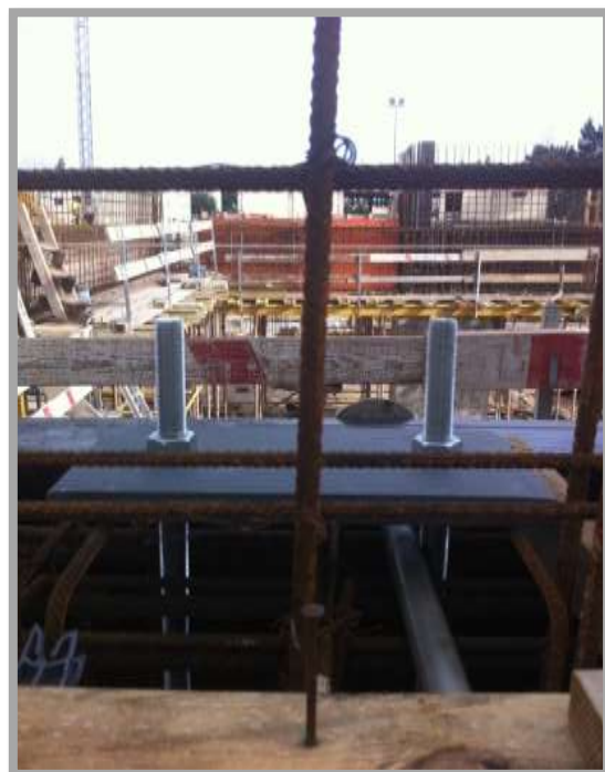
Fig. 153-Colocação dos chumbadores
