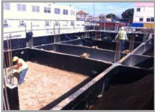
Fig. 136- Pintura betuminosa nos elementos enterrados
