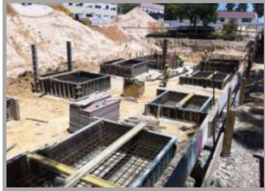
Fig. 129-Colocação de armadura nas sapatas
