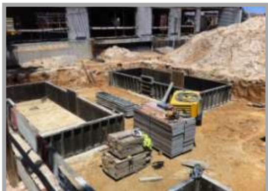
Fig. 126-Colocação da cofragem de sapatas
