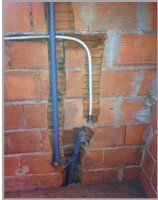
Fig. 214-Execução rede de águas e esgotos
