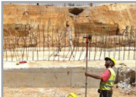
Fig. 127-Marcação dos alinhamentos e eixos dos pilares
