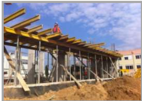
Fig. 145-Lançamento de laje
