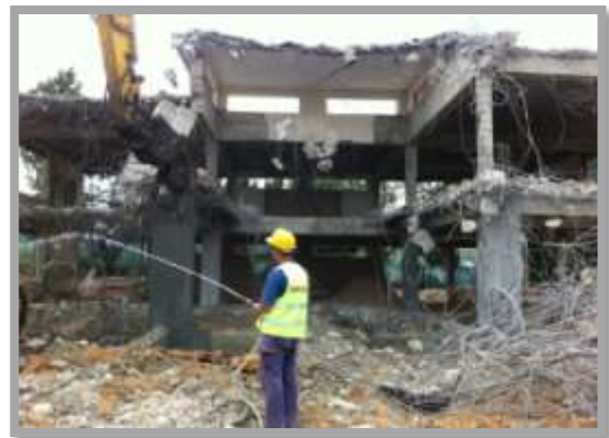
Fig. 94-Demolição bloco B
