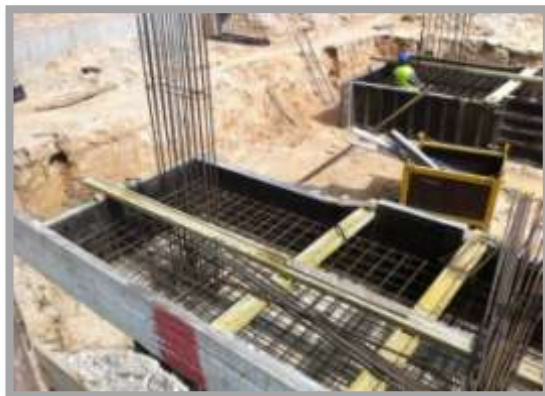
Fig. 130-Colocação do arranque dos pilares
