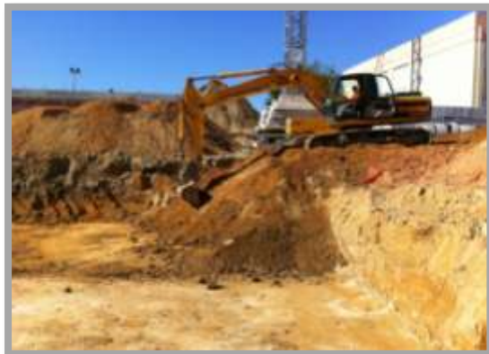
Fig. 71-Escavação com Giratória
