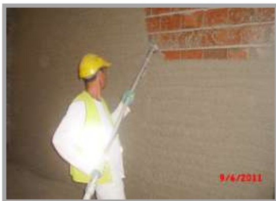
Fig. 223-Execução de estuque
