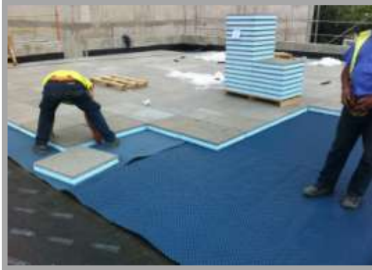
Fig. 228-Colocação das lajetas
