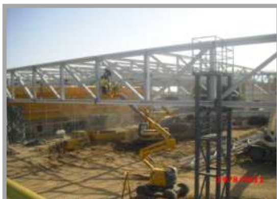
Fig. 170- Montagem da estrutura metálica
