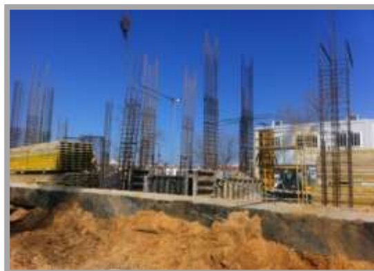
Fig. 141-Colocação da armadura do pilar
