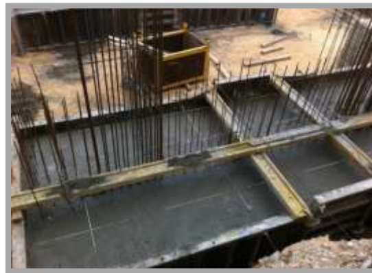
Fig. 133-Pormenor de sapata betonada
