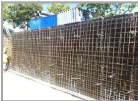
Fig. 184-Execução da cofragem do muro
