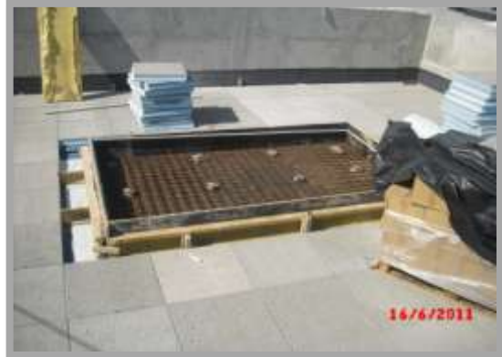
Fig. 229-Execução dos maciços para sistema avac
