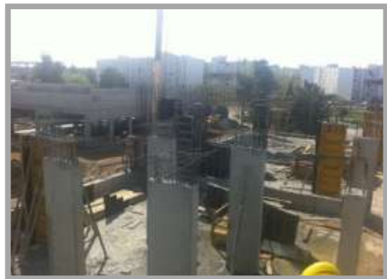
Fig. 147-Pilares de laje fungiforme
