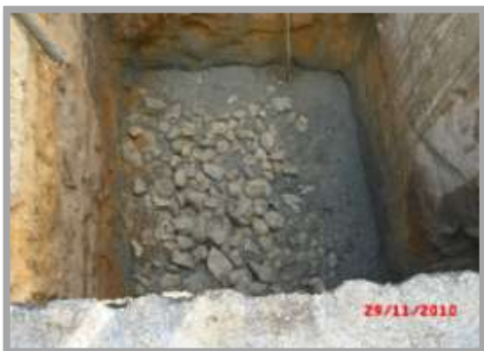
Fig. 122- Colocação de pedra e betão
