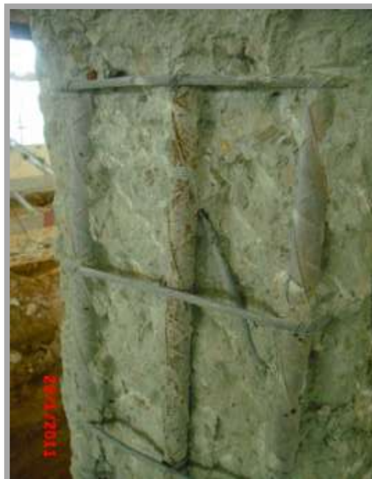
Fig. 89-Pormenor da escarificação do pilar
