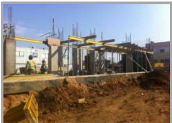
Fig. 144-Lançamento de laje
