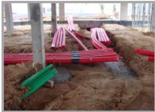
Fig. 189-Execução das infras
