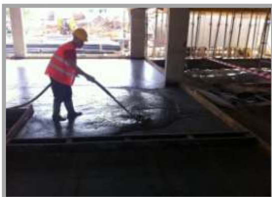
Fig. 198-Execução de betão leve
