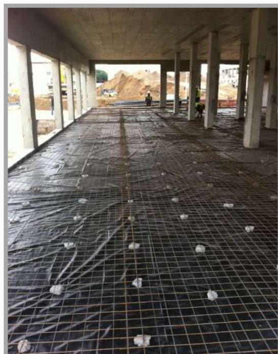
Fig. 191-Colocação de malha sol
