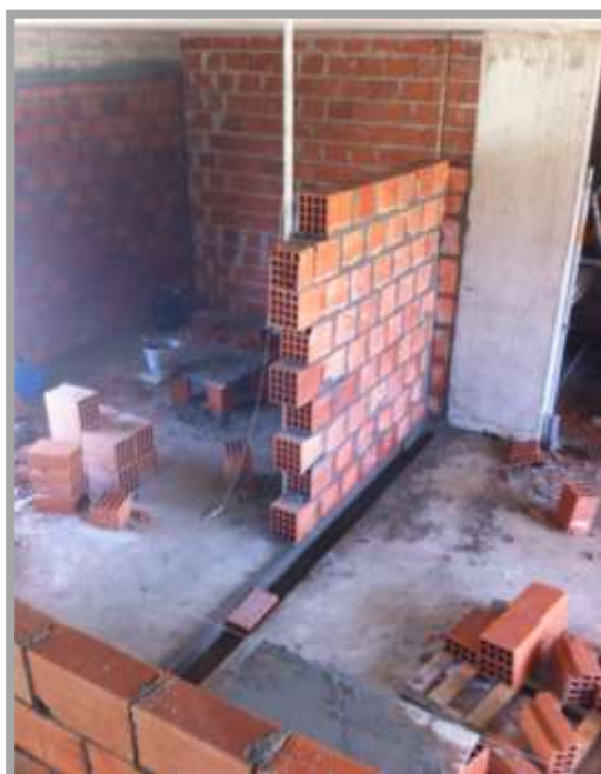
Fig. 202-Execução da parede
