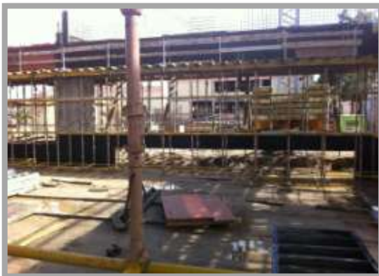
Fig. 44-Execução da viga de bordadura
