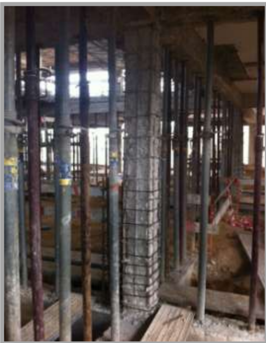
Fig. 47-Escarificação de pilares
