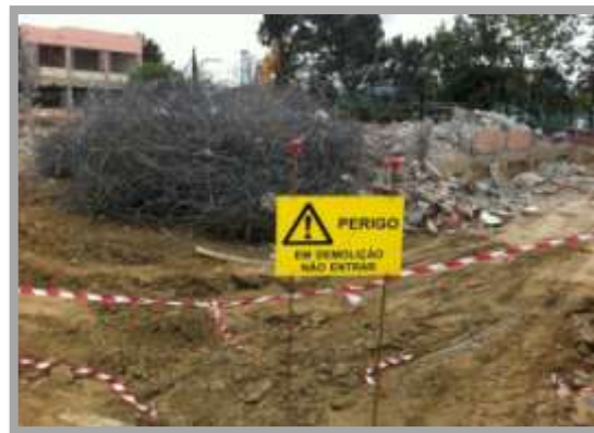
Fig. 96-Demolição bloco B
