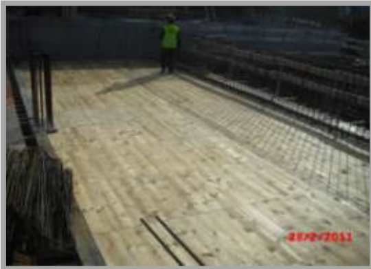
Fig. 117- Cofragem de laje de betão à vista
