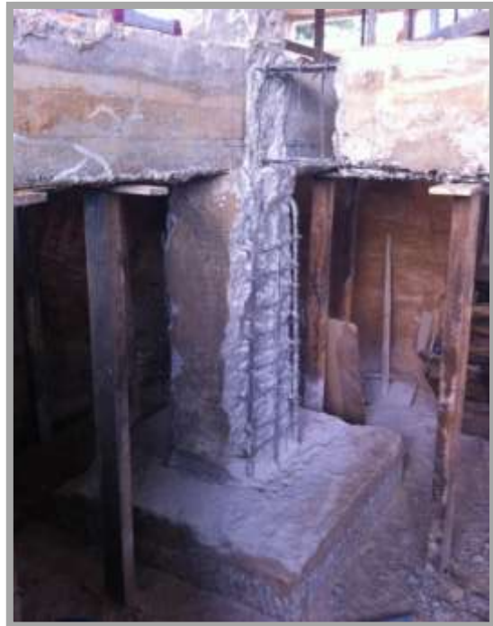
Fig. 88-Escarificação do pelintra
