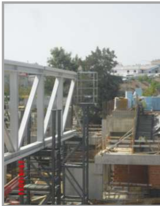
Fig. 177-Pormenor dos pilares de montagem
