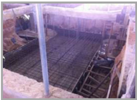
Fig. 81-Armação da sapata bloco C
