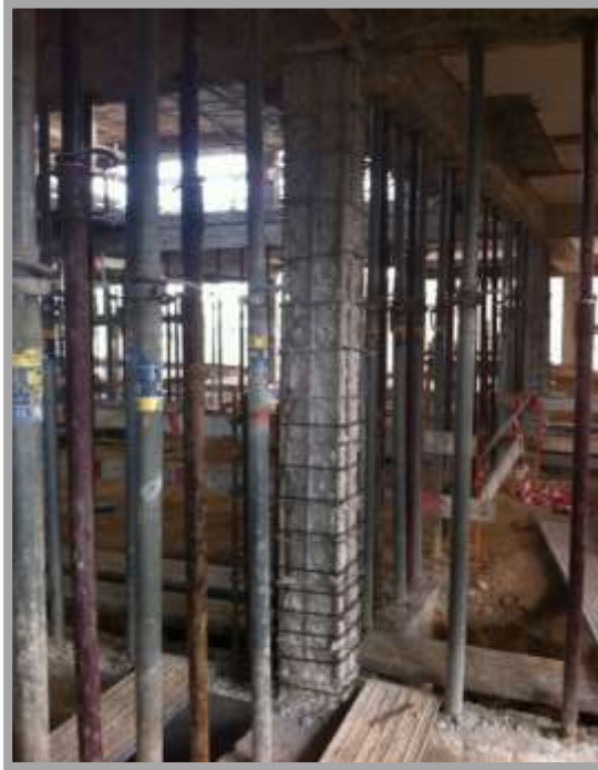
Fig. 87-Escarificação do pilar
