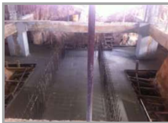
Fig. 83-Betonagem da sapata bloco C
