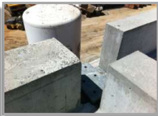
Fig. 165-Pormenor do apoio da estrutura metálica
