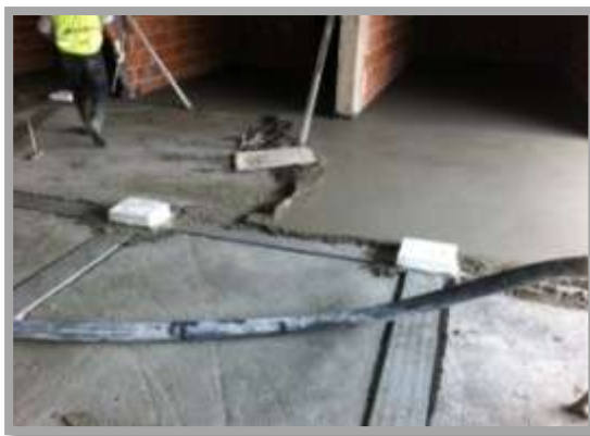
Fig. 225-Execução de betonilha
