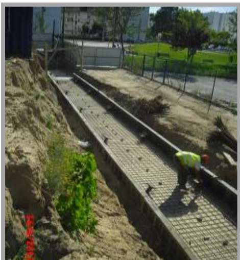
Fig. 182-Execução da sapata corrida
