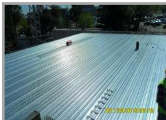
Fig. 159-Colocação de chapa colaborante
