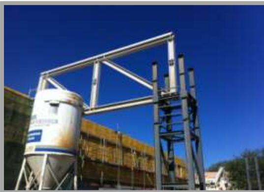
Fig. 166-Início da montagem da estrutura metálica.
