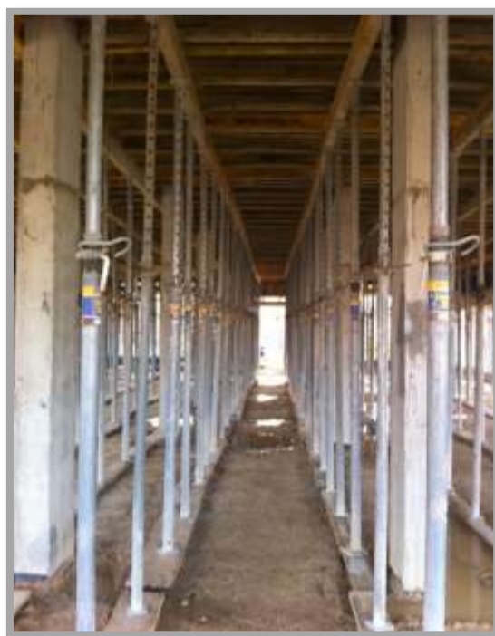
Fig. 149- Escoramento de laje fungiforme
