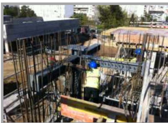
Fig. 164-Colocação dos perfis HEM240.
