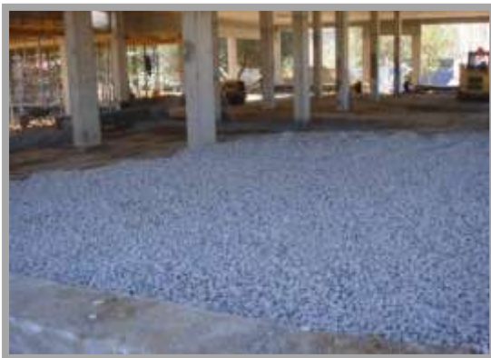
Fig. 190-Colocação de brita
