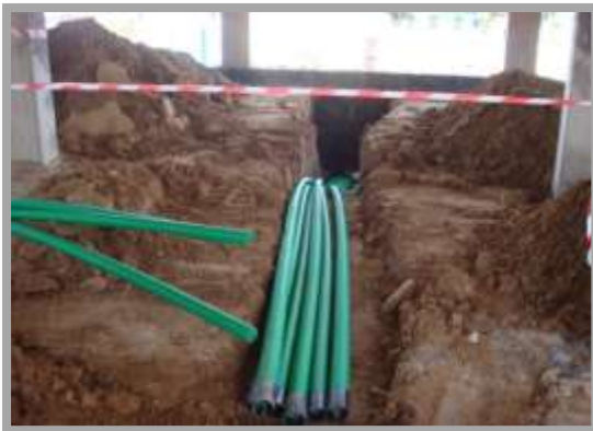
Fig. 188-Execução das infras
