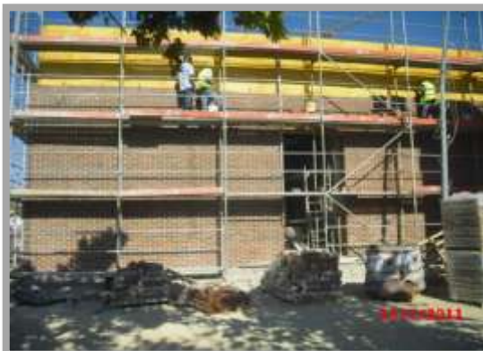
Fig. 234- Execução da parede de tijolo “klinker”
