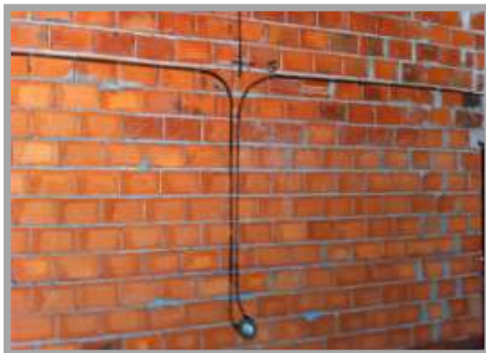
Fig. 209-Marcação de roços
