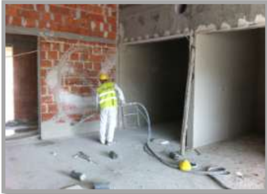
Fig. 221-Execução de estuque
