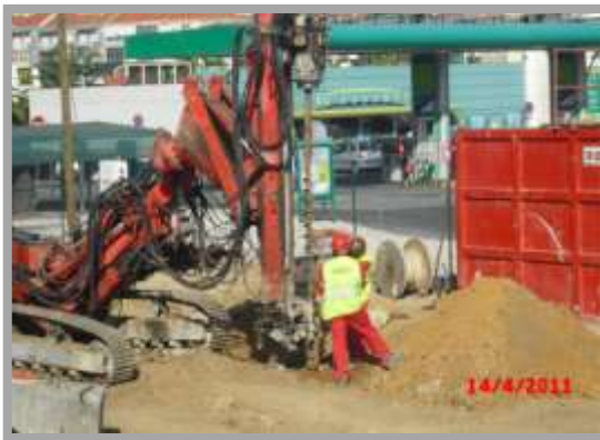
Fig. 180-Execução de micro-estacas
