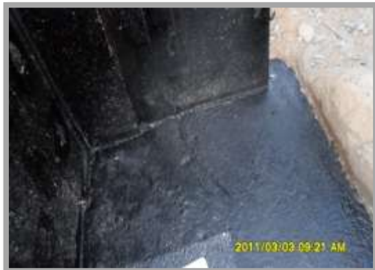
Fig. 138- Pintura betuminosa nos elementos enterrados
