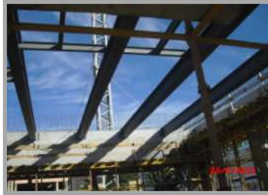
Fig. 155-Colocação dos perfis HEA500
