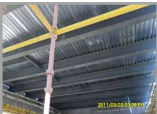
Fig. 158-Colocação de chapa colaborante
