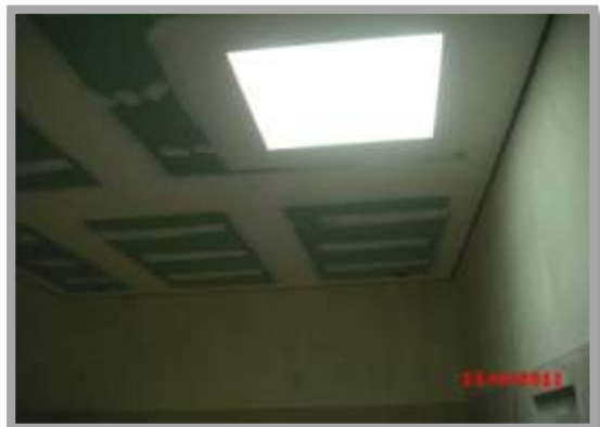
Fig. 231-Execução tecto falso
