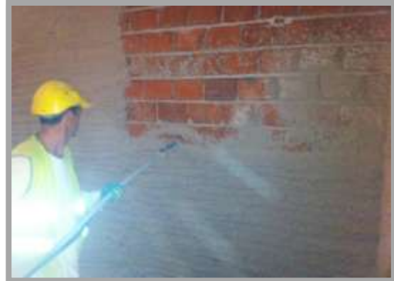
Fig. 222-Execução de estuque
