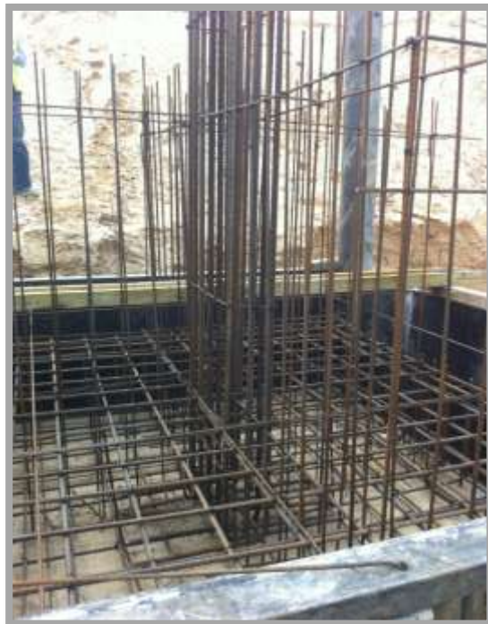
Fig. 131-Pormenor do arranque dos pilares
