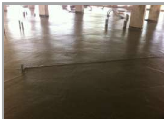
Fig. 199-Execução de betão leve
