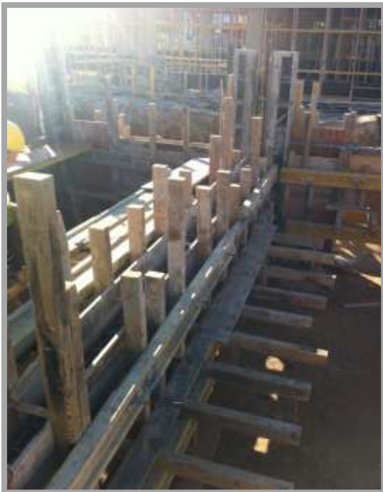
Fig. 113-Cofragem de vigas de fundação
