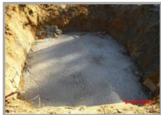
Fig. 123-Execução de pegão
