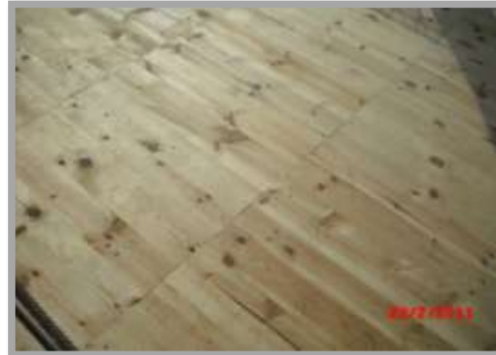
Fig. 118- Cofragem de laje de betão à vista
