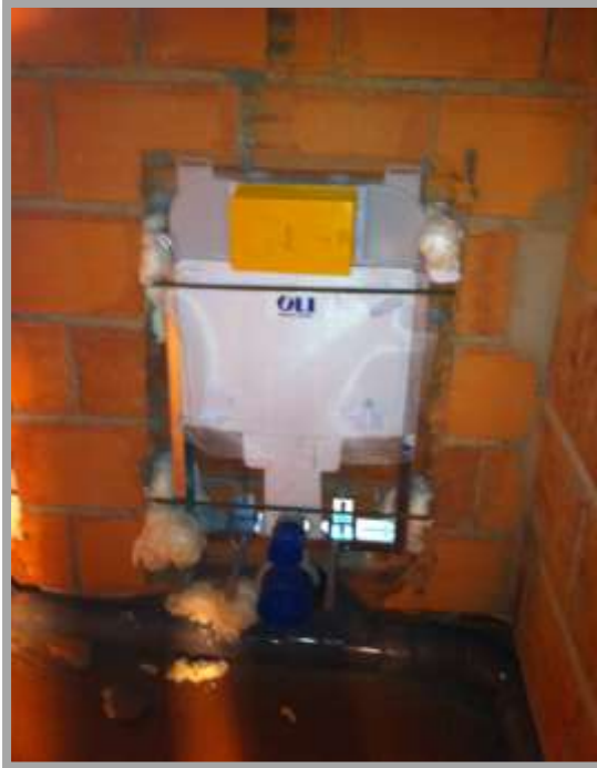
Fig. 213-Execução de autoclismo embutido.
