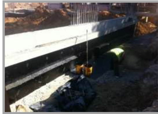
Fig. 137- Pintura betuminosa nos elementos enterrados
