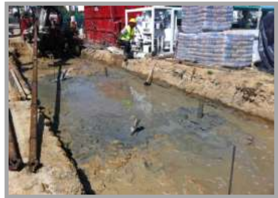
Fig. 181-Execução de micro-estacas
