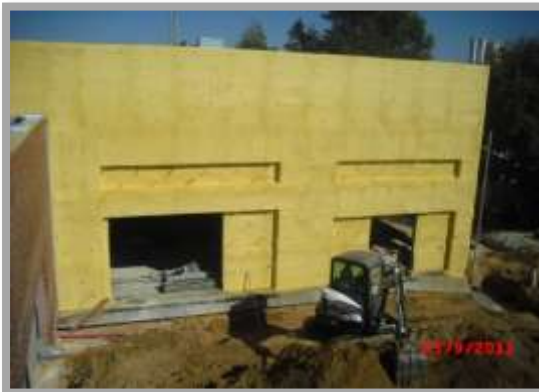
Fig. 232-Execução do poliuretano projectado.
