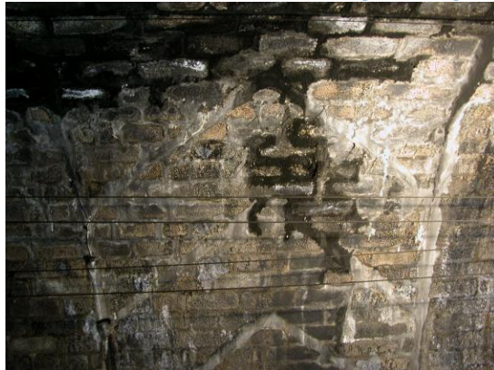
Ilustração 11 - Canaletes externos radiais e em “árvore” de drenagem das águas entre os 460m e os 520m.
