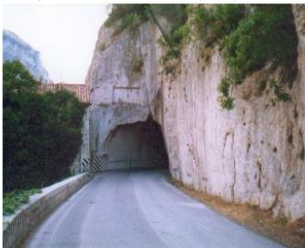
Ilustração 1 - Túnel sob o Monte Posilipo (Nápoles, Itália).
