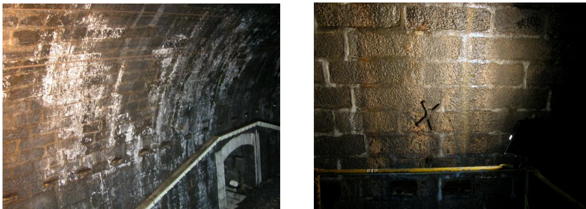
Ilustração 10 - Infiltrações com profusão de musgos, estalactites e água perto da Boca de Saída.
