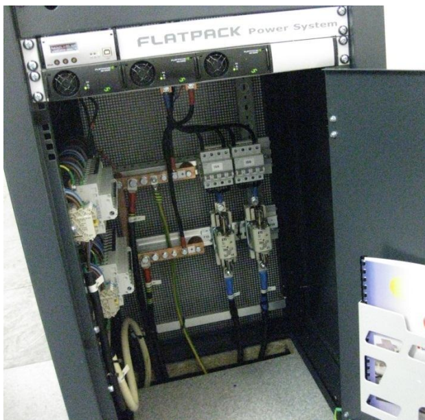
Figura 28 - Interior de um transformador - Edifício Sede EDP em Coimbra
